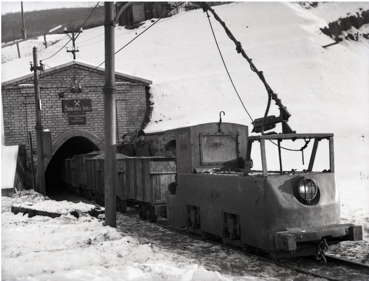
Elektrická trakcia štátnych baní v štôlni Šrobárka zavedená počas prvej svetovej vojny.
