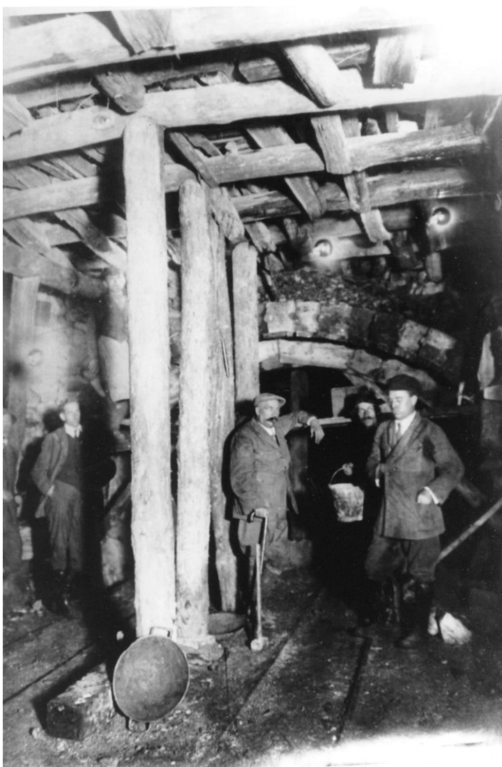
Výdrev hornosirkovskej štôľne pred výmurovkou
