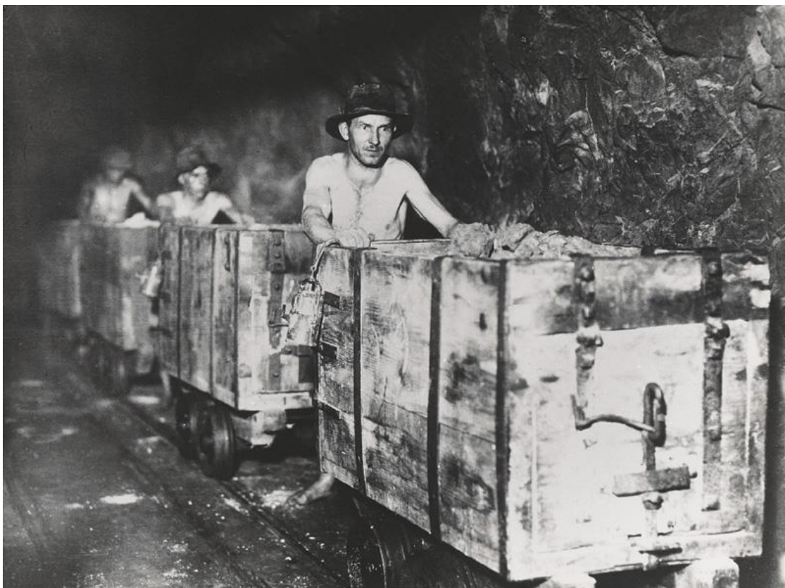
V 19. storočí nastupuje modernizácia horizontálnej dopravy zavedením koľajovej dopravy. Spočiatku sú vozíky tlačené manuálne.
