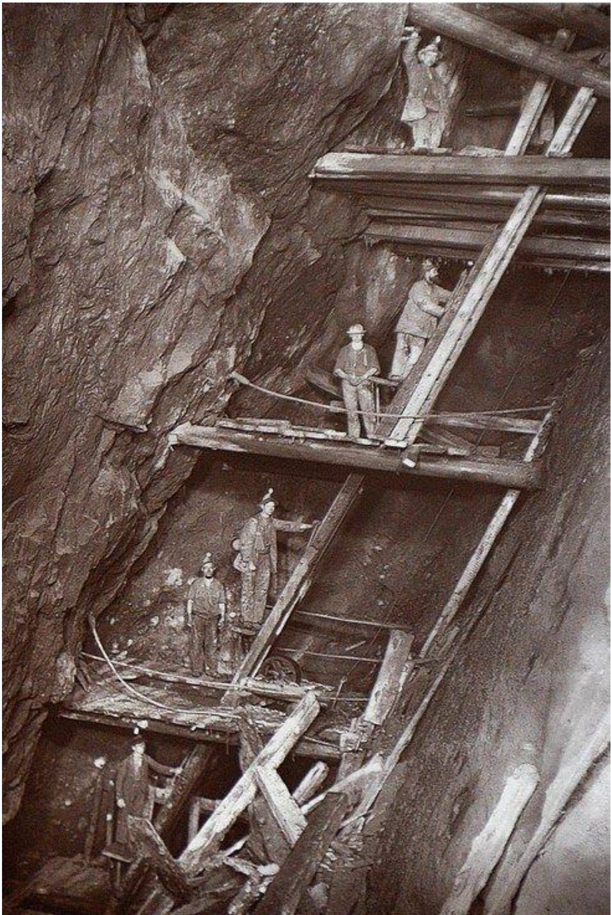
Ťažba výstupkovou metódou na niekoľkých plošinách medzi obzormi.
