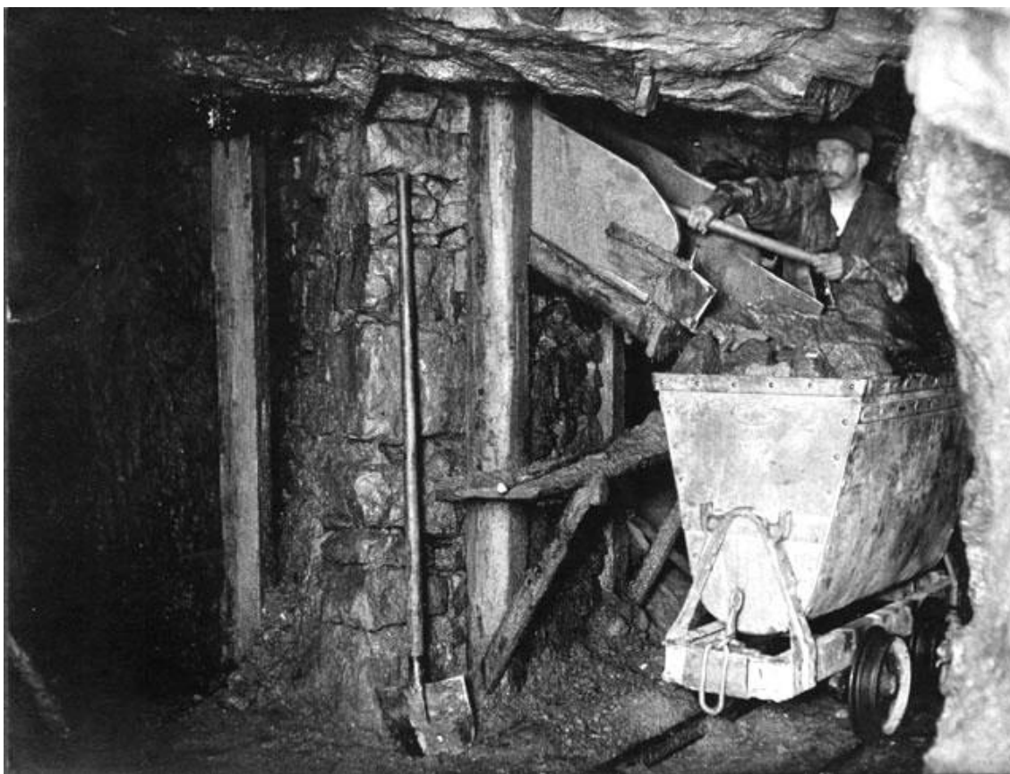
Plnenie hutníkov cez sýp spájajúci vyšší obzor, kde sa vykonávala dobývka.
