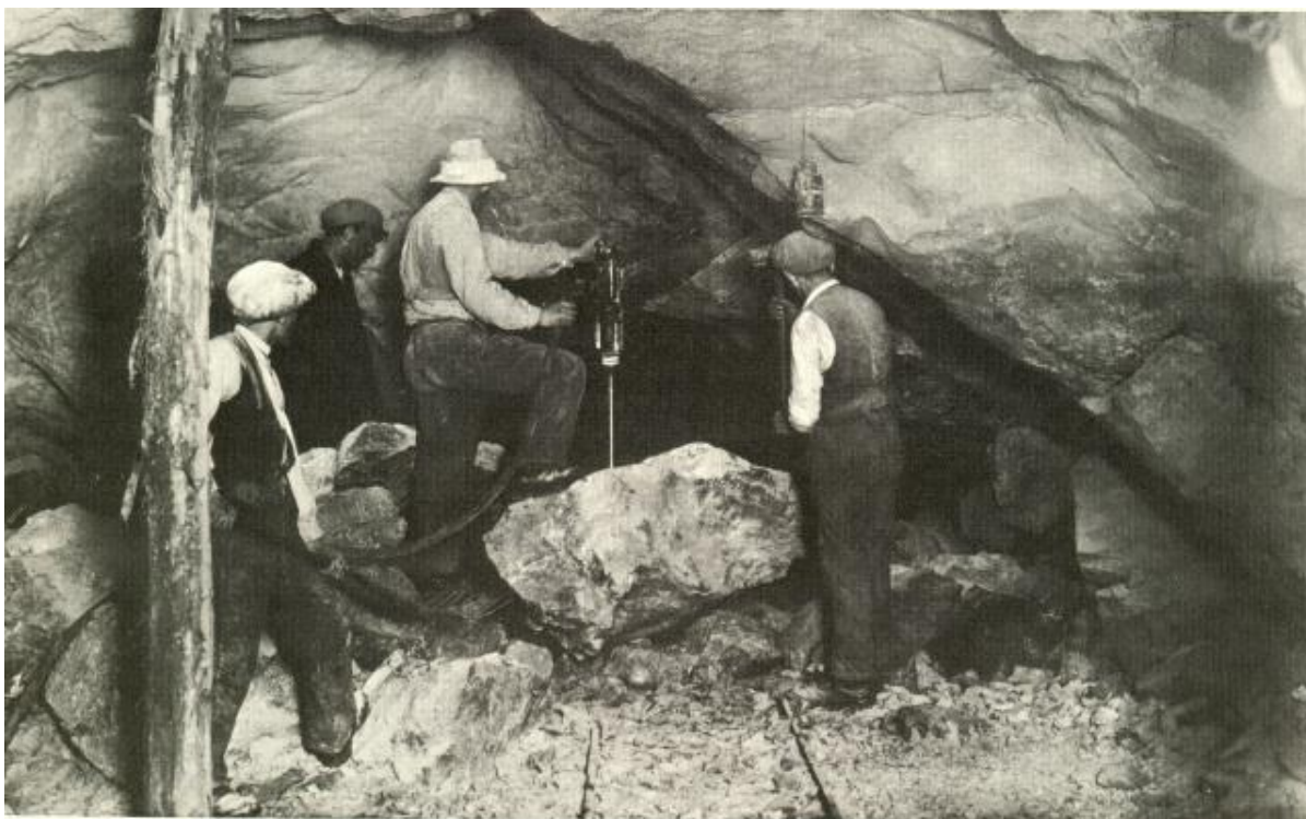
Rozpojovanie horniny trhavinami sa hojne používalo aj v Železníku.
