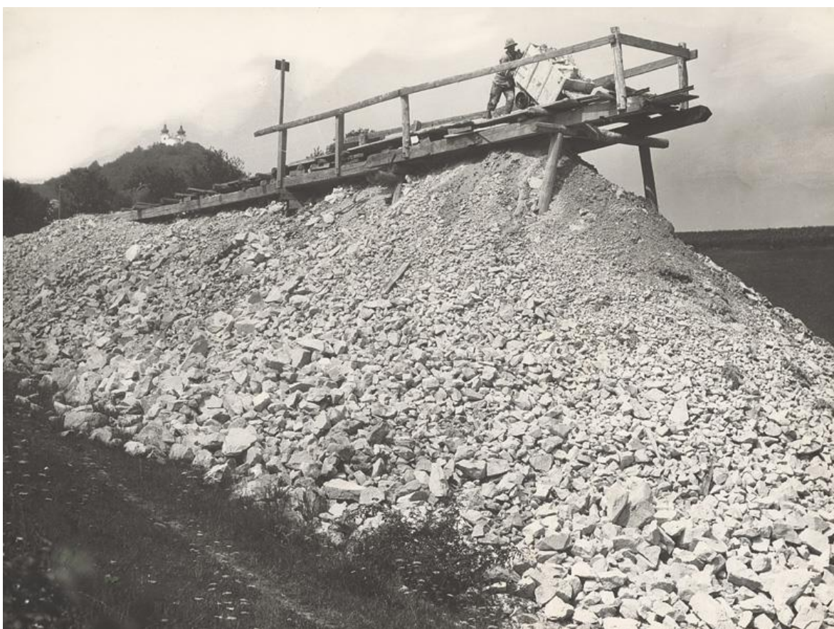
Rampa na halde pred baňou slúžila na vysýpanie hlušiny.
