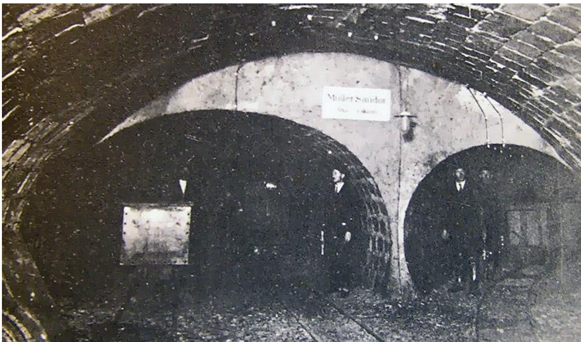
Podzemie Hornosirkovskej štôľne s odbočkou pred slepou šachtou po betónovej výmurovke.
