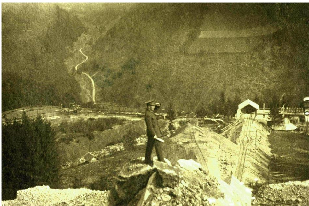
Vysýpná stanica lanovky Tisovec-Grilka vysokopecnej trosky aj s dráhou pozemnej lanovky na jej vrchol dole s násypníkom vápenca pre vysokú pec na spiatočnej ceste.
