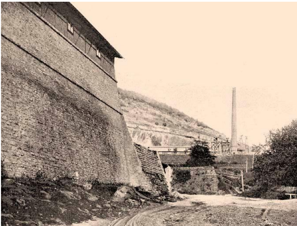
Pohľad na prijímaciu stanicu lanovky v Tisovci od prístupovej cesty. V pozadí rovina zvršku železničnej trate do Jesenského a za ňou podpery lanovej dráhy a komín vápenky.
