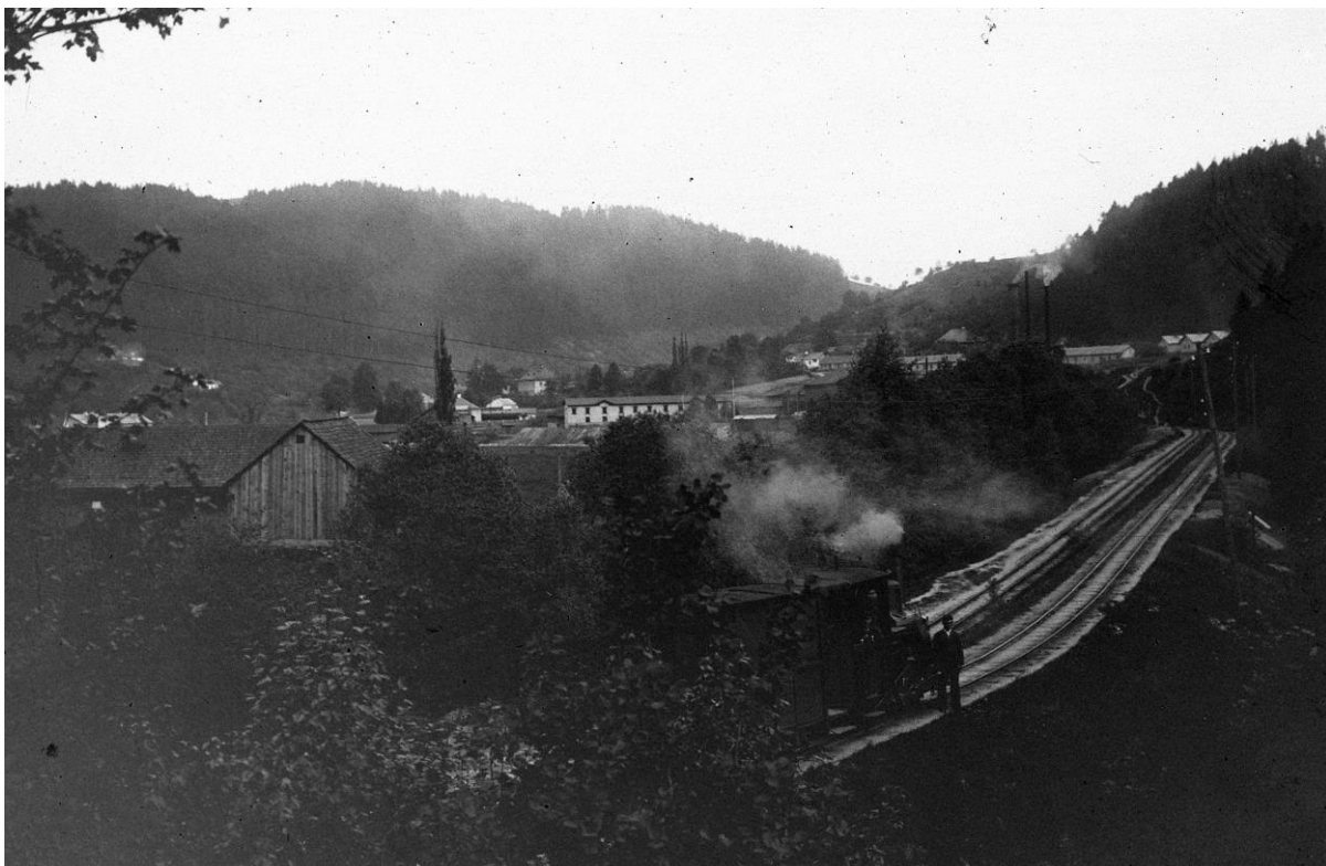
Úzkorozchodná fabrická železnička s rušňom výrobcu Kachelmanových strojární a zlievárni vo Vyhniach v čele vlaku smerom do Hronca. V pozadí zlieváreň a smaltovňa, uprostred biela dvojpodlažná administratívna budova. Druhá koľaj vedie do lisovne plechového riadu.
