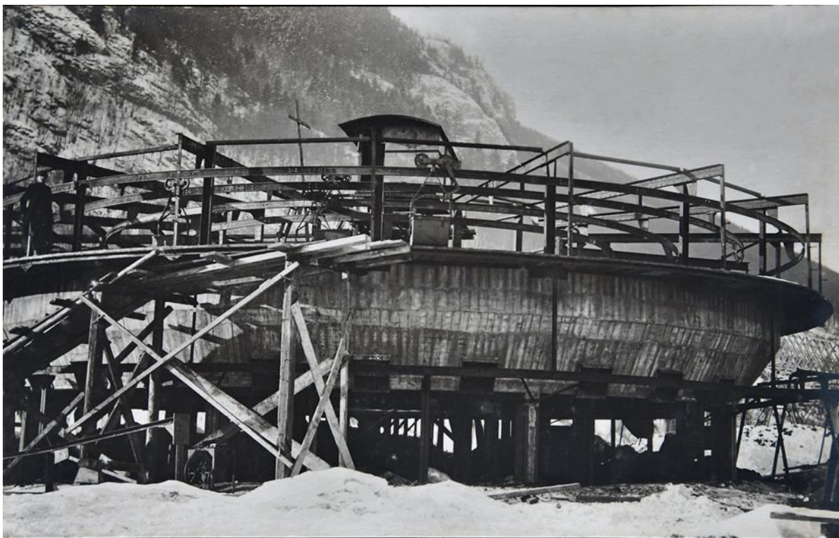
Kruhový (prstencový) zásobník (ešte bez strechy) dovezenej železnej rudy hore s výsypnou dráhou lanovky od prijímacej stanice a dole násypnou dráhou krátkej lanovky k vysokej peci.
