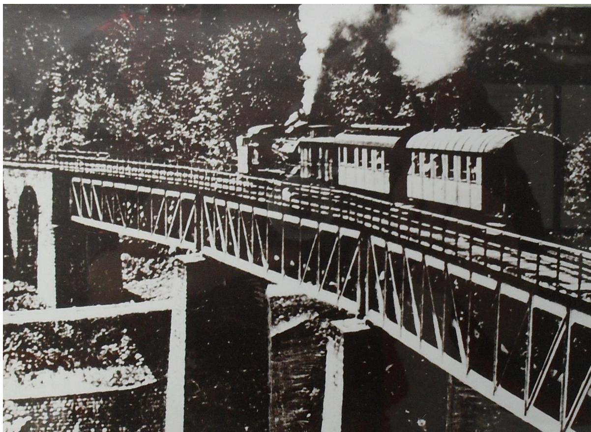
Parný rušeň ozubnicovej železnice tlačí osobný vlak po viadukte Dielik.
