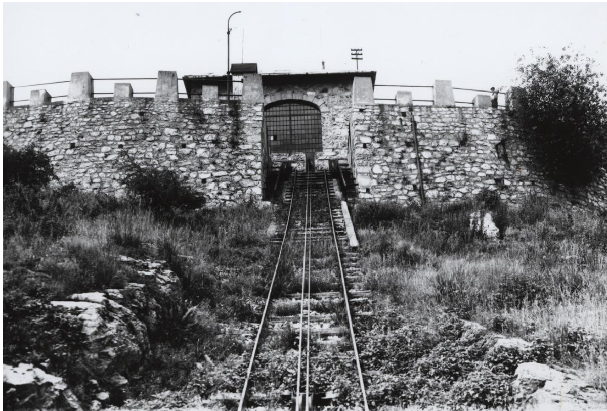
Horná stanica jednokoľajovej pozemnej lanovky so strojovňou. Medzi koľajami sa nachádzajú kladky a dvojica ťažných oceľových lán.
