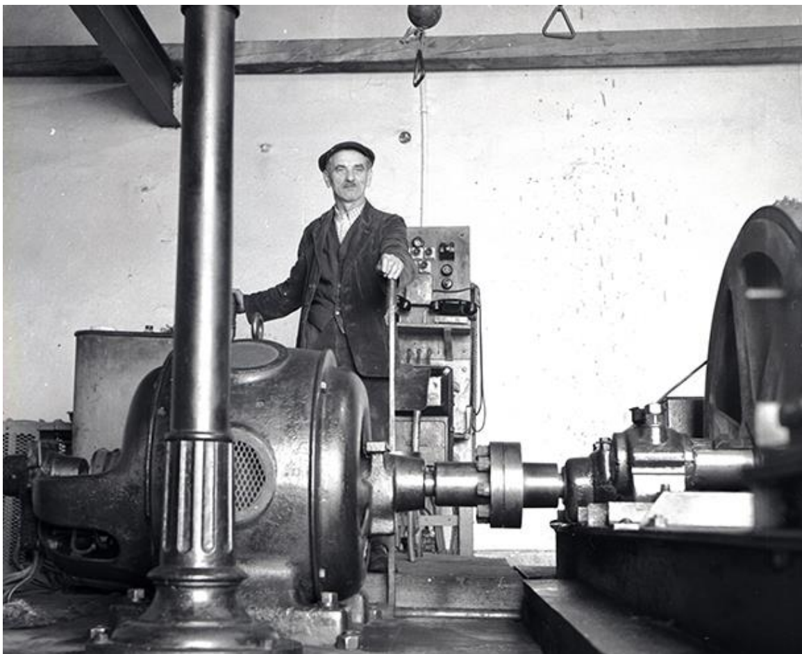
Obsluha strojovne pozemnej lanovky alebo po domácky šikmý výťah Šiklov.
