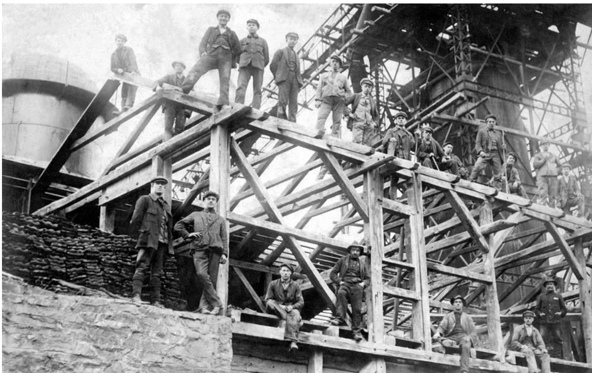
Stavba troskovej lanovky od vysokej pece na kopec Grilka ešte s hrazdenou strojovňou.
