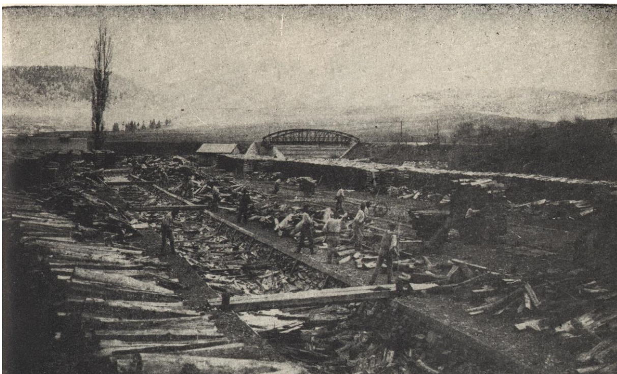
Plavebné kanály už bez vody plné kľuftového dreva robotníci vyťahujú a ukladajú do šichtúňov. Lávky cez kanál sa opäť založia zvislými žrdami nazývané hrablice a druhý deň môže plavačka pokračovať, pokiaľ sa všetko nachystané drevo za niekoľko týždňov nesplaví.
