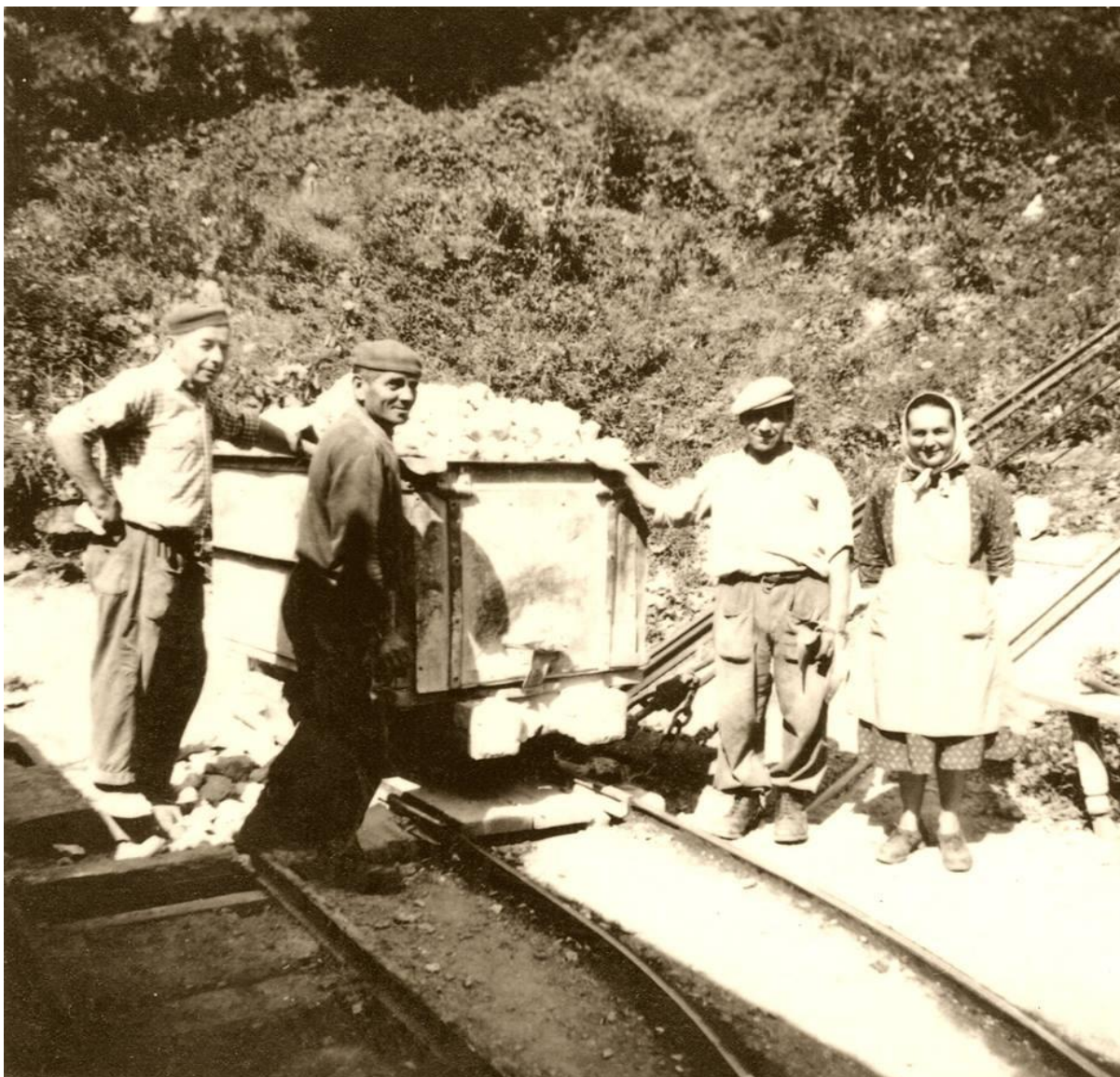
Dolná stanica pozemnej lanovky na zväžnici kameňolomu v Tisovci s vozíkom železničky prepravujúcim vyťažený vápenec do drvičky a sklad vápenca pre vápenku alebo hutu.
