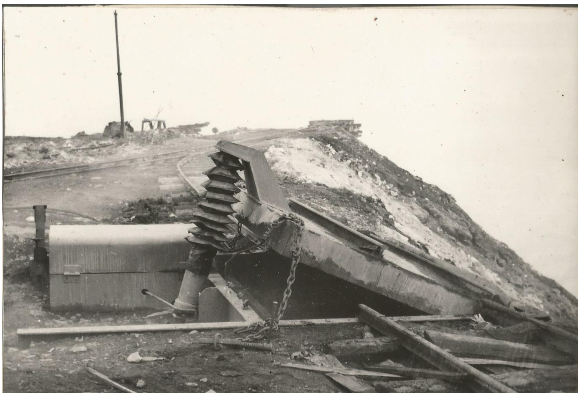
Výsypný mechanizmus železničných vagónikov na halde vrchu Šiklov v 50. rokoch 20. stor.
