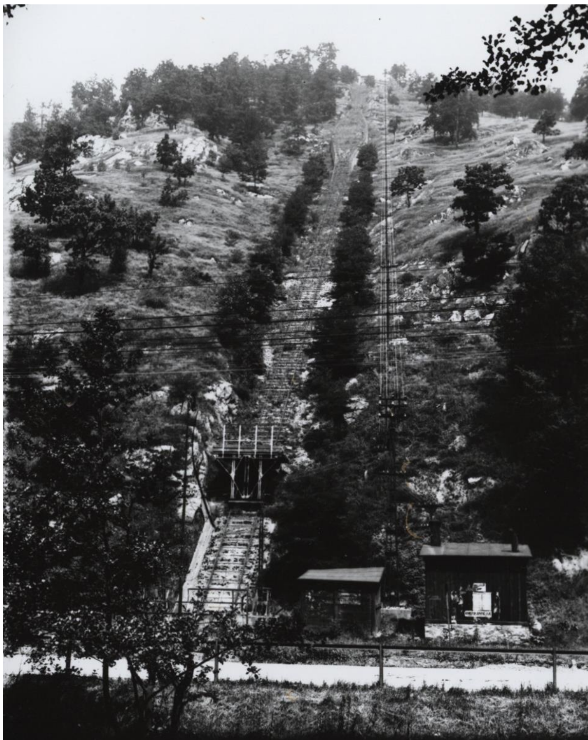
Pozemná lanovka alebo šikmý výťah na vrch Šiklov v Podbrezovej. V popredí štátna cesta Banská Bystrica – Brezno a za ňou viedla súbežne fabrická úzkorozchodná železnica. Súbežne s koľajami výťahu je elektrické vedenie pre napájanie elektromotora v strojovni na pohon lanáča. Dva protichodné plošinové vozne lanovky sa stretávali v polovici trate a míňali sa na výhbní samočinne. Prichádzajúci vozeň sa blíži k šachte, aby plošina zastala na úrovni železničky. Plošina obsahovala dve koľaje pre naloženie dvojice výsypných vozňov s troskou. Fotopanorámu trochu rušia vodorovné čiary. Ide o elektrické vedenie vysokého napätia spájajúceho fabrickú rozvodňu s vodnými elektrárnami Lopej, Dubovú a Jasenie.
