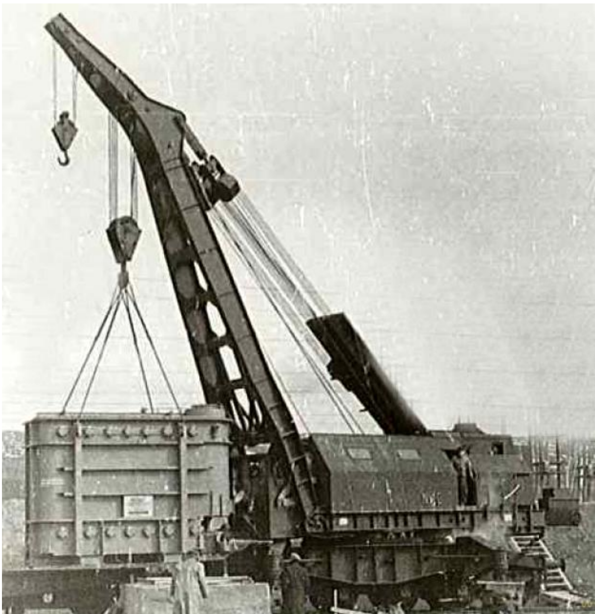
Najsilnejší koľajový parný žeriav „Maco,, zakúpený pre podbrezovskú železiareň. Z bočných dverí nazerá kurič. Neskôr ho nahradil dieselový žeriav s rovnakou nosnosťou 50 ton.
