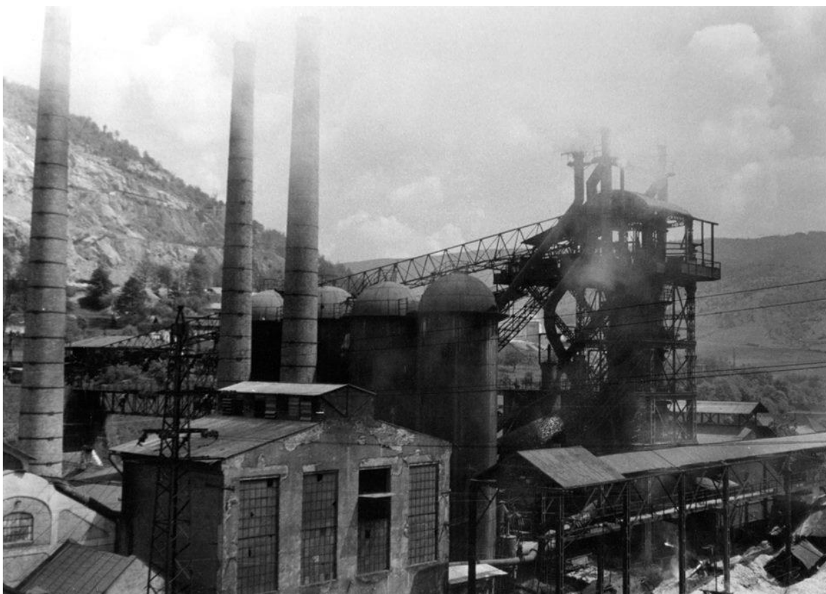
Pohľad na druhú lanovku Tisovec – Grilka. Vpravo dole jej nakladacia stanica a v pozadí šikmá konštrukcia kichtovej tretej lanovky na kichtu vysokej pece z rudného dvora.
