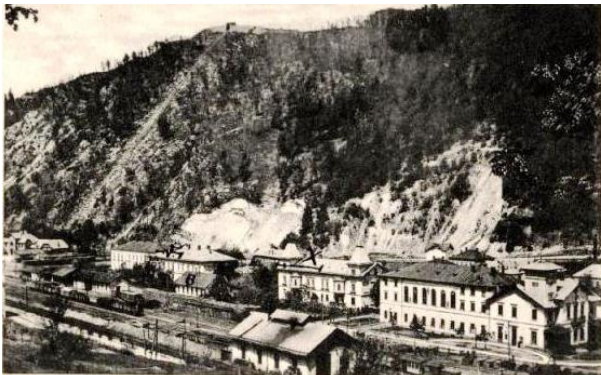
Pohľad na šikmý výťah Šiklov. V popredí železničná stanica a závodný hotel v Podbrezovej.
