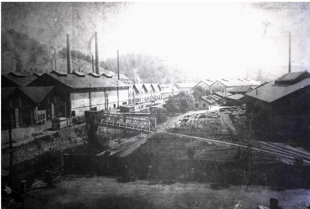
Podbrezová z čias monarchie po prvej prestavbe. V popredí železničný most podnikovej vlečky cez rieku Hron a koľajisko fabrickej úzkorozchodnej železničky. Zľava objekty valcovne, stará valcovňa a v pozadí vpravo nová manessmanova rúroveň, celkom vpravo sklad rúr a za ním plechový komín podnikovej tehelne žiaruvzdorných tehál.
