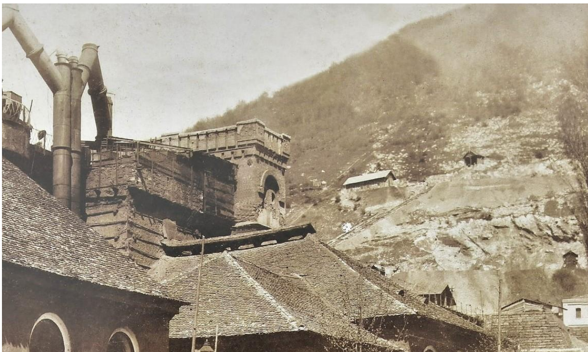
Druhá pozemná lanovka v Tisovci spájajúca ťažobné obzory vápencového lomu s hutou aj železničnou stanicou.
