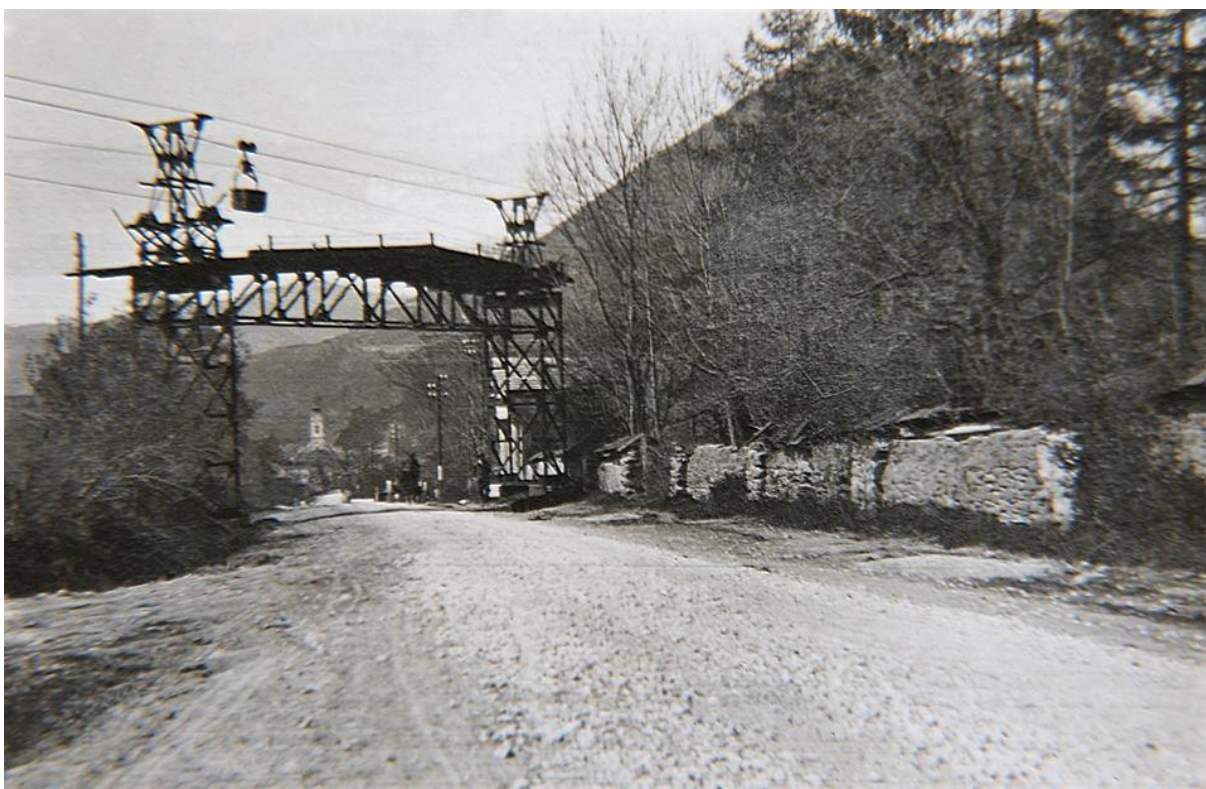
Pri križovaní lanovky s cestami alebo železnicou boli postavené premostenia chrániace pred pádom naloženého substrátu, alebo aj hutníka lanovky.
