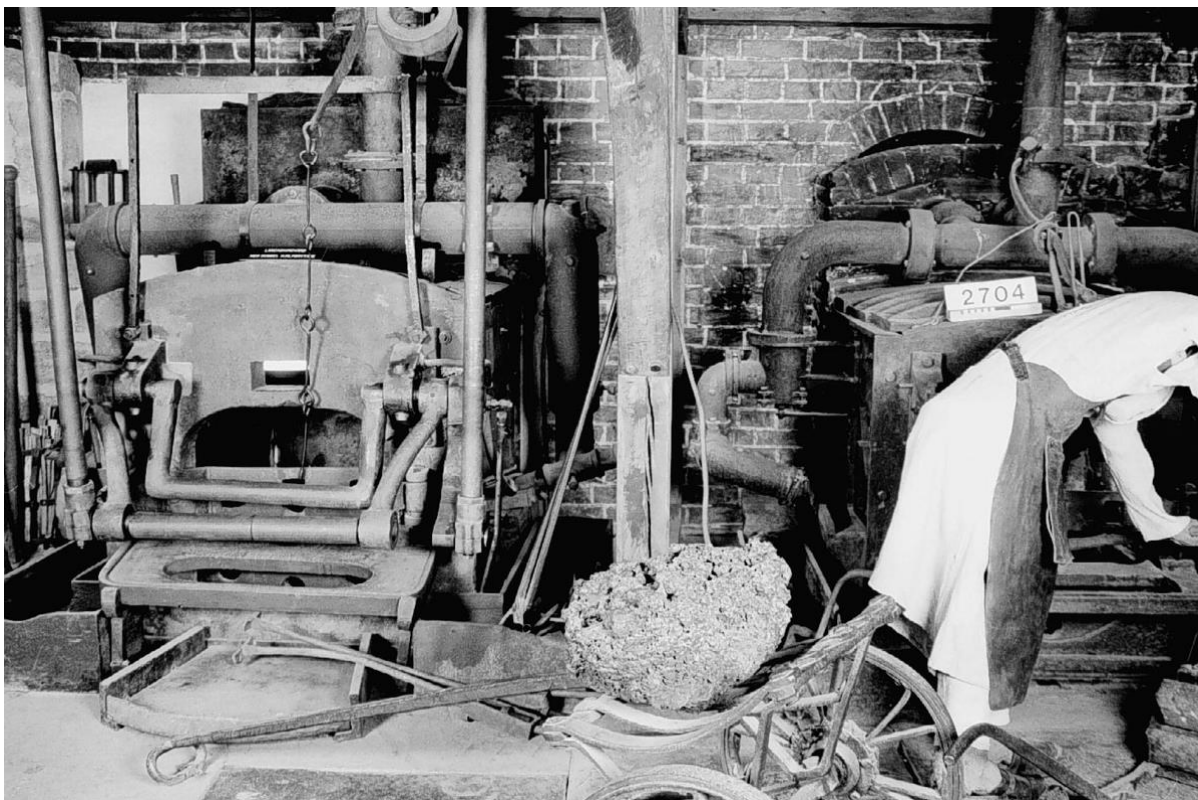
Ilustračné foto podobnej ohrievacej vyhne s protiahlymi výfúčkami privádzanými liatinovým potrubím z komínového priestoru v pozadí za účelom ohrevu vháňaného vzduchu.
