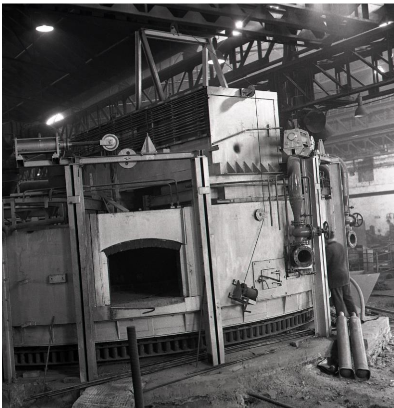
Foto montáže starej karuselovej pece v Podbrezovskej starej rúrovni.
