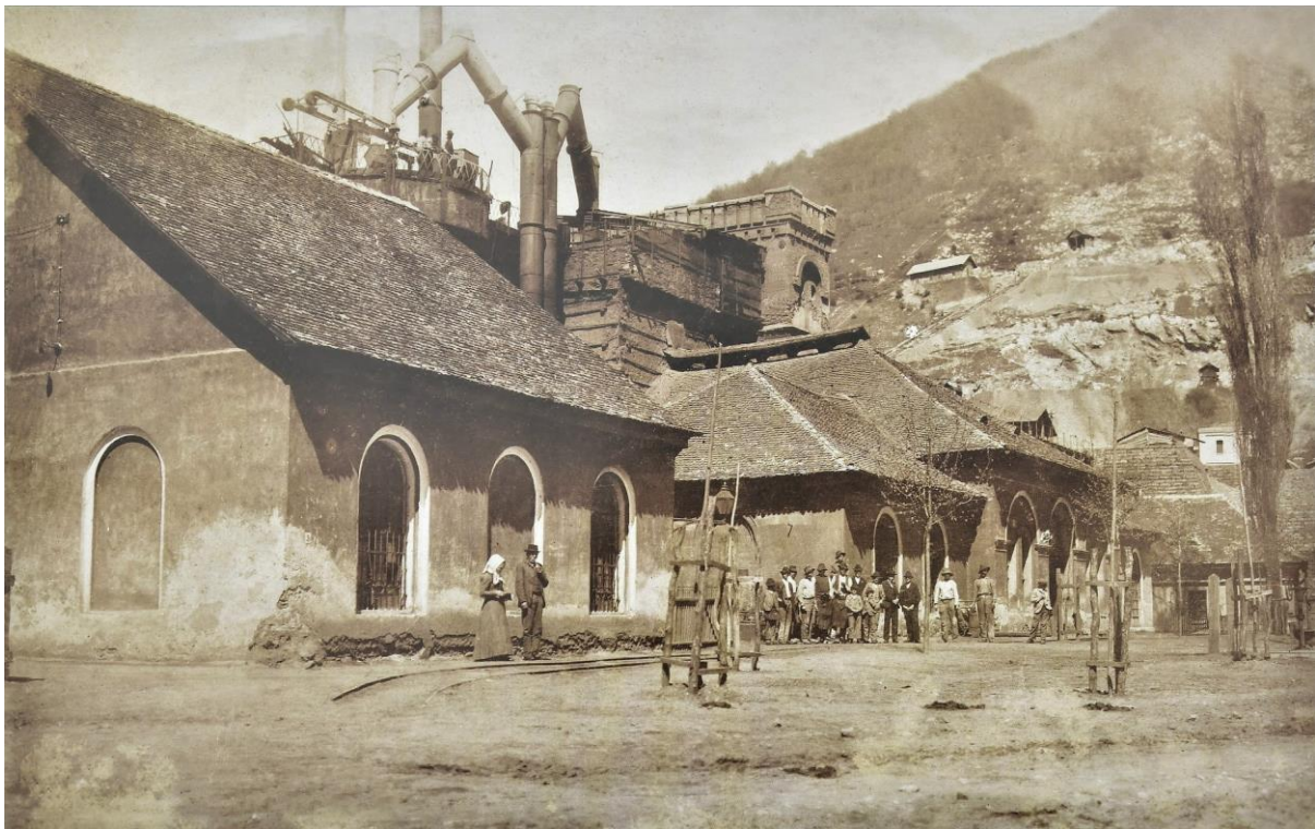
Pohľad na starú hutu po s prvou pilierovou vysokou pecou uprostred. Neskôr k nej postavili druhú (stĺpovú) vysokú pec vľavo a výťahovú vežu (vpravo).
