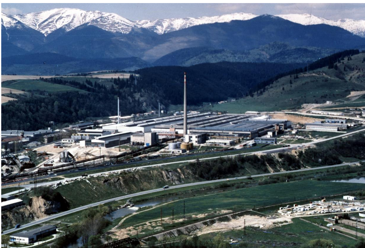
Pohľad na takmer dokončený Nový závod v 80. rokoch 20. storočia.
