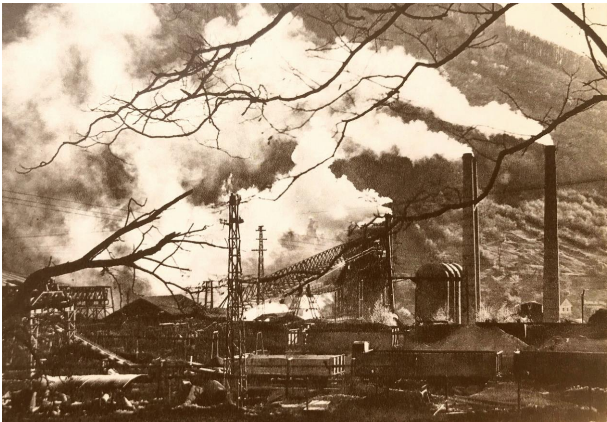
Huta pred zrušením v plnej prevádzke. Vpravo trojica murovaných komínov, pri nich batéria ohrievačov vetra a uprostred vysoká pec s kychťovou lanovou dráhou z hutného dvora. Celkom vľavo portálový žeriav po zrušení prenesený do Švermových železiarní na RP sklady.
