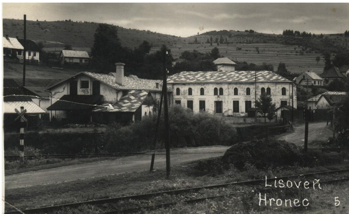
Pohľad na lisovňu plechového riadu v medzivojnovom období. Celkom vľavo plechový komín od žihacej pece, uprostred nad strechou lisovne obytný dom prestavaný z bývalej vážnice. V popredí štátna železnica a železničné priecestie lesnej úzkokol'ajky.
