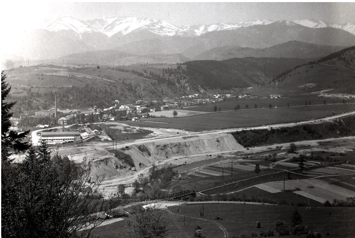
Pohľad z Chvatimechu na zasnežený hrebeň Nízkych Tatier. Uprostred riečna terasa Hrona kde v 60. rokoch začína výstavba Nového závodu. Celkom vľavo RP sklady.
