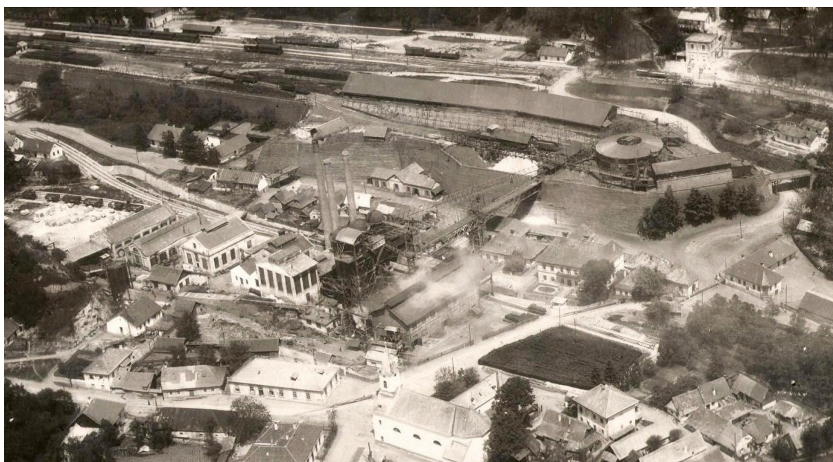
Huta s novou vysokou pecou Lúrmanovej konštrukcie a tromi lanovkami. Celkom vpravo je dlhý objekt prijímacej stanice lanovky Tisovec – Sirk, za ním kruhový zásobník železnej rudy, vedľa vľavo dlhý sklad koksu a vápna. V pozadí železničná stanica s vlečkou pre hutu aj vápenku a vápencový lom. Pred pecou obalenej v nosnej ocelevej konštrukcii odlievacia hala so žeriavovou dráhou a ostatné objekty hute. Pred hutou štátna cesta Brezno – Tisovec a pred ňou bytová zástavba osady Hámor s katolíckym kostolom teraz súčasť Tisovca.
