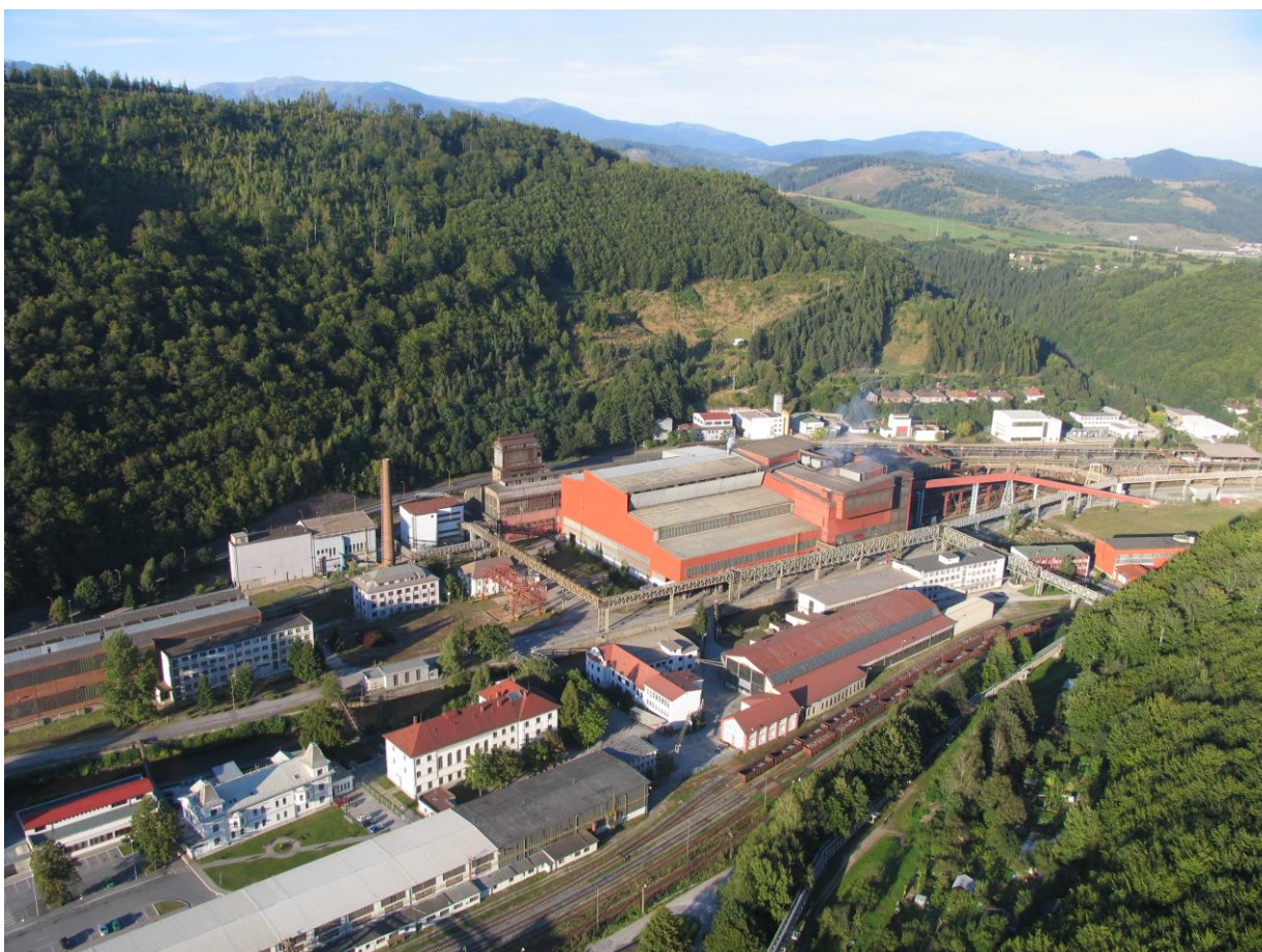
Pohľad na nový elektrooceliareň a ZPO v Podbrezovej.
