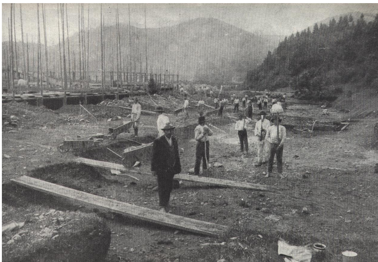
Pohľad na Henriho závod vo výstavbe a výkope nového koryta Bystrianky.
