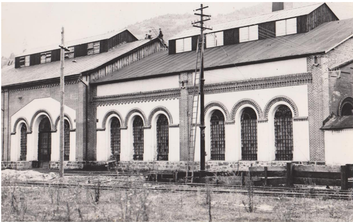
Hala zlievarne po zrušení vysokých pecí z prelomu 19. a 20. storočia. V popredí ocelový stožiar vlastnej výroby elektrického vedenia z 500 m vzdialenej fabrikovej elektrárne v prevádzke lisovňa plechového riadu
