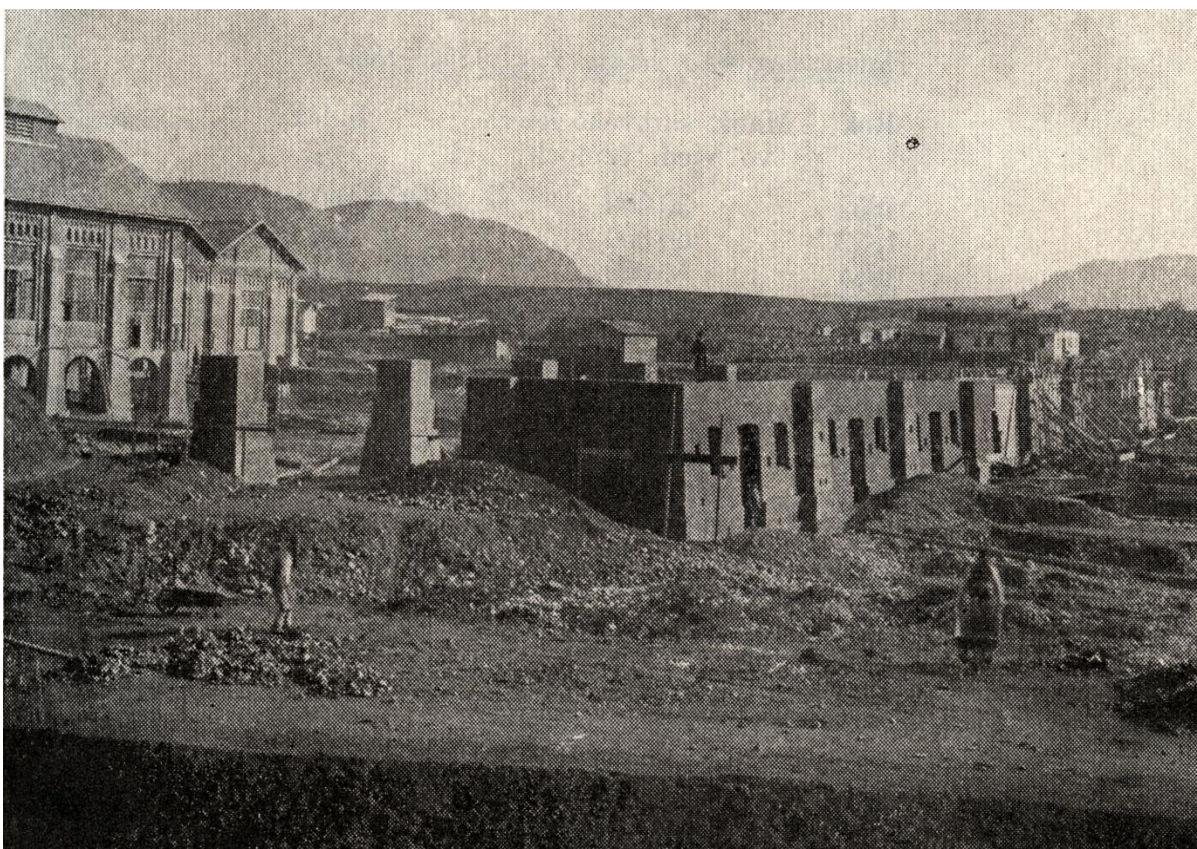
Výstavba veľkej žeriavovej dráhy na Piesku. V popredí dočasný železničný most fabrickej železnice nad pôvodným korytom potoka Bystrá pred jej preložením za výrobné haly.
