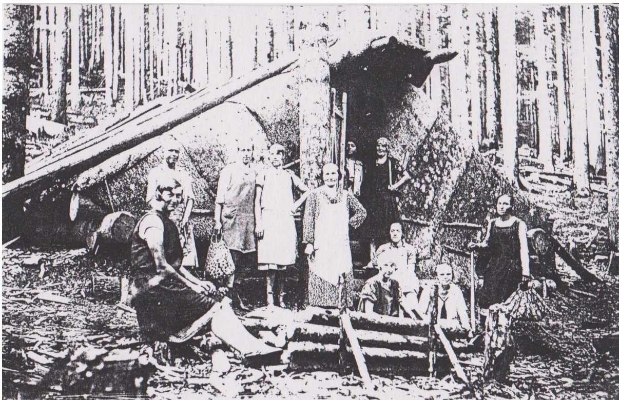
Koliba sa v ľudovom stavitelstve udržala až do začiatku 20. storočia pre turnusové ubytovanie lesných robotníkov na vzdialených lokalitách. Fotka je z Kamenistej doliny.
