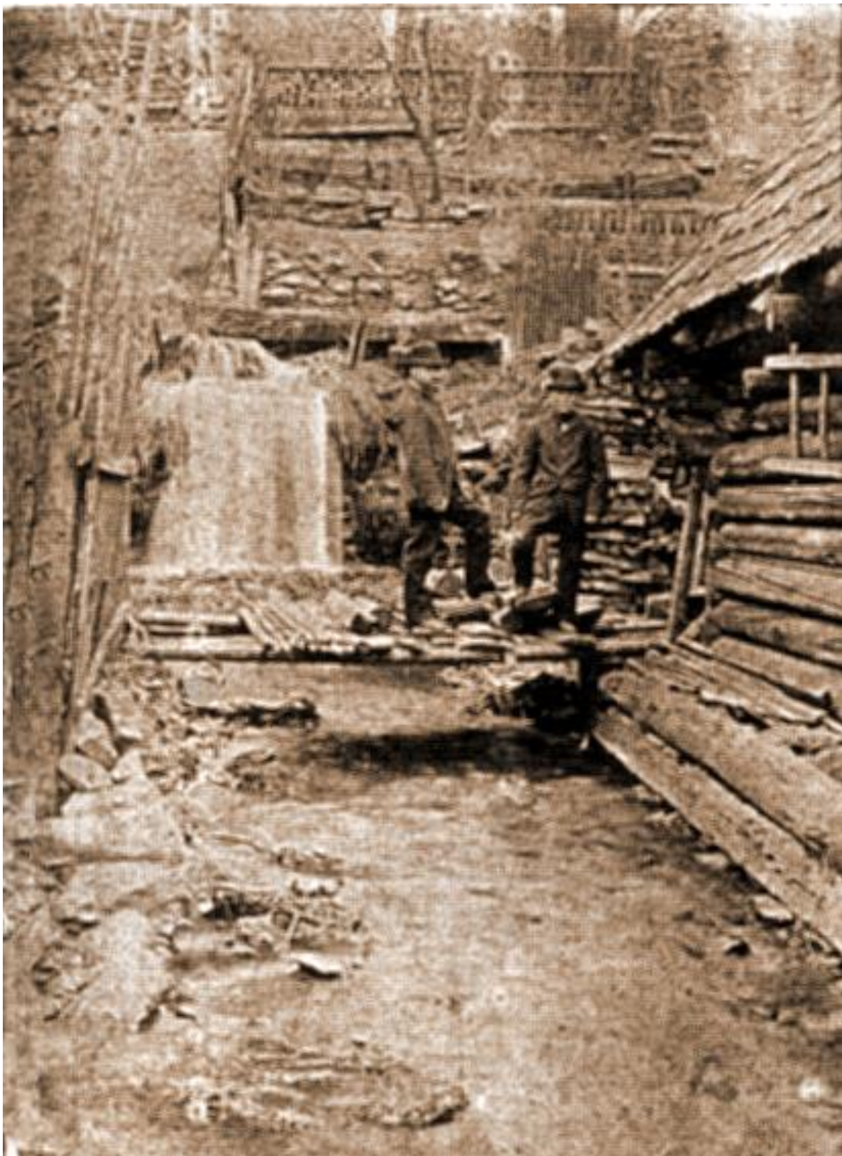
Vodný prepad náhonu (frúdle) medzi maštale a sklady drevného uhlia pre železiareň poniže.
