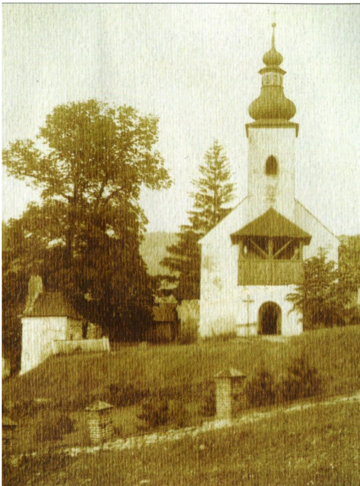
Valaštiansky kostol z r. 1600 bol prvou kamennou stavbou a nachádzal sa v extraviláne osady. Zvonicu ako nový vchod do chrámu božieho postavili Hronecký veriaci spolu s coorom.
