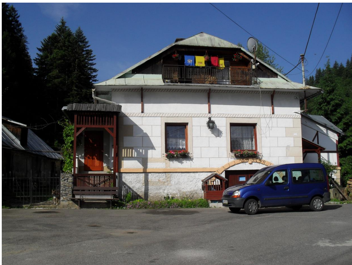
Súčasný vzhľad bývalého komorského mlyna. Vľavo dole pod terajším oknom je vyznačené ostenie pôvodného okna zamurovaného pri prestavbe na byt začiatkom 20. storočia, ďalšie zanikli vložím garážovej brány v roku 1976.
