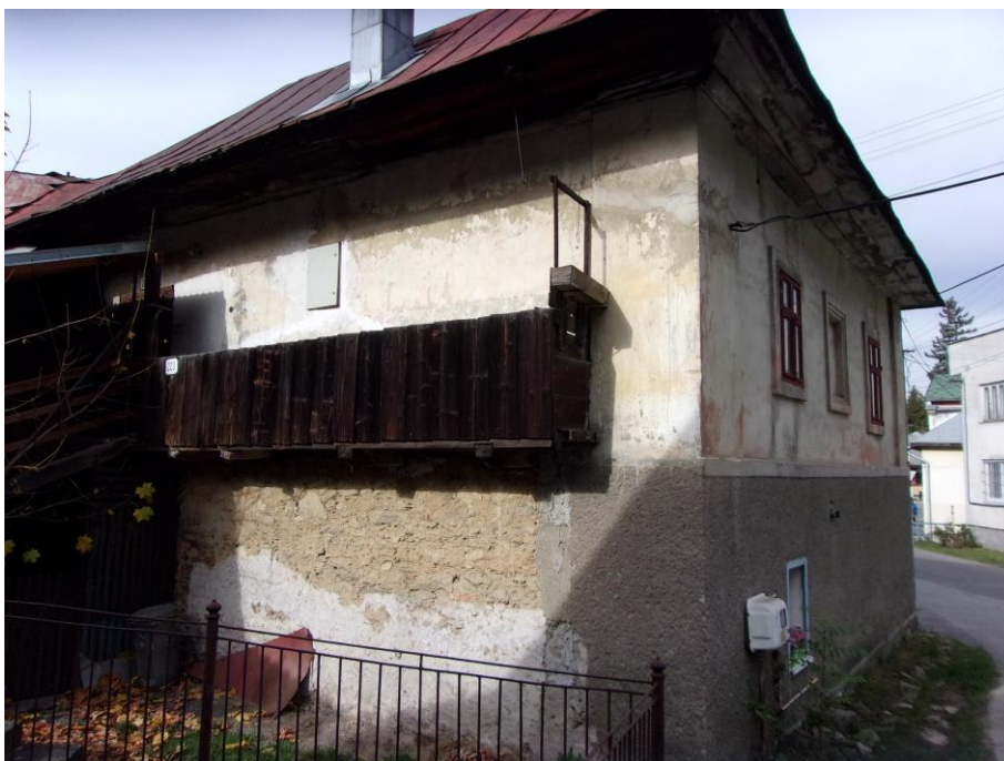
Na mieste zrušenej prvej vysokej pece (1740) v roku 1837 dala komora postaviť dvojpodlažný dom s vonkajšou pavlačou ešte s čiernou kuchyňou ako ubytovňu pre komorských úradníkov.
