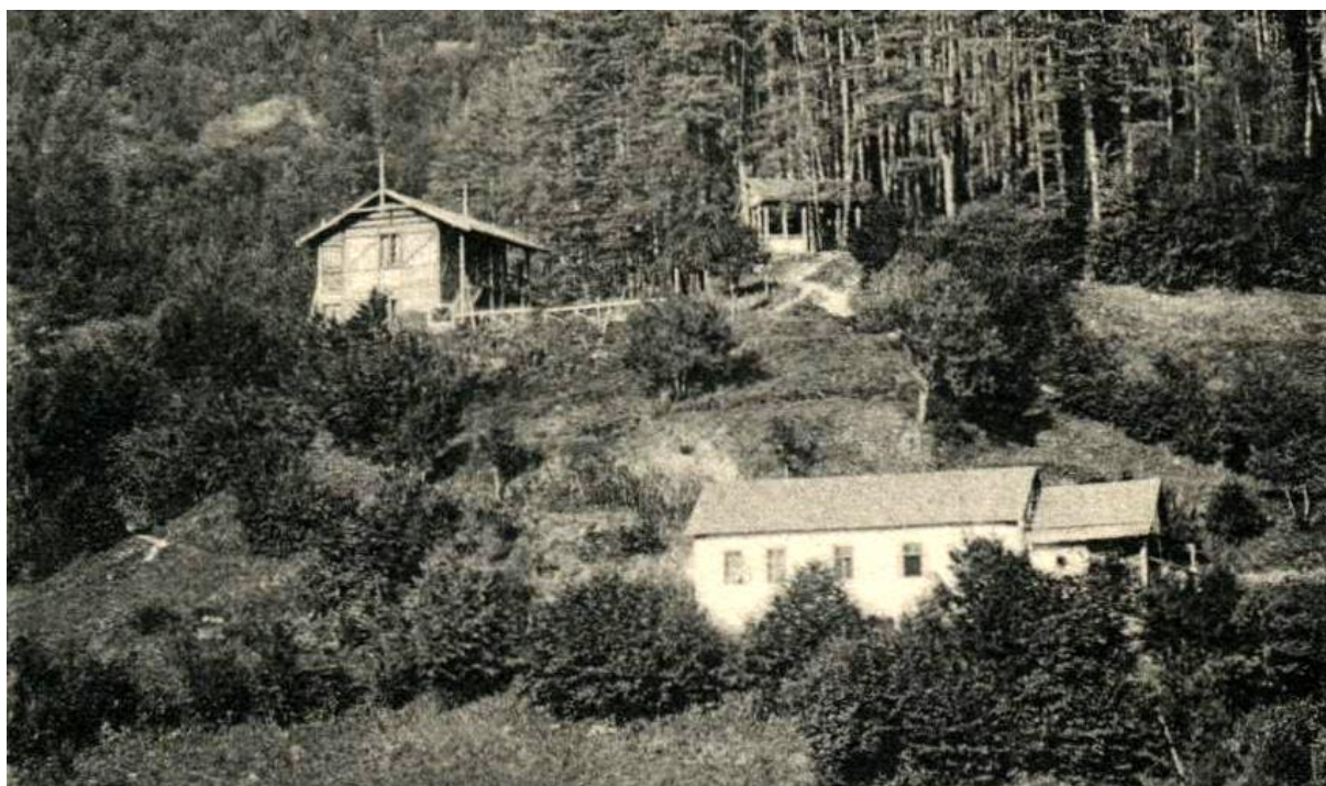
Pohľad na objekt Strelnice s rozostavanou tančiarňou a kolkárňou v lese. Pod nimi obytný dom nad ulicou.
