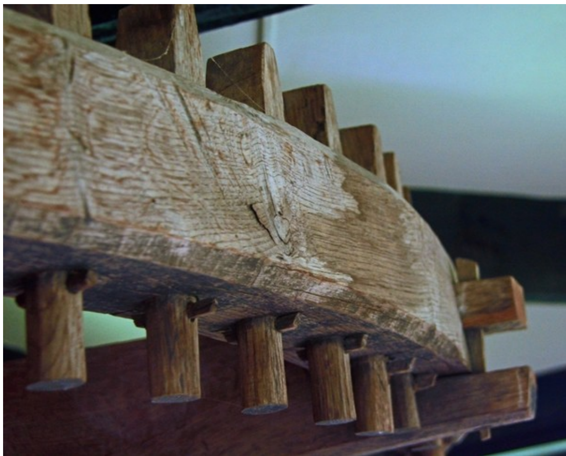
Detail palečného prevodového kolesa. Jeho výroba bola zdĺhavá a preto drahá.
