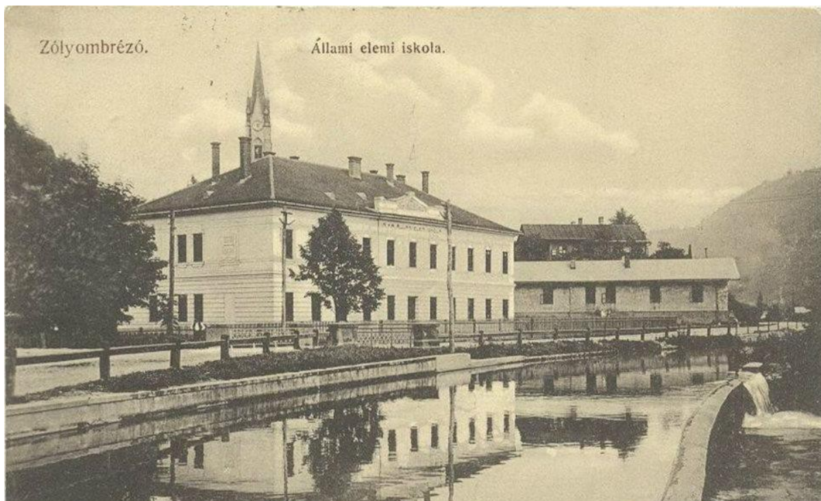
Kanál vodného náhonu pod Brezovou keď sa stala osadou s vlastným kostolom v pozadí. pre hydrocentrálu súbežne s hradskou, v pozadí štátna škola.
