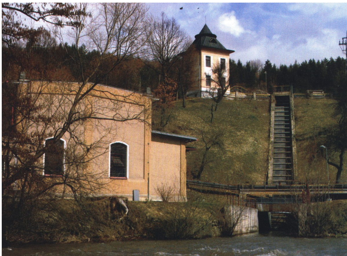
Pohľad na objekt HC Dubová dole, hore je vežový objekt privádzača podzemného tunela a tlakového potrubia s prepádovým žľabom.
