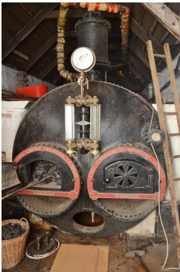
Čelo parného kotla s dvojicou ohnísk s dvierkami na prikladanie, dvojicou vodoznakov uprostred a hore s manometrom. Tento „plamencový“ typ kotla dosahoval účinnosť 70%.
