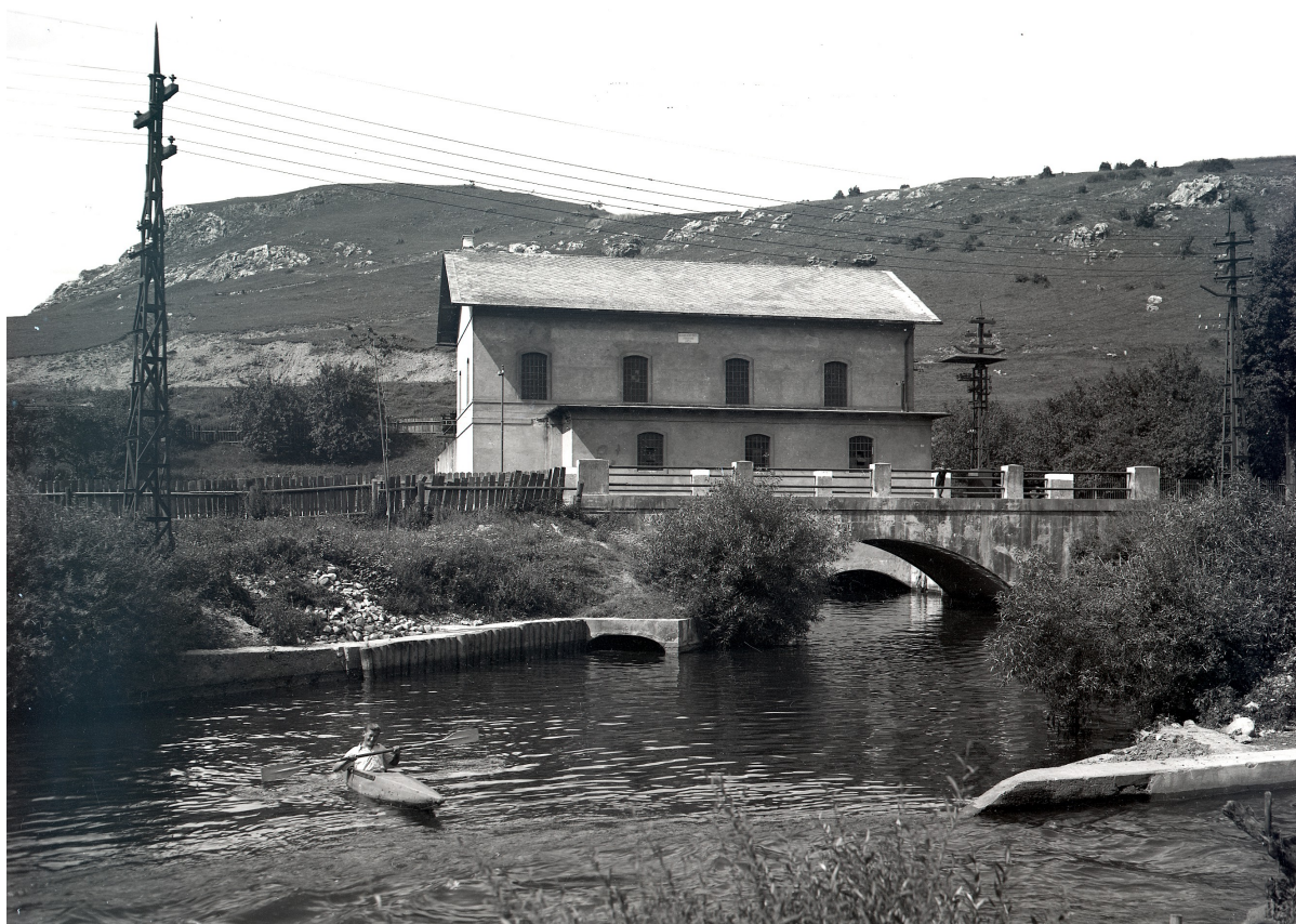
Pohľad na Hydrocentrálu Lopej od Hrona.
