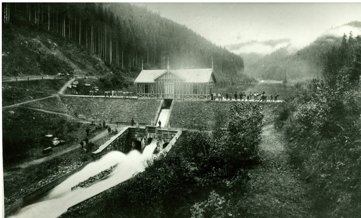
Tajch v Kamenistej doline powyše Hronca pri plnom stave, keď voda odtekala prepadom. Fotograf vystihol moment otvorenia hradiel keď sa začala voda zdrže vypúšťať.
