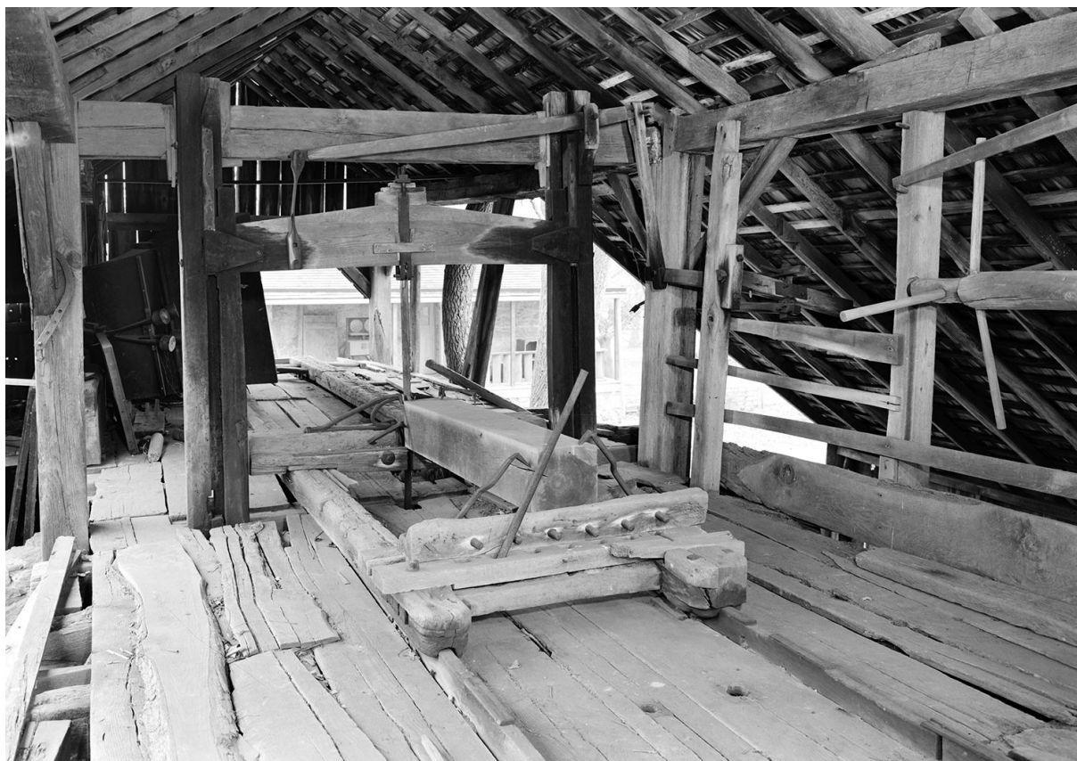
Starúčký interier jednoduchkej dedinskej vodnej pily s jedným pilovým listom.
