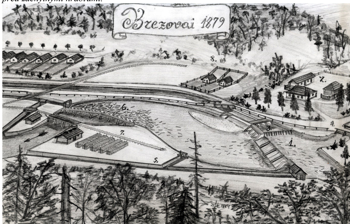
Pohľad na Hať pod Brezovou 1, vodný náhon s hrubými česlicami 3, záchytné hrable 6, priepusť plti 5, sklad kluftového dreva s podnikovou železničkou tlačenu ručne 7, sútok
