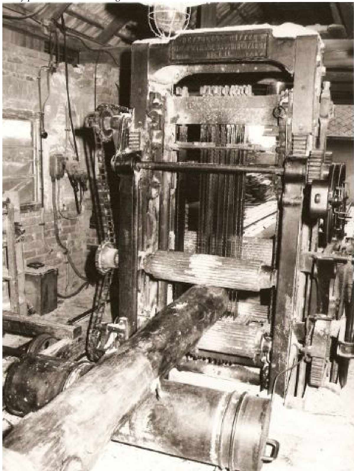
Bočný pohľad na konštrukciu gátra.
