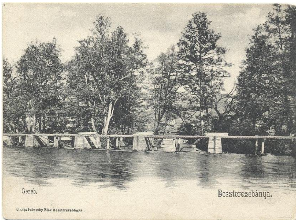
Záchytné hrable na Uhlisku pred Banskou Bystricou. Cieľová stanica plaveného dreva z lesov Čiernohronia a Horehronia.
