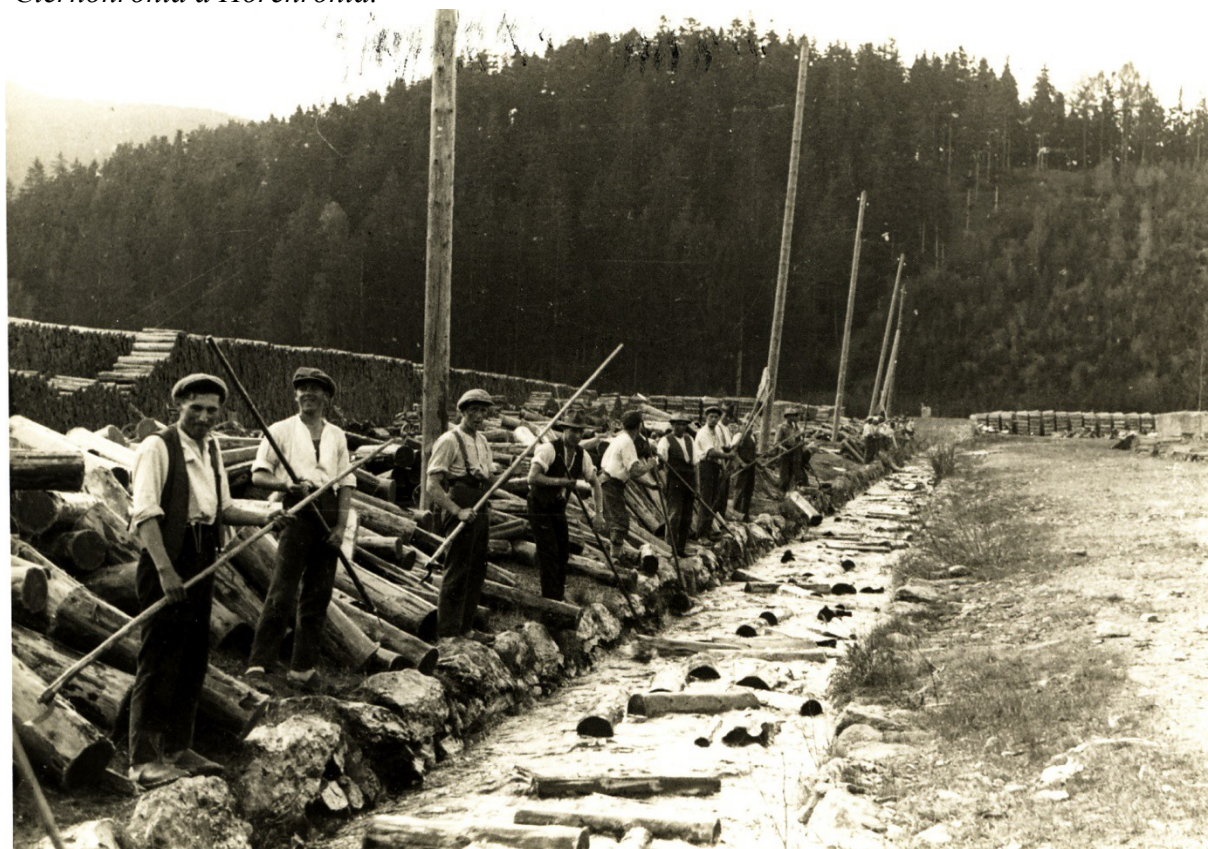
Záchytné hrable na Uhlisku pred Banskou Bystricou. Cieľová stanica plaveného dreva z lesov Čiernohronia a Horehronia.
