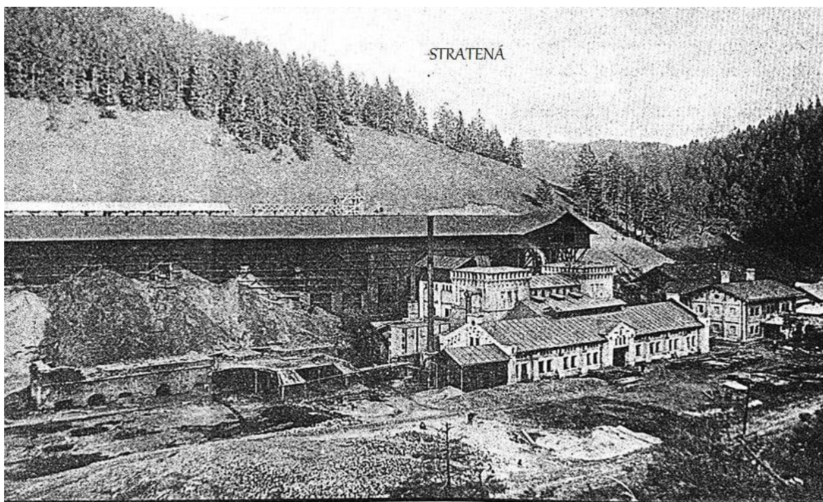
Na obrázku: dvojica pilierových vysokých pecí Stratená v popredí s odlievacou halou. V pozadí hmotáreň v spojení s vykladkovou stanicou lanovky z Mlyniiek.
