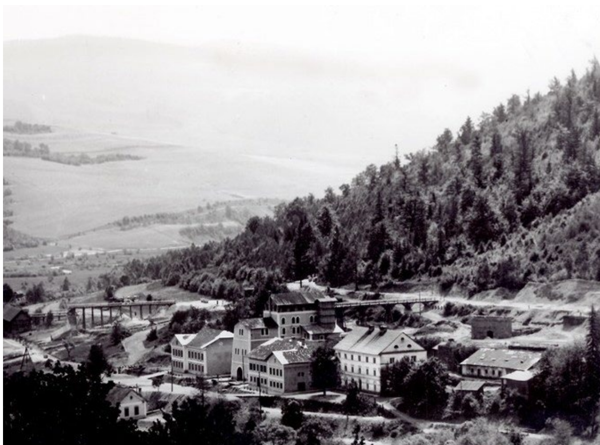
Na obrázku: vysokopecná huta Vlachovo v prevádzke do r. 1907. Neskôr prestavaná na pražiacu pec upravujúcu železnú rudu pre veľké koncerny na Morave.
