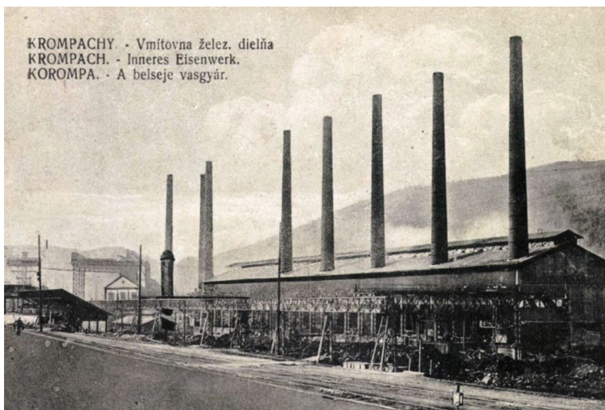
Na obrázku: Siemens-Martinská oceliaren v Krompachoch.
