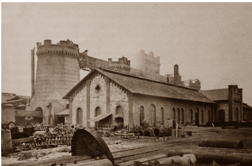
Na obrázku: Kladno neďaleko Prahy v Čechách s batériou gigantických vysokých pecí starej konštrukcie s výťahovou vežou uprostred a odlievacou halou starej hute z konca 19. storočia.
