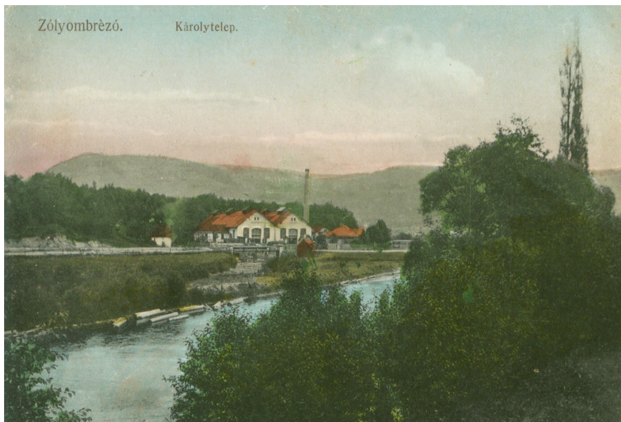
Na obrázku: pohľad na valcovňu jemných plechov vo Chvatimechu (Karlov závod).
