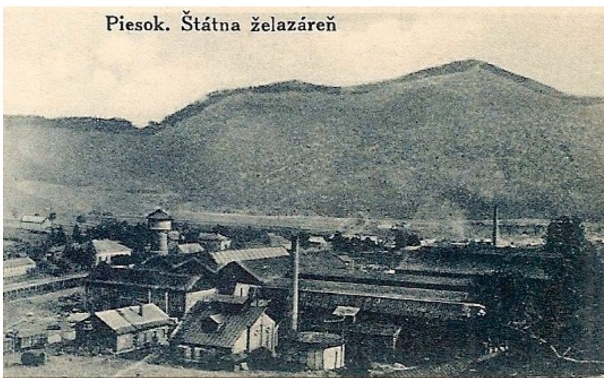
Na obrázku: pohľad na Piesocký Henriho závod Štátnych železiarní s kyslíkárňou v popredí. Išlo o prevádzku druhovýroby vyrábajúcej z valcovaných profilov a plechov oceľové konštrukcie, potrubia a nádrže.
