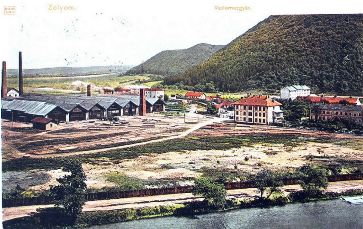
Na obrázku: pohľad na železiareň UNION poniže mesta Zvolen. Za výrobnými halami vidieť dolný kanál vodného náhonu na pohon strojov. V popredí rieka Hron, v pozadí železničná stanica a vrch Pustý hrad.
