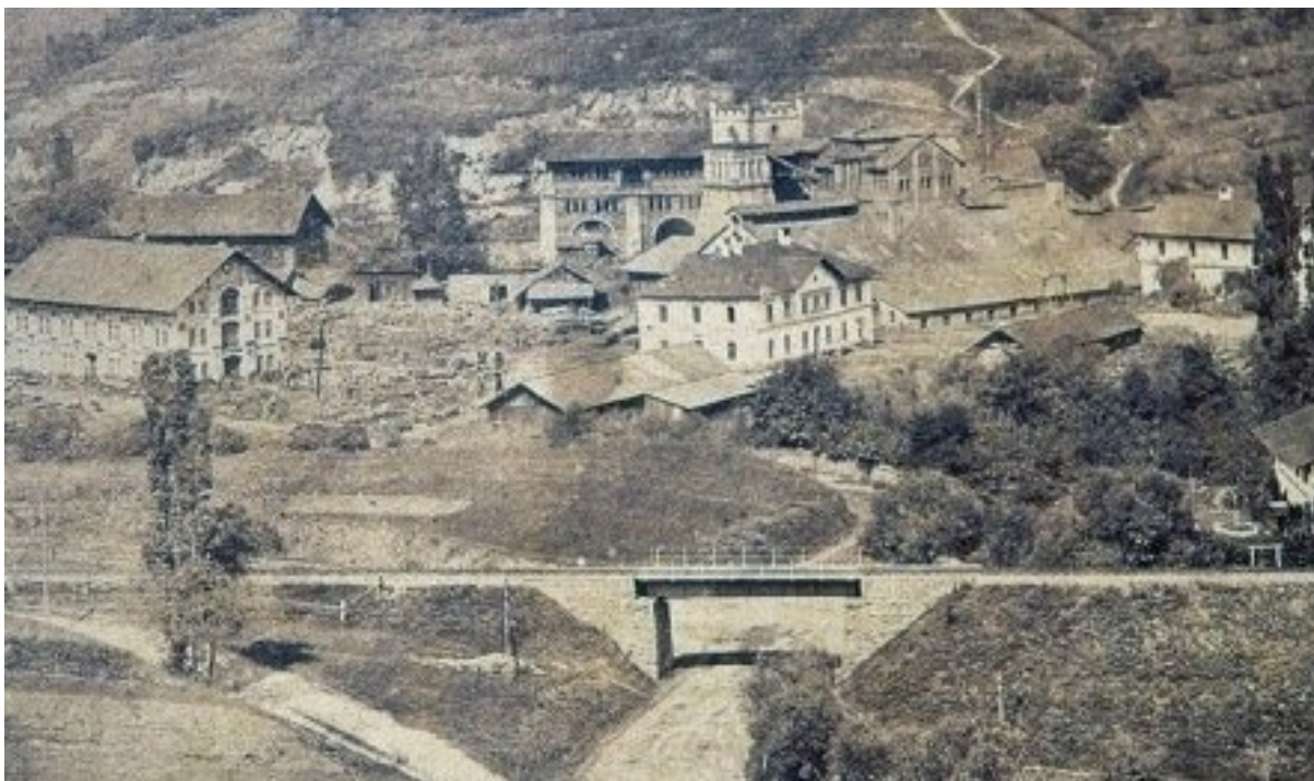
Na obrázku pohľad na starú hutu Krompachy s pilierovou vysokou pecou hore uprostred.
