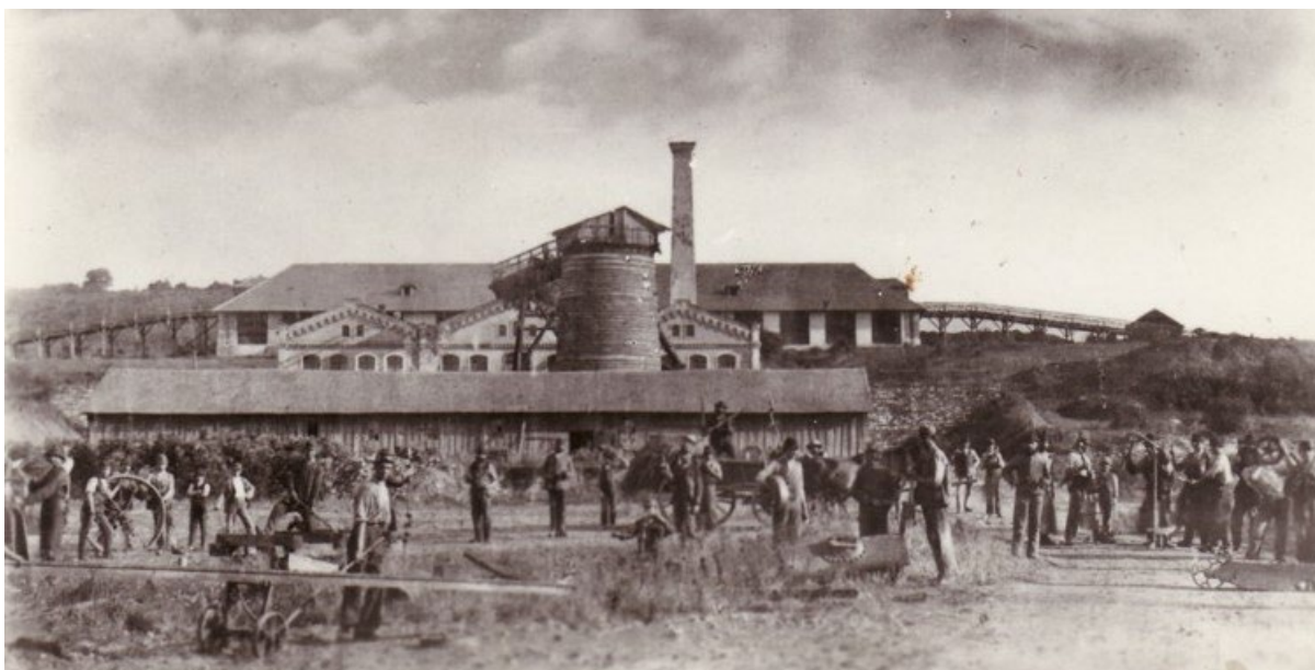
Na obrázku: čelný pohľad na vysokopecnú hutu so strojovňou v pozadí a hmotárňou celkom vzadu. Drevený barák celkom vpredu je kryté odlievacie pole na odlievanie surového železa do piesku.
