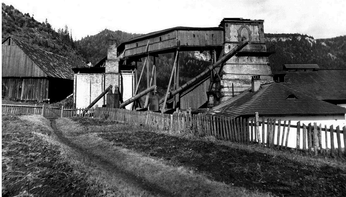
Na obrázku: vysoká pec v Dedinkách powyše Dobšinej dodatočne prestavaná na využitie kichtových plynov na ohrev vetra. Na obrázku vidieť oceľové potrubie s odprašovacími zberačmi a murovaným ohrievačom vetra. Celkom vľavo sklad uhlia a celkom vpravo odlievacia hala. Na kichtu vedie krytá rampa.
