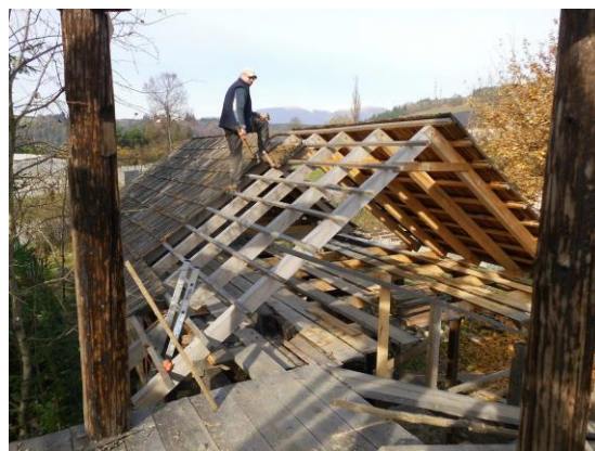
Zastrešenie renesančnej železiarne
