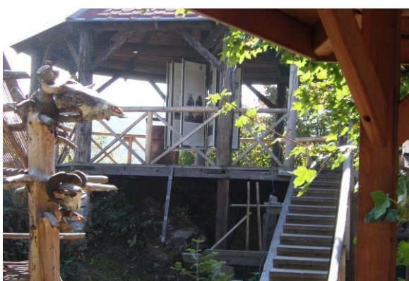
Dokončená rozhľadňa s náučnými panelmi
