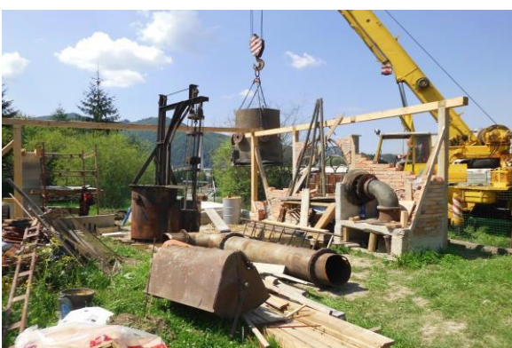
Stavba taviacej pece z Hronca
