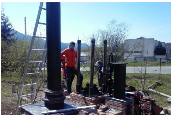
Torzo budúceho parného stroja a komína
