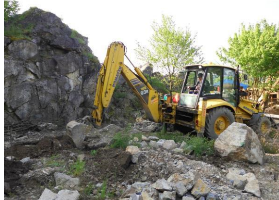
Sondovacie práce pred výstavbou objektov
