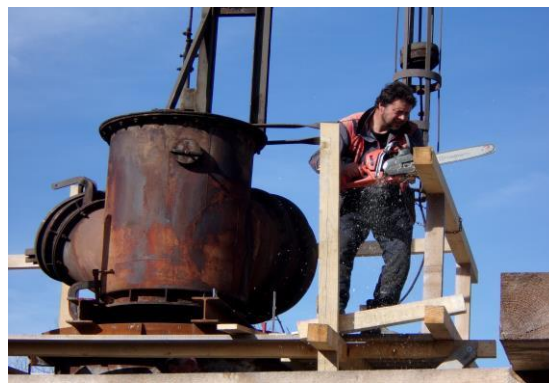
Stavba kichtovej plošiny s lapačom plynu
