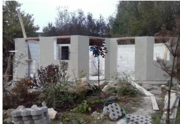
Výstavba objektu technického zázemia
