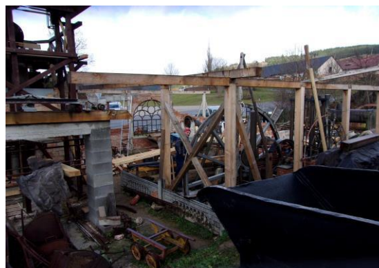
Pohľad na stavenisko parostrojnej hute
