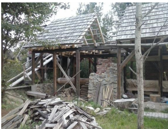
Výstavba renesančnej železiarne
