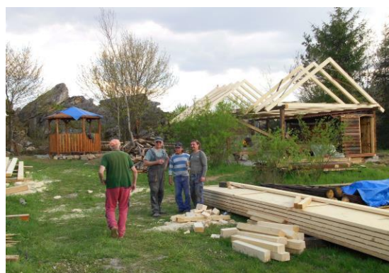
Výstavba renesančnej železiarskej dielne
