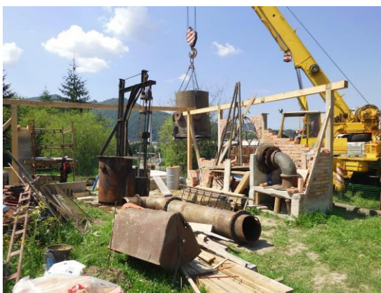
Montáž taviacej pece z Hronca
