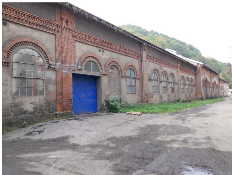
Pamiatkovo chránený objekt s drasticky vstavanou bránou a s novými okennými rámami.
