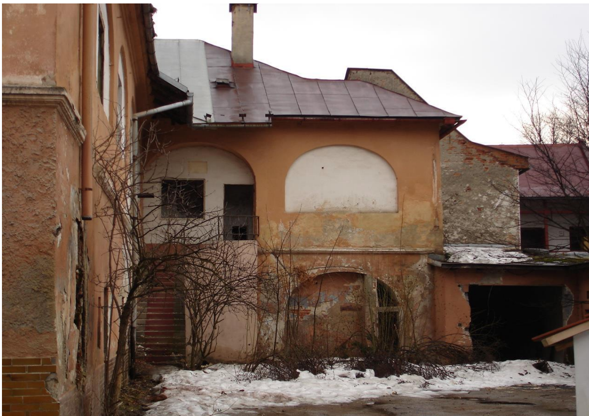
Pohľad do opusteného dvora tesne pred sanáciou historického objektu v roku 2009
