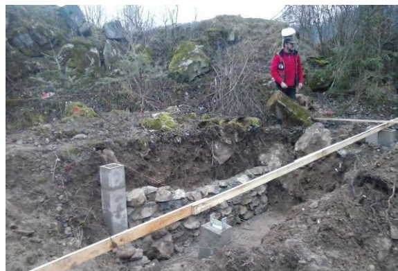
Vodná šachta budúcej kolesovne
