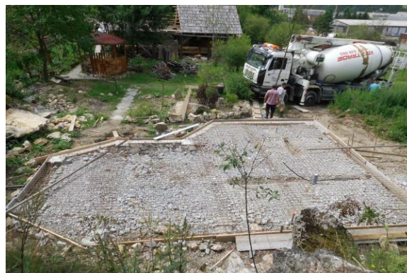
Betonáž základovej platne
