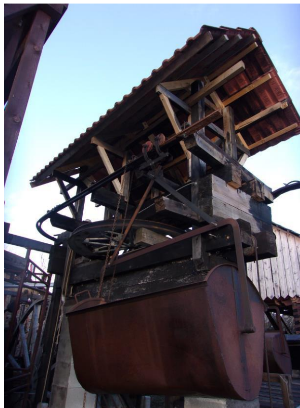
Vykládková časť nákladnej lanovky
