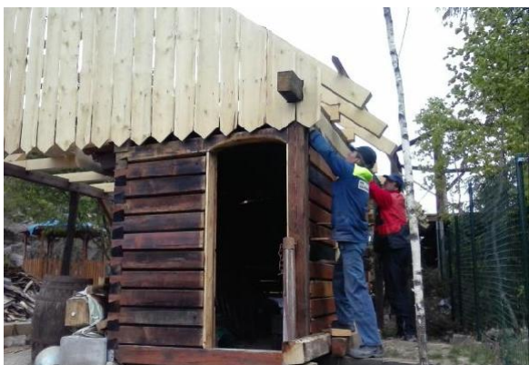
Stavba strechy renesančnej železiarne
