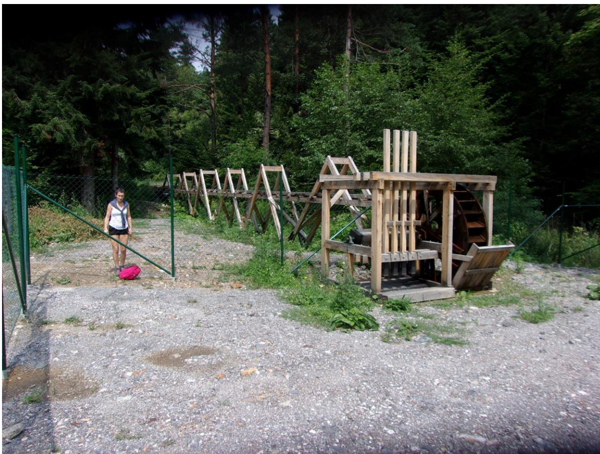
Gelnická stupa alebo pochverk s netradičnou konštrukciou vodného žľabu
