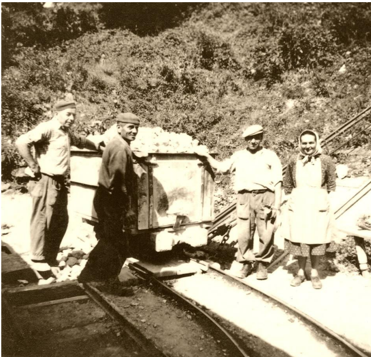
Obr. 122. Dolná stanica pozemnej lanovky na zväžnici kameňolomu v Tisovci s vozíkom železničky prepravujúcim vyťažený vápenec do drvičky a sklad vápenca pre vápenku alebo hutu.
