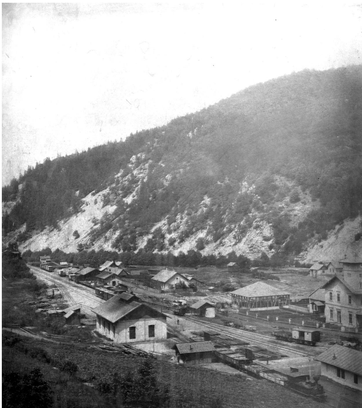
Obr. 26. Pohľad na starú podbrezovskú železničnú stanicu s výhrevňou. V pozadí vrch Šiklov.
