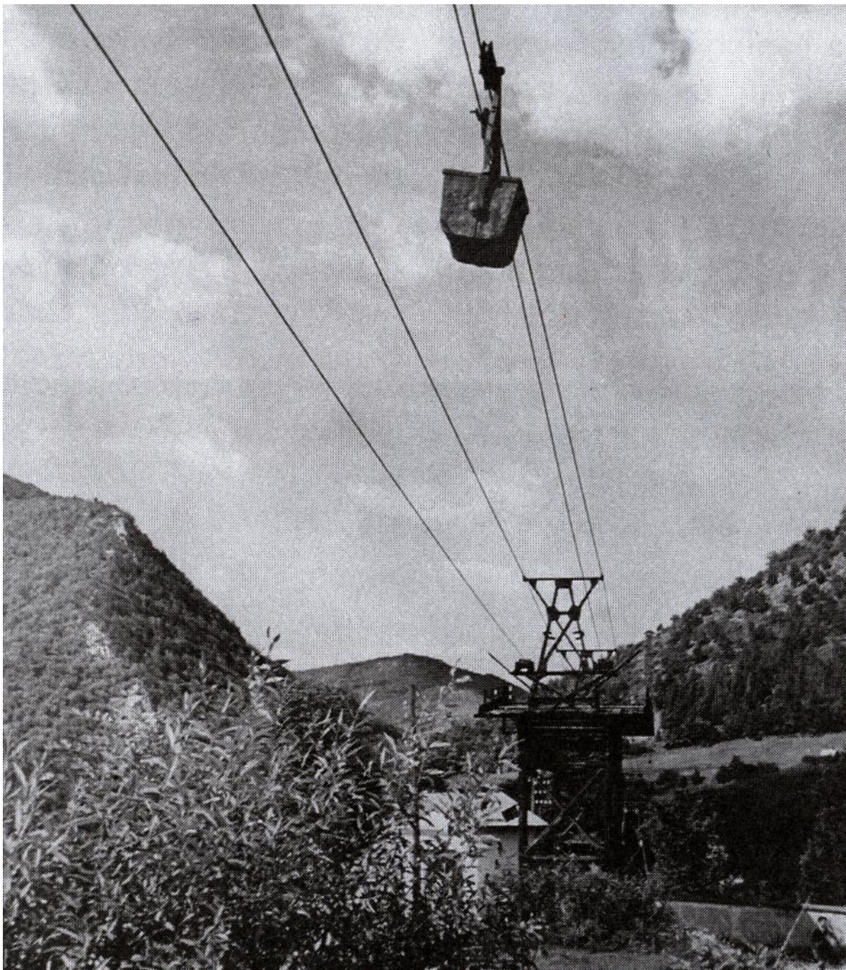
Obr. 74. Lanová dráha už s ocelovými stojkami nosných lán tesne za Tisovcom. Vľavo vrch Hradová.
