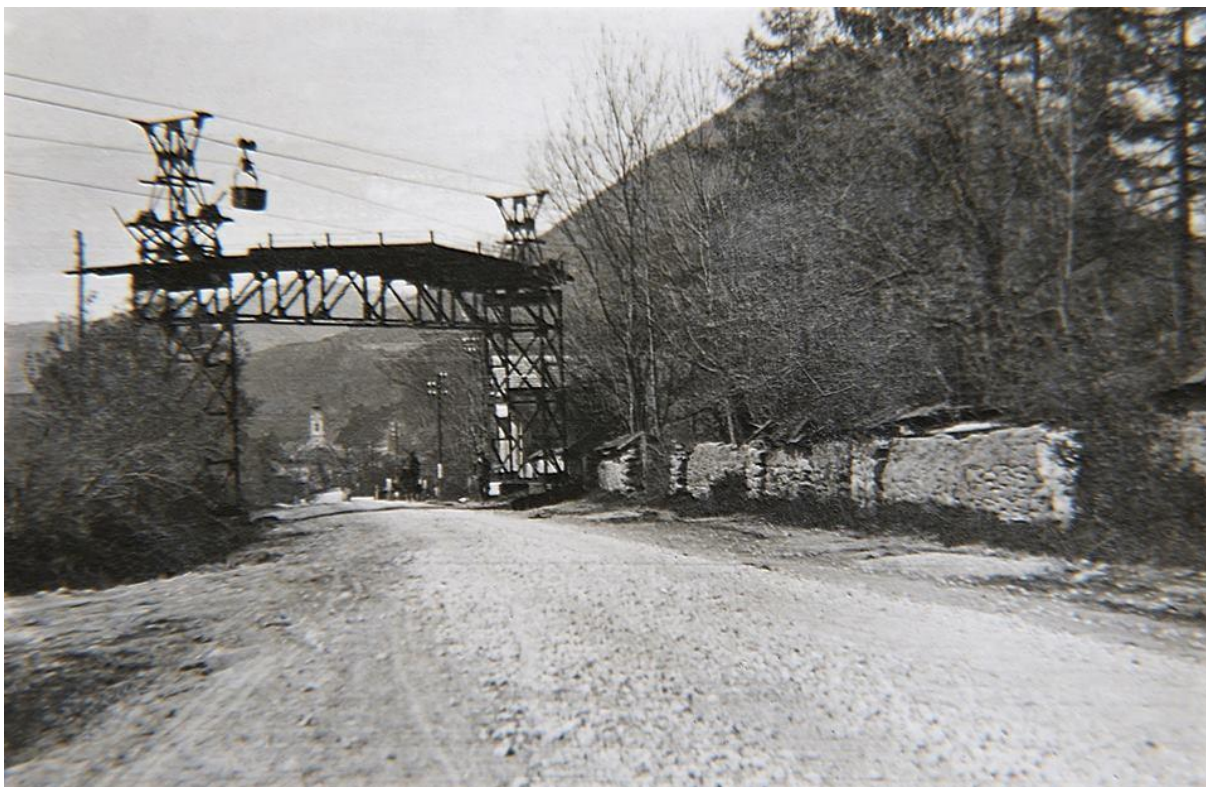
Obr. 102. Pri križovaní lanovky s cestami alebo železnicou boli postavené premostenia chrániace pred pádom naloženého substrátu, alebo aj hutníka lanovky.
