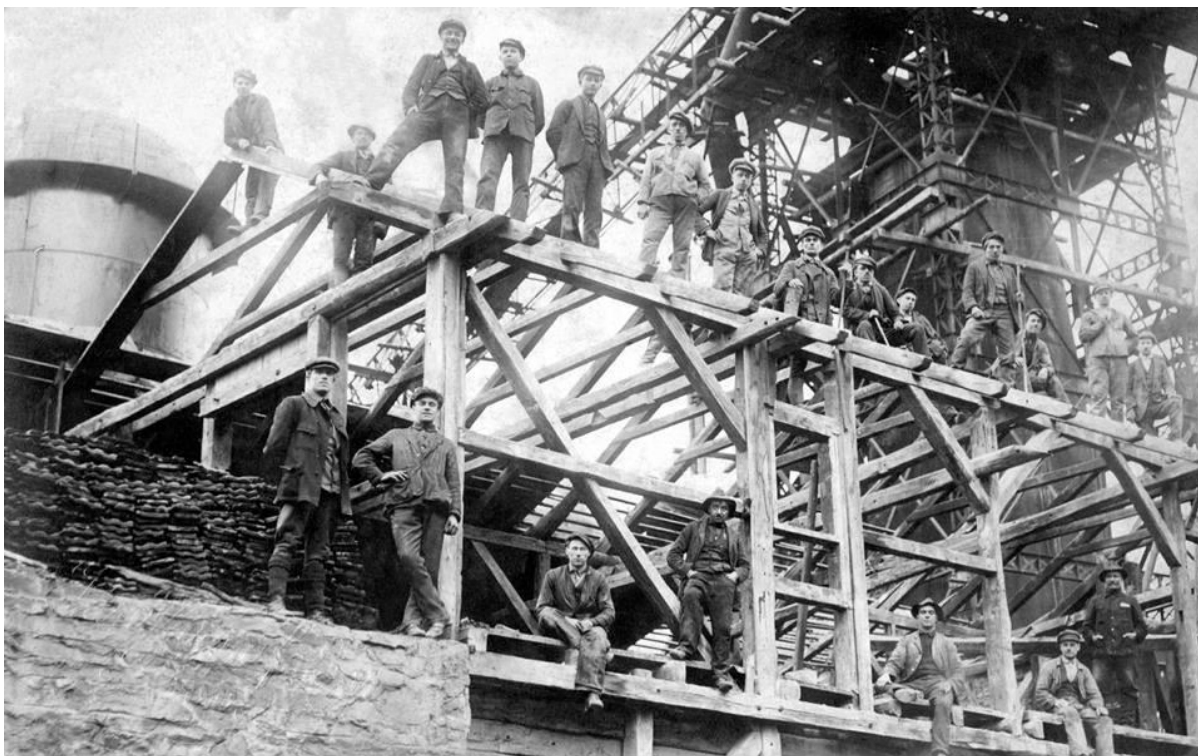
Obr. 95. Stavba troskovej lanovky od vysokej pece na kopec Grilka ešte s hrazdenou strojovňou.
