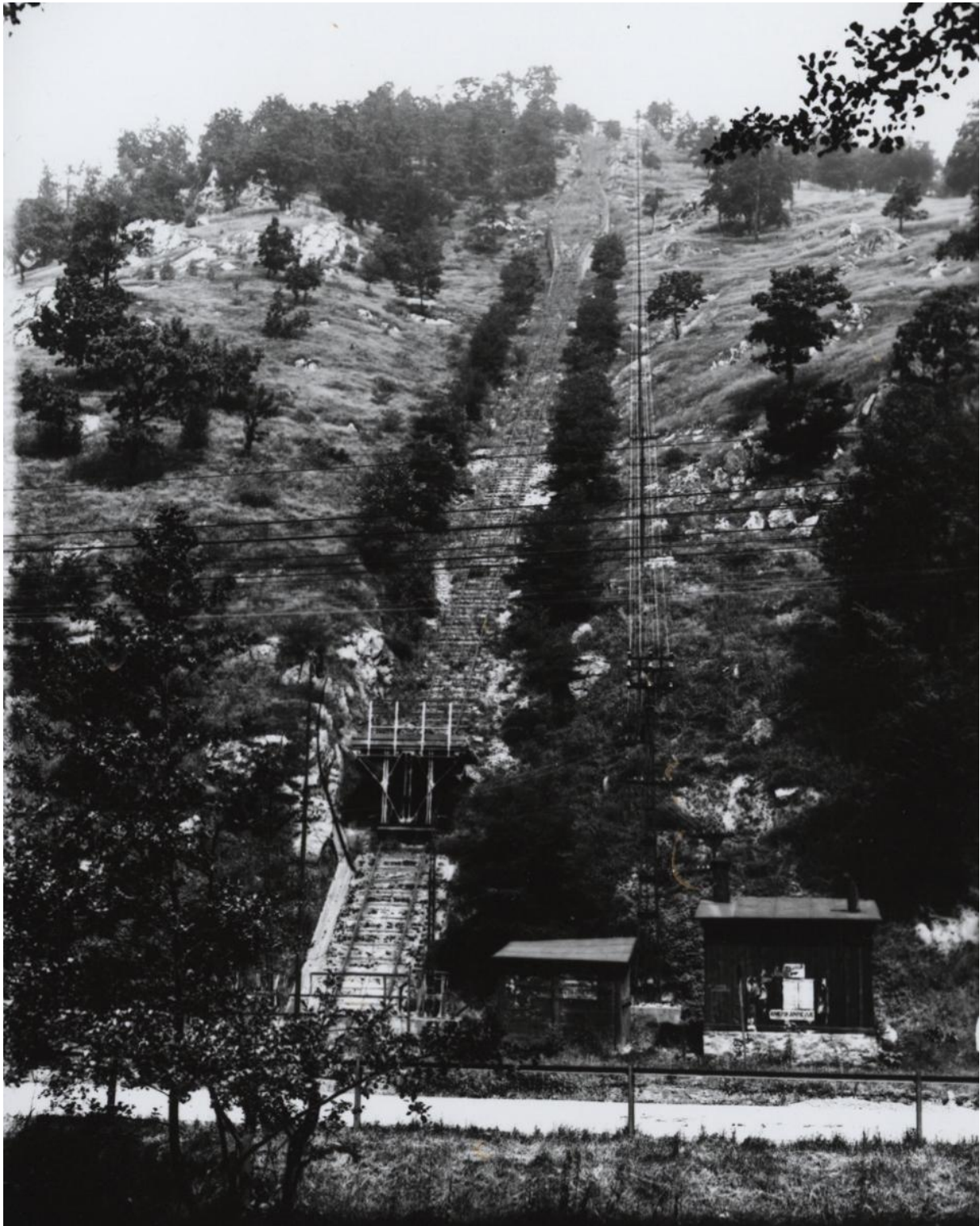
Obr. 108. Pozemná lanovka alebo šikmý výťah na vrch Šiklov v Podbrezovej. V popredí štátna cesta Banská Bystrica – Brezno a za ňou fabrická úzkorozchodná železnička. Súbežne s koľajami výťahu je elektrické vedenie pre napájanie elektromotora v strojovni na pohon lanáča. Dva protichodné plošinové vozne lanovky sa stretávajú v polovici trate a míňali sa na výhbní samočinne. Prichádzajúci vozeň sa blíži k šachte, aby plošina zastala na úrovni železničky. Plošina obsahovala dve koľaje pre naloženie dvojice výsypných vozňov s troskou. Fotopanorámu trochu rušia vodorovné čiary. Ide o elektrické vedenie vysokého napätia spájajúceho fabrickú rozvodňu s vodnými elektrárnami Lopej, Dubovú a Jasenie.
