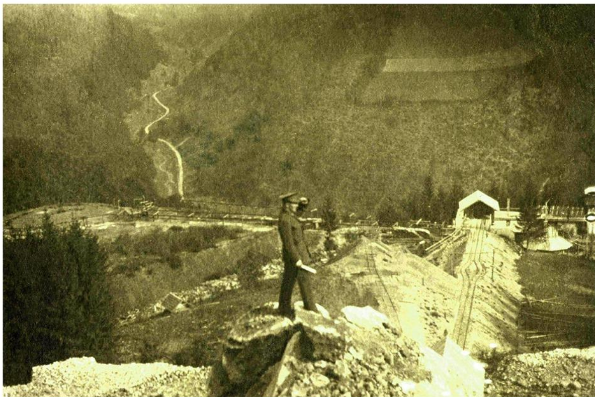
Obr. 104. Vysypná stanica lanovky Tisovec-Grilka vysokopecnej trosky (celkom vľavo) aj s dráhou pozemnej lanovky na vrchol kóty Grilka s kameňolomom, dole s násypníkom vápenca pre vysokú pec na spiatočnej ceste.
