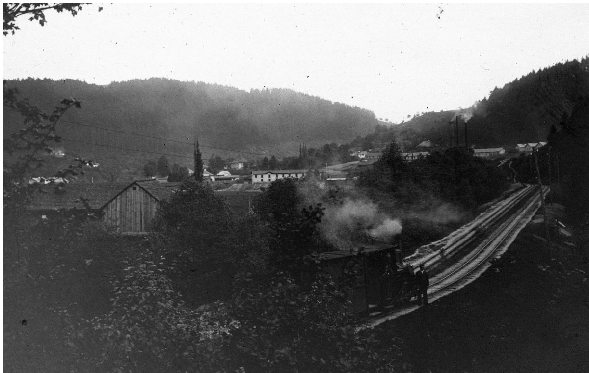
Obr. 22. Úzkorozchodná fabričná železnica s rušňom výrobcu Kachelmanových strojární a zlievárni vo Vyhniach v čele vlaku smerom do Hronca. V pozadí zlieváreň a smaltovňa, uprostred biela dvojpodlažná administratívna budova. Druhá koľaj vedie do lisovne plechového riadu.
