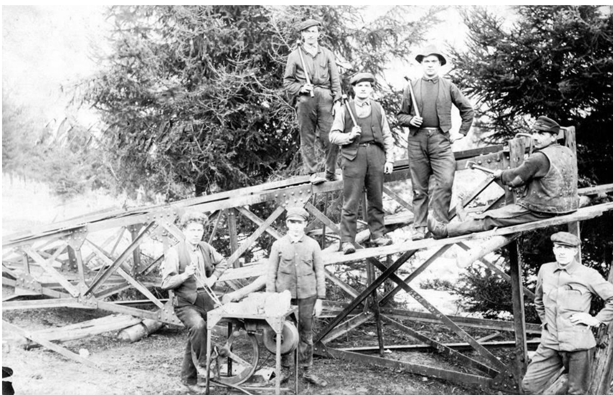
Obr. 96. Výmena pôvodných drevených stožiarov za ocelové. Konštrukcia sa zostavovala na mieste nitovaním za pomoci prenosnej vyhne s nožným dúchadlom.
