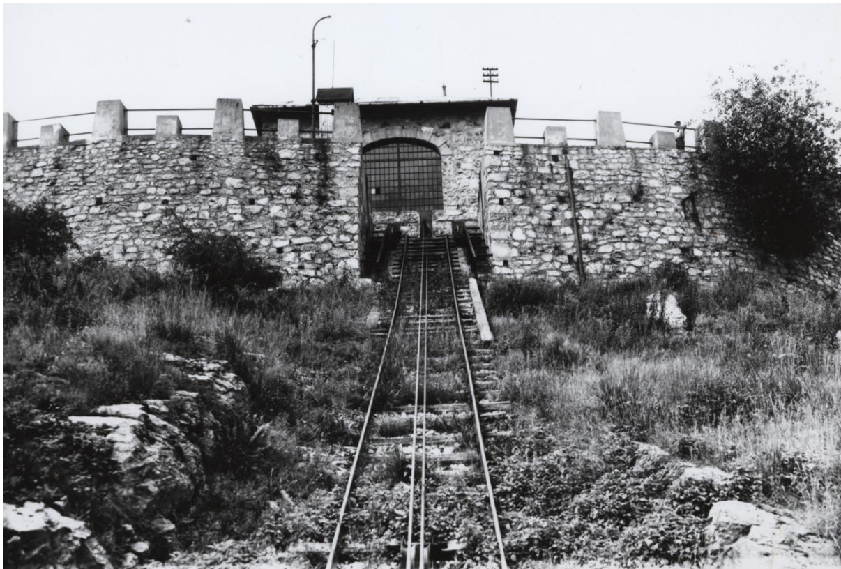
Obr. 107. Horná stanica jednokolajovej pozemnej lanovky so strojovňou. Medzi kolajami sa nachádzajú kladky a dvojica ťažných oceľových lán.
