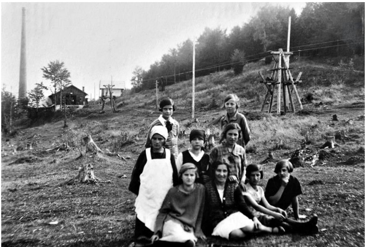
Obr. 92. Poháňacia stanica Korimovo (v pozadí vľavo s komínom) a stožiare lanovej dráhy.
