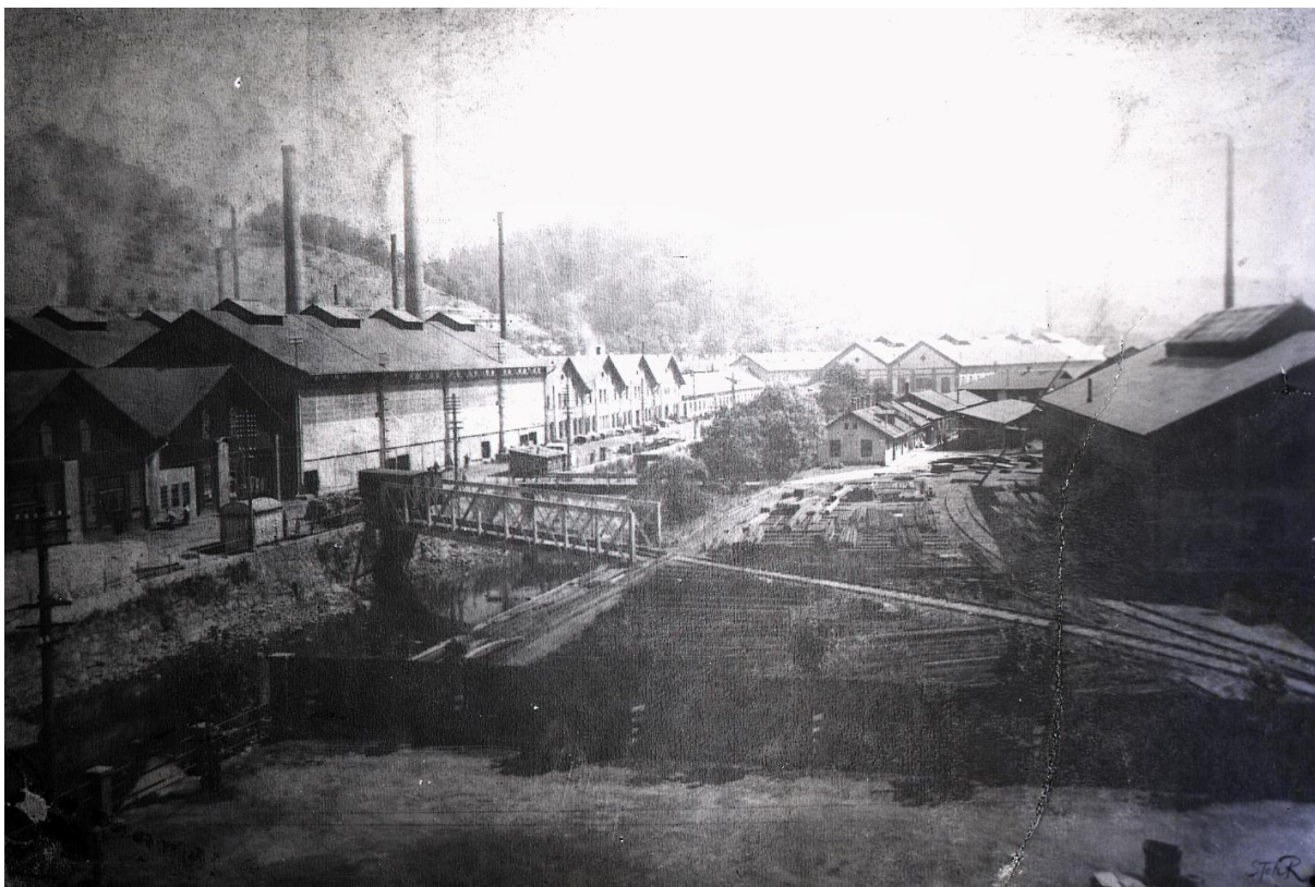
Obr. 53. Podbrezová z čias monarchie po prvej prestavbe. V popredí železničný most podnikovej vlečky cez rieku Hron a koľajšte fabrickej úzkorozchodnej železničky. Zľava objekty valcovne, stará valcovňa a v pozadí vpravo nová manessmanova rúroveň, celkom vpravo sklad rúr a za ním plechový komín podnikovej tehelne žiaruvzdorných tehál.
