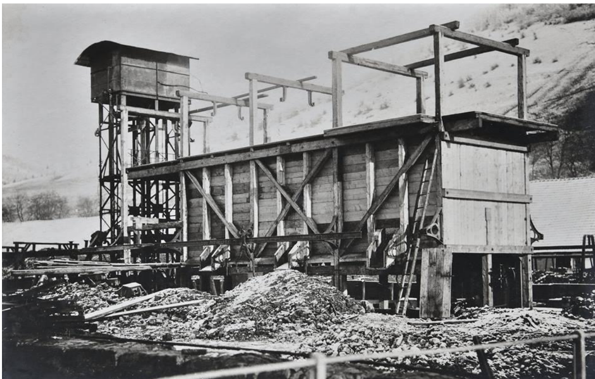
Obr. 103. Lanová dráha už s ocelovými stojkami nosných lán tesne za Tisovcom. Vľavo vrch Hradová.
