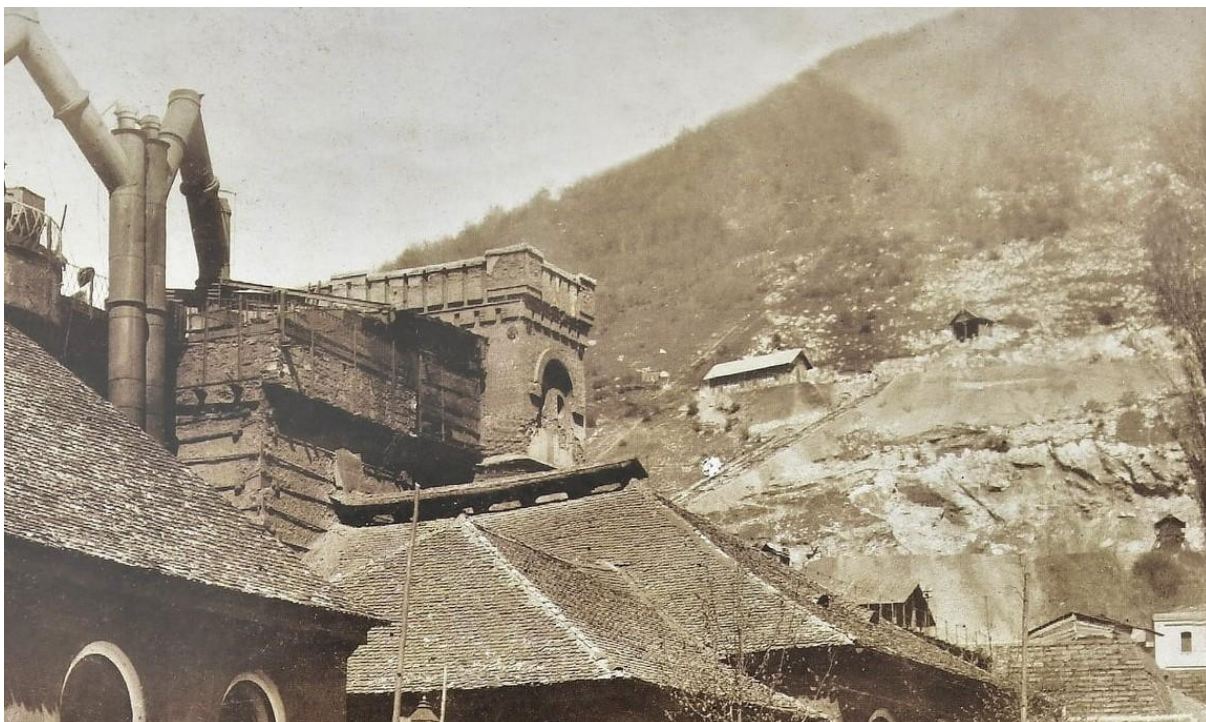
Obr. 120. Druhá pozemná lanovka v Tisovci spájajúca ťažobné obzory vápencového lomu s hutou aj železničnou stanicou.
