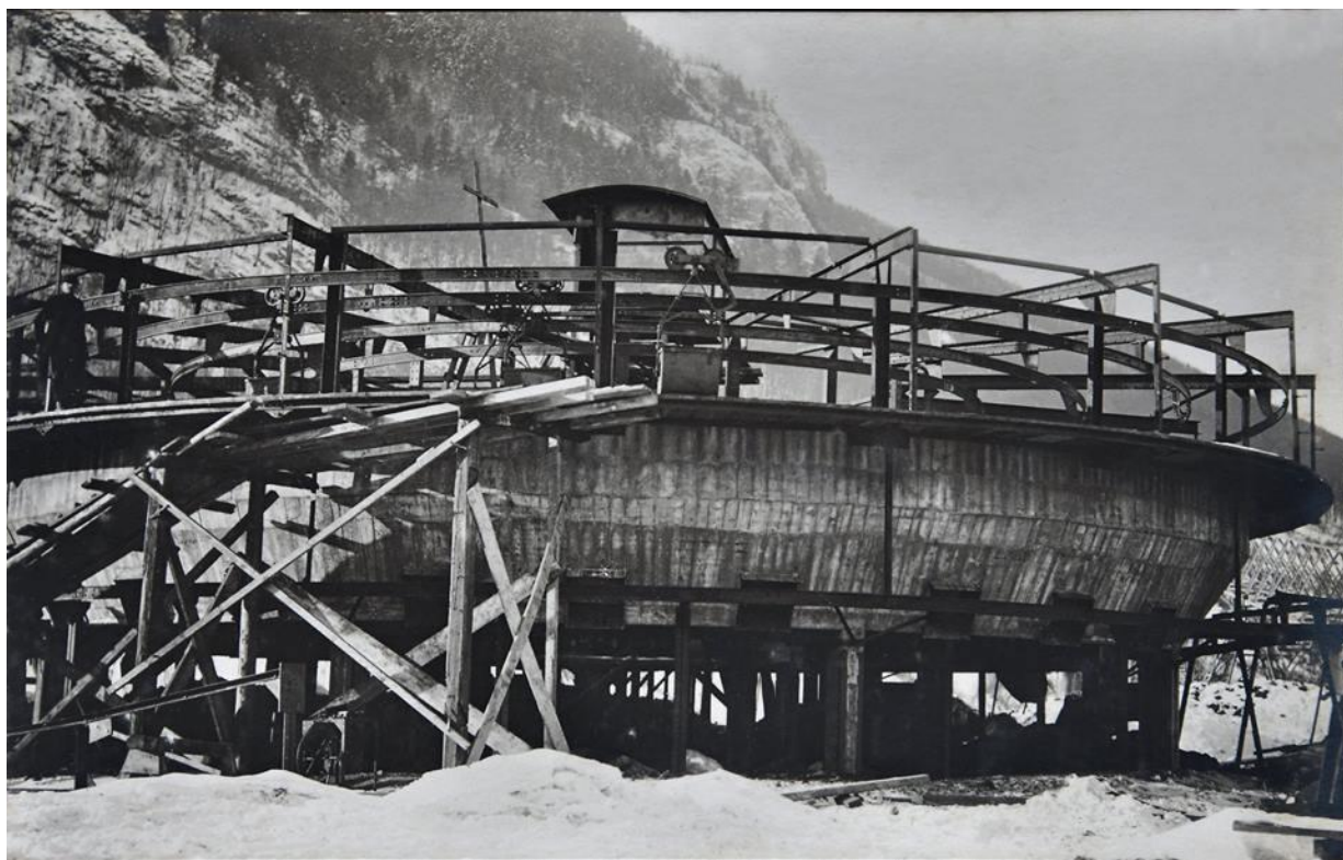
Obr. 106. Kruhový (prstencový) zásobník (ešte bez strechy) dovezenej železnej rudy hore s výsypnou dráhou lanovky od prijímacie stanice a dole násypnou dráhou krátkej lanovky k vysokej peči.
