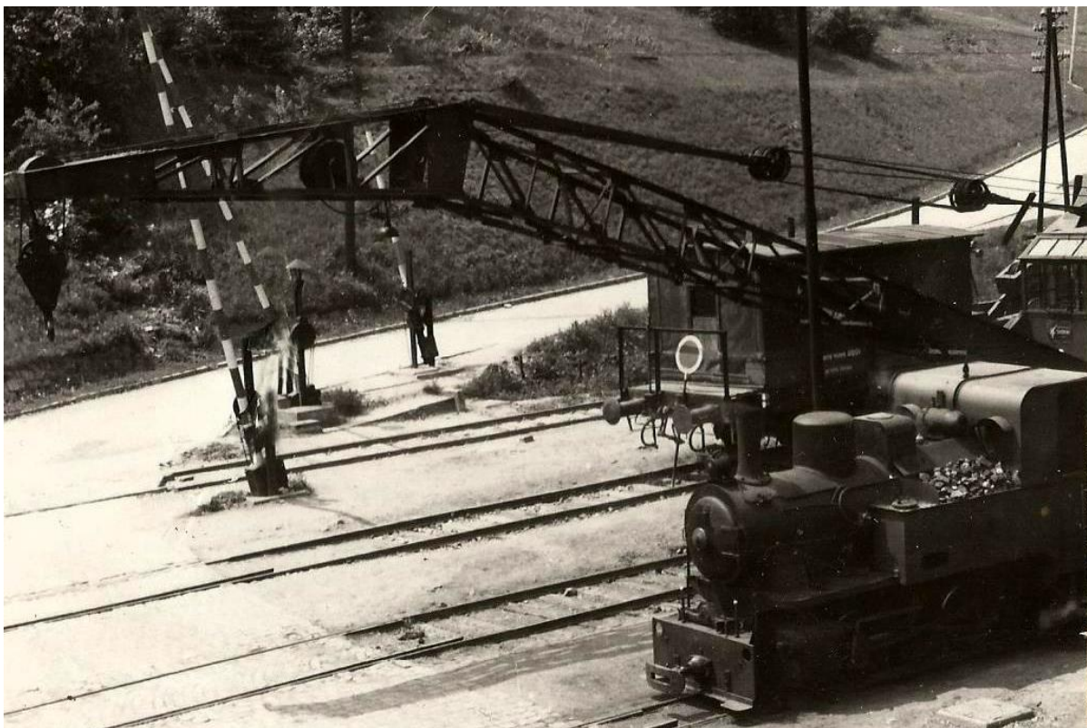
Obr. 66. Železničné priecestie v Podbrezovej s prvým diesel-elektrickým žeriavom o hmotnosti 5 T. v popredí parný rušeň v čele vlaku pripravený na posun. Rampy chránia len štátnu trať.
