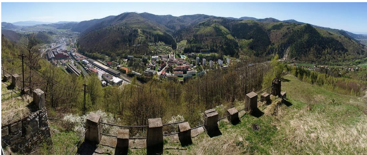
Obr. 118. Na porovnanie súčasný pohľad z bývalého koľajiska hornej stanice pozemnej lanovky Šiklov. Vľavo dolu je šachta vozňa šikmej pozemnej lanovky kde zastavila jeho plošina s dvojicou vozňov fabrickej úzkorozchodnej železnice. Tie potom obsluha výťahu Šiklov ručne vytlačila po koľajach súběžne s palisádami oporného múra na hranu skládky a obsah pecnej trosky vysypala dolu strmím svahom. Mnohokrát tak skončili aj vozne, nazývané huntíky. Výhľad na fabriku v údolí Hrona a okolité vrchy bol pre robotníkov úchvatný a k nezaplateniu.
