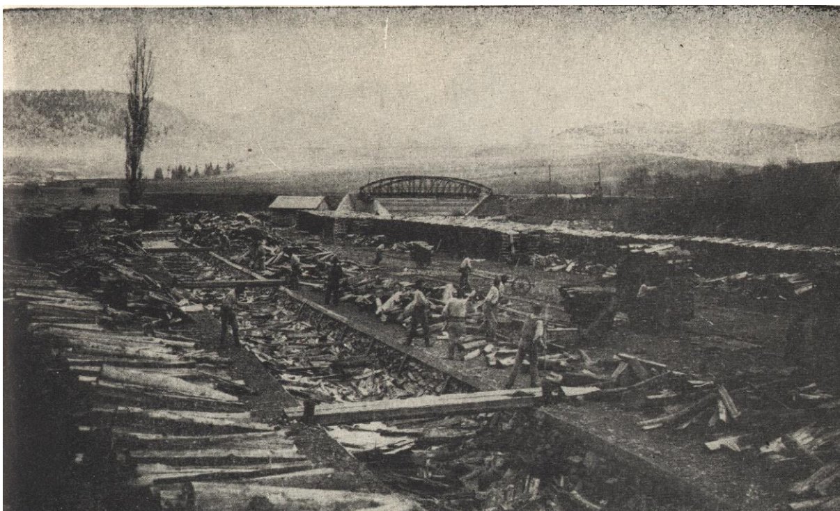
Obr. 8. Plavebné kanály vo Chvatimechu už bez vody plné kľuftového dreva robotníci vyťahujú a ukladajú do šichtúňov. Lávky cez kanál sa opäť založia zvislými žrdami nazývané hrablice a druhý deň môže plavačka pokračovať, pokiaľ sa všetko nachystané drevo za niekoľko týždňov nesplaví.
