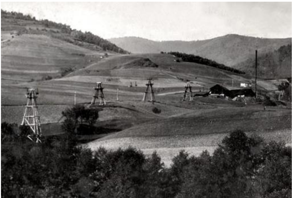
Obr. 90. Pohľad na pohonnú stanicu Ratkovské Bystré (od Sirku smerom na Korimovo).
