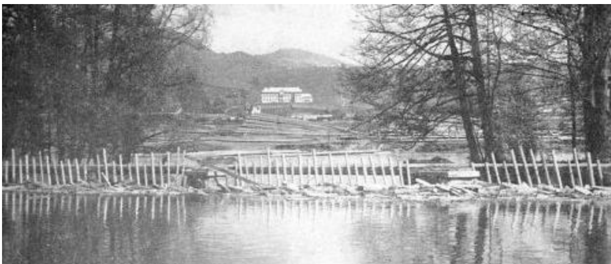
Obr. 10. Horné záchytné hrable v Banskej Bystrici na horných lúkach dnes časť Majer.
