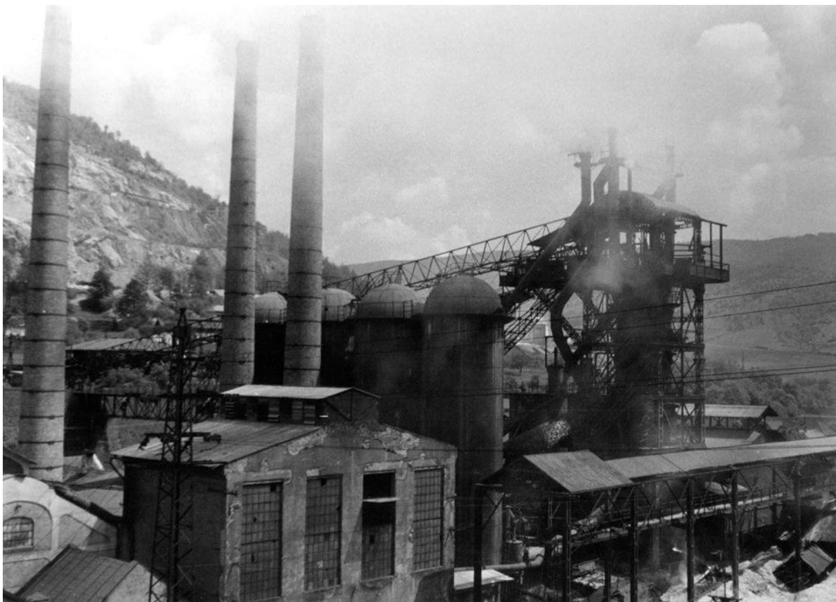
Obr. 101. Pohľad na druhú lanovku Tisovec – Grilka. Vpravo dole jej nakladacia stanica a v pozadí šikmá konštrukcia kychtovej tretej lanovky na kychtu vysokej pece z rudného dvora.
