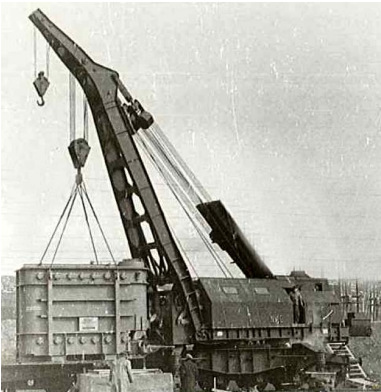
Obr. 68. Najsilnejší koľajový parný žeriav „Maco,, zakúpený pre podbrezovskú železiareň. Z bočných dverí nazerá kurič. Neskôr ho nahradil dieselový žeriav s rovnakou nosnosťou 50 ton.
