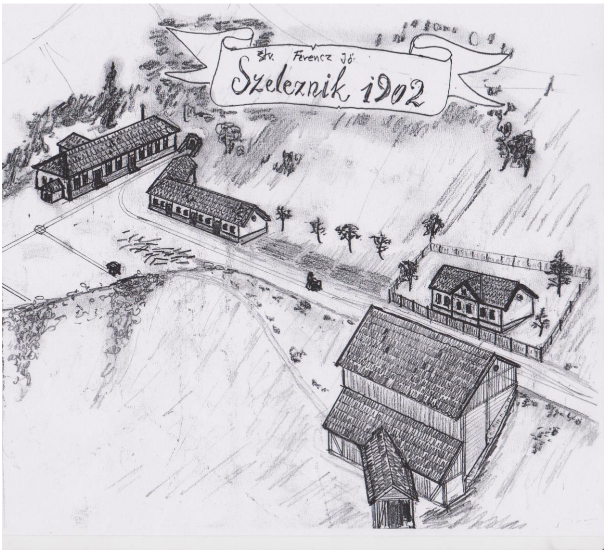
Obr. 77. Veduta ústia dedičnej štôľne Františka Jozefa (vľavo hore) a nakladacej stanice nákladnej lanovky (celkom vpravo dole) z roku 1902. Pred štôľňou na haldách postavili aj pražiacie pece vyťaženej rudy. Aj tu zaviedli koľajovú dopravu a kompresorovňu.
