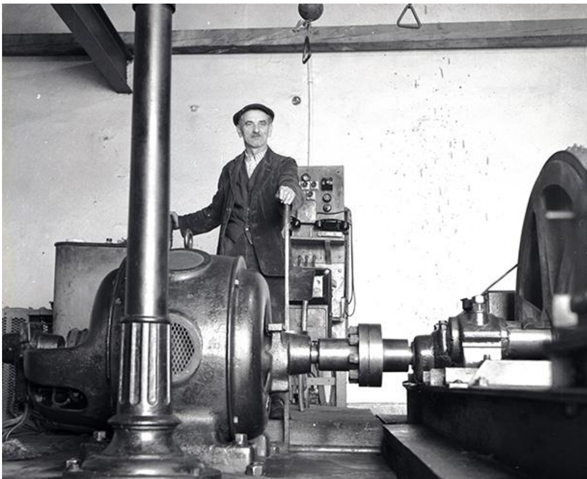
Obr. 114. Obsluha strojovne pozemnej lanovky alebo šikmého výťahu Šiklov.
