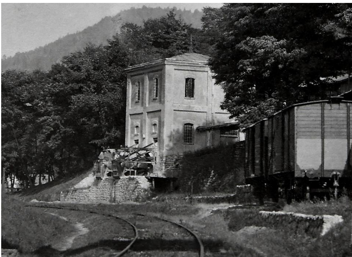
Obr. 121. Objekt drvičky a skladu vápenca so sýpmi pre nakládku železničných vagónov.
