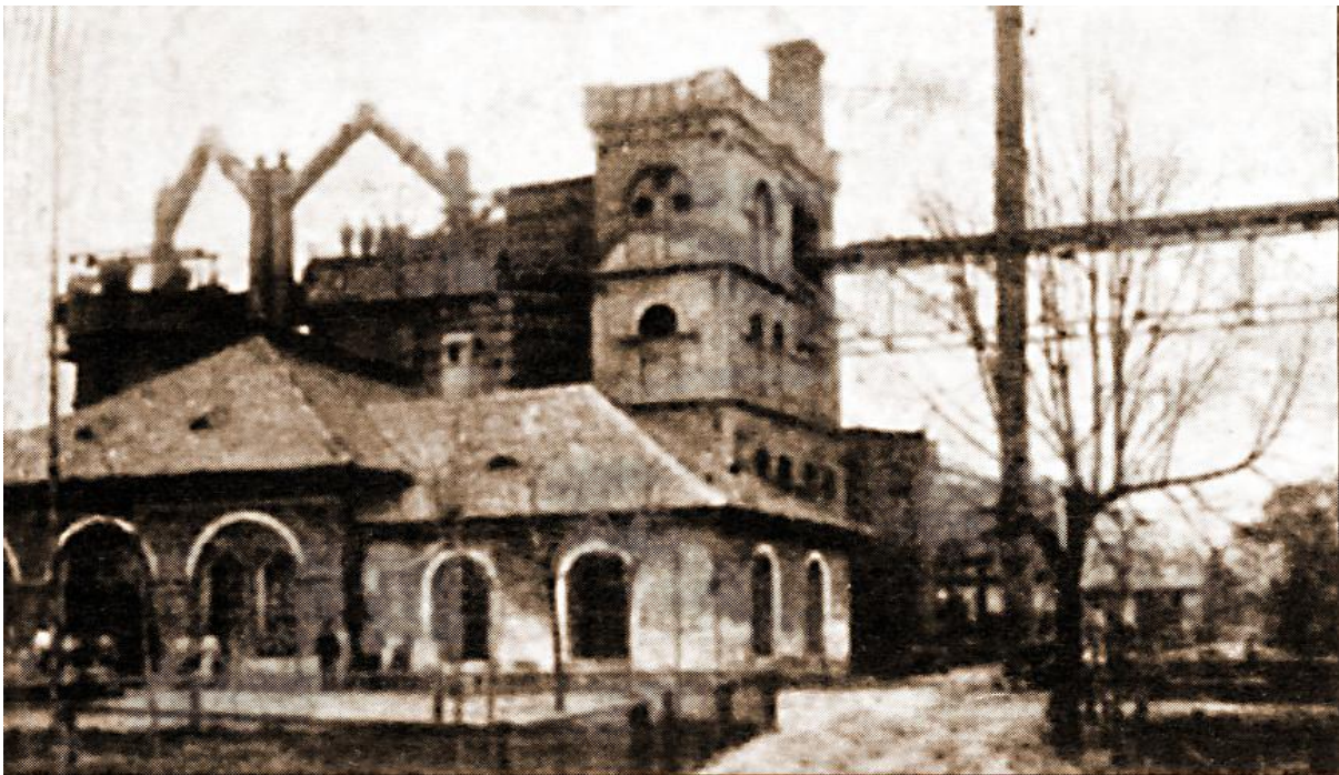
obr. 72. Pohľad na mostovku kychtovej lávky (celkom vpravo) od rudného dvora postavenej v r. 1913. V pozadí zľava stará veža kychtového výťahu a za ňou nová tenkostenná vysoká pec osadená v ocelovej konštrukcii, uprostred trojica Coupových ohrievačov vetra a trojica komínov.
