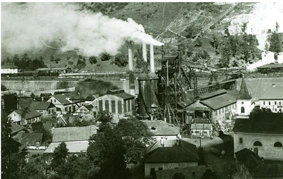
Obr. 80. Celkový pohľad na hutu v Tisovci s vysokou pecou uprostred. V pozadí vľavo železničná stanica, vľavo karuselový zásobník železnej rudy (bunker), nad ním okraj vápencového lomu.
