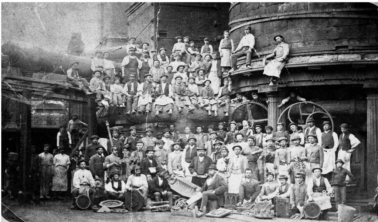
Obr. 63. Vzácné foto zamestnancov hroneckej hute tesne pred zbúraním vysokých pecí v roku 1883. Polovica pózujúcich je bosá. V popredí vpravo stĺpová pec škótskeho typu, vľavo ohrievač vetra. Uprostred izolované potrubie, za ním veža so zásobníkom kychtového plynu a za ňou vyčnieva výtahová veža. Uvolnené železné obruče naznačujú začatú sanáciu objektov po ich definitívnom odstavení. V objekte zostali funkčné len dve kuplové pece.
