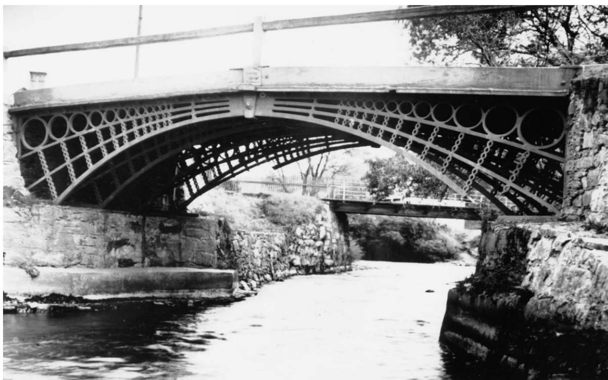
Obr. 34. Historický pohľad na jeden z prvých železných (liatinových) mostov v Uhorsku odliatych v hroneckej Maši a osadených v Hronci. Foto pochádza z r. 1945 po prechode frontu s viditeľným poškodením. V pozadí železničný oceľový most fabrickej železničky.
