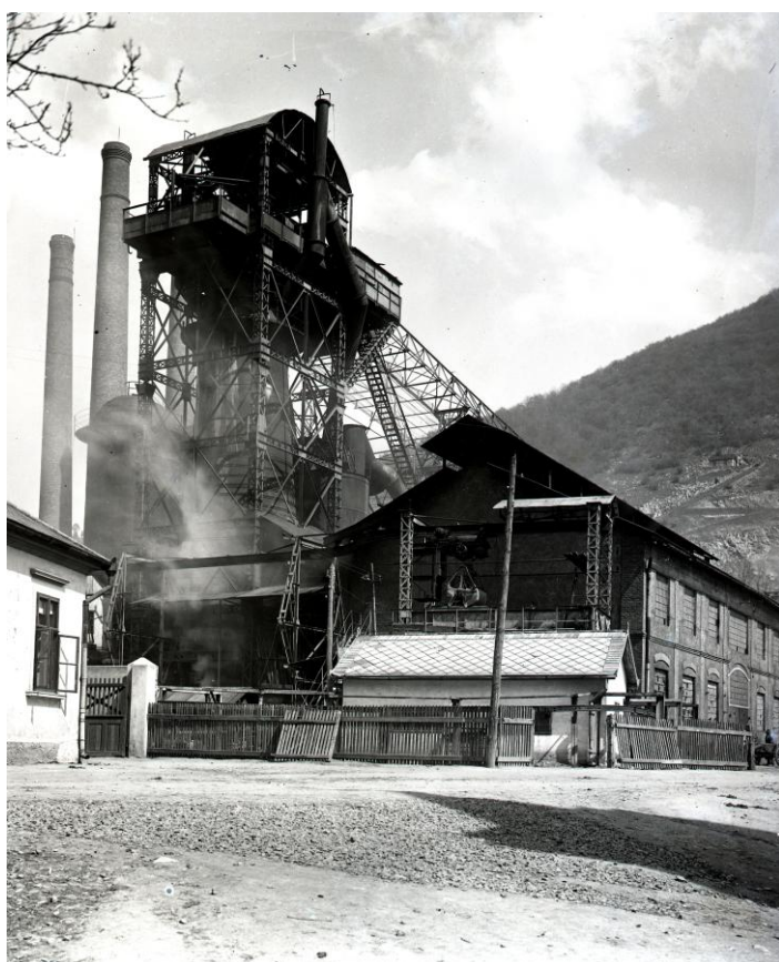
Obr. 83. Huta v Tisovci z r. 1940 s vysokou pecou trojicou ohrievačov vetra a komínmi, šikmo uklonená rampa je lanová dráha medzi rudným dvorom a kychtou vysokej pece .
