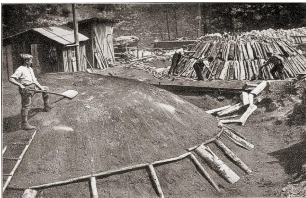
Obr. 64. Súčasťou hute bolo rozsiahle uhlisko neďaleko plavebných kanálov na Čiernom Hrone, kde z dopraveného kľuftového dreva vyrábali stále nedostatkové drevné uhlie ako palivo pri tavbe železnej rudy vo vysokých peciach. Milier v popredí spravidla hore l sedem až dvanásť dní.
