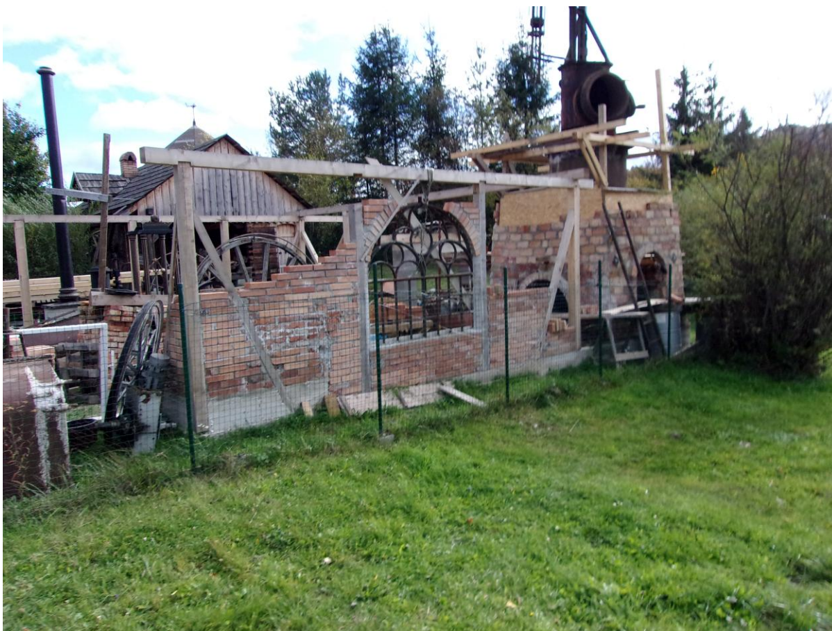
Obr. 110. Pohľad na vonkajšiu hrazdenú stenu hute skanzenu so začatou obmurovkou pilierového plášťa repliky vysokej pece z polovice 19. storočia, podľa vzoru ľubietovskej pece zrušenej v r. 1908. Uprostred jediný dochovaný exemplár liateho rámu okna v románskom slohu z huty v Hronci starý 170 rokov. V pozadí drevená stavba renesančnej železiarne.
