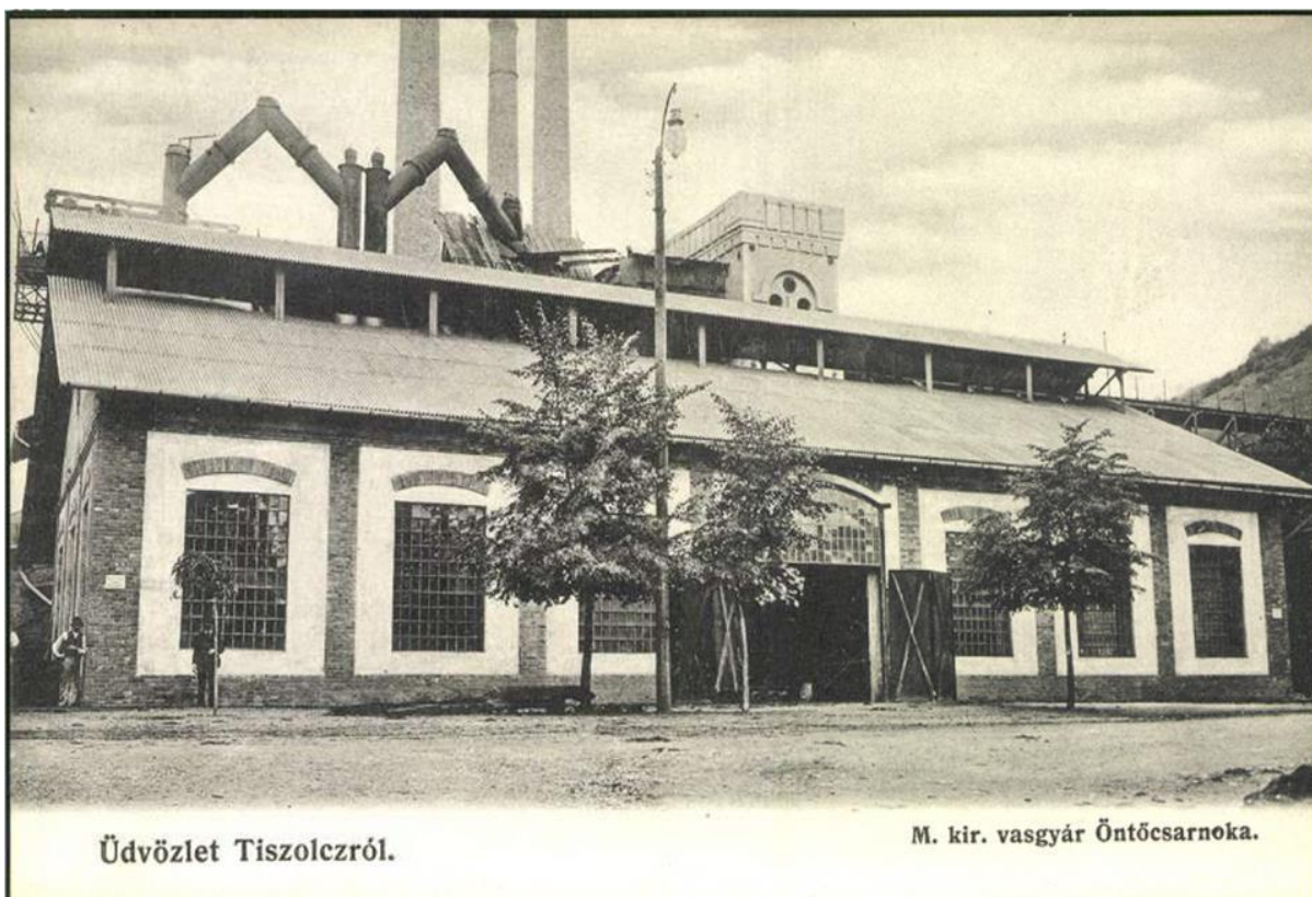
Obr. 76. Nová odlievacia hala v tisovskej hute už ako prvá v celom komplexe obsahuje mostový žeriav.
