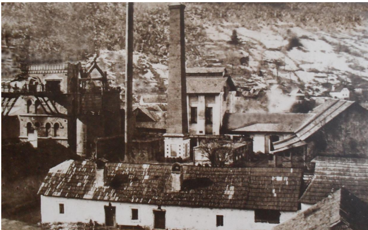
obr. 75. Pohľad na hutu s novou stĺpovou pecou škótskeho typu spolu s novou výtahovou vežou podobne ako v Hronci v neorománskom slohu. Pre obsluhu dvoch pecí mala dva výtahy vedľa seba. Starú pilierovú pec ponechali ako záskok. Vedľa pecí sú v rade postavené výkonnejšie ohrievače vetra Whitwellovho typu. Uprostred stojí starý štvorboký komín.
