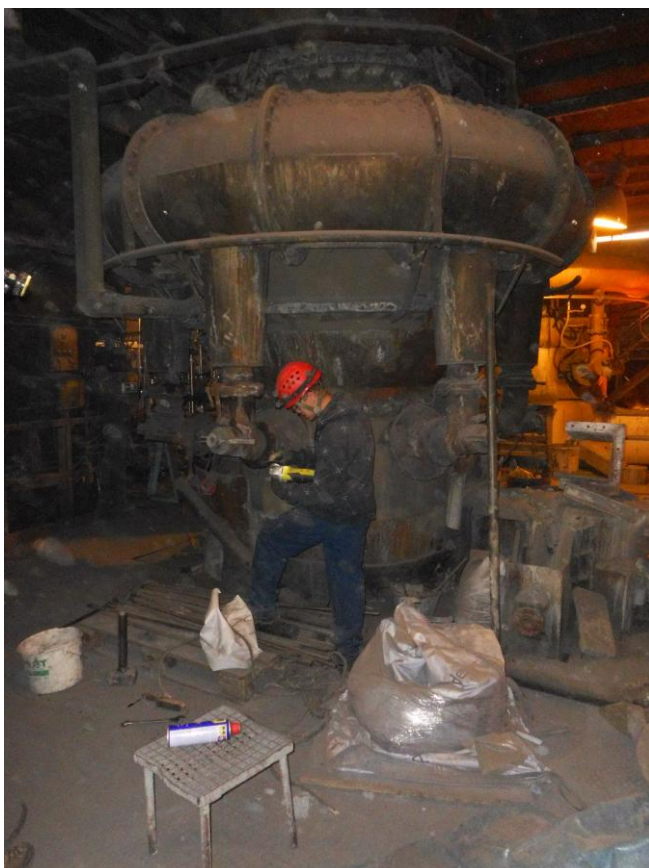
Obr. 106. Demontáž zrušenej kuplovej pece v Hronci v roku 2017.
