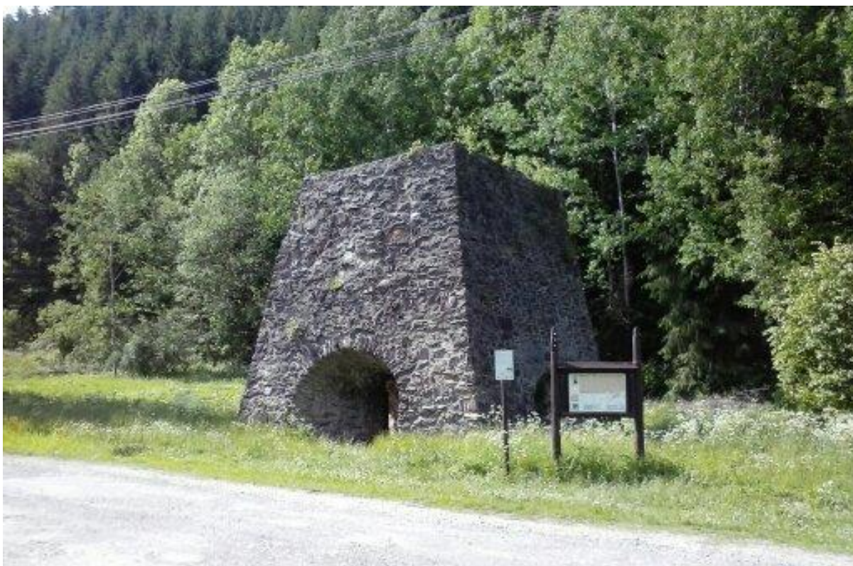
Obr. 108. Súčasný stav technickej pamiatky nad obcou Osrbliu.
