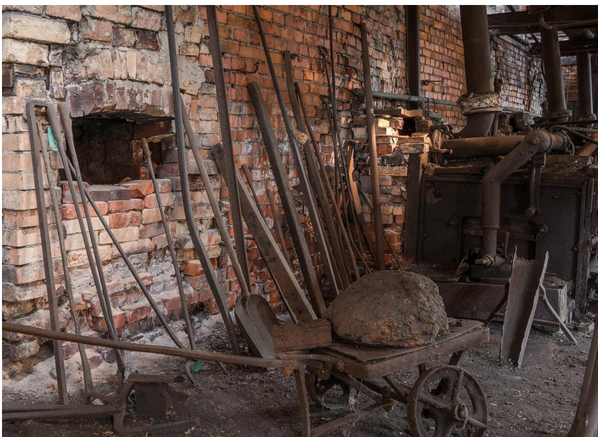
Obr. 17. Bočný pohľad na rovnakú prevádzku skujňovacích vyhní. V popredí železný vozík na prepravu vytavenej hrudy kujného železa pred pudlovaním.
