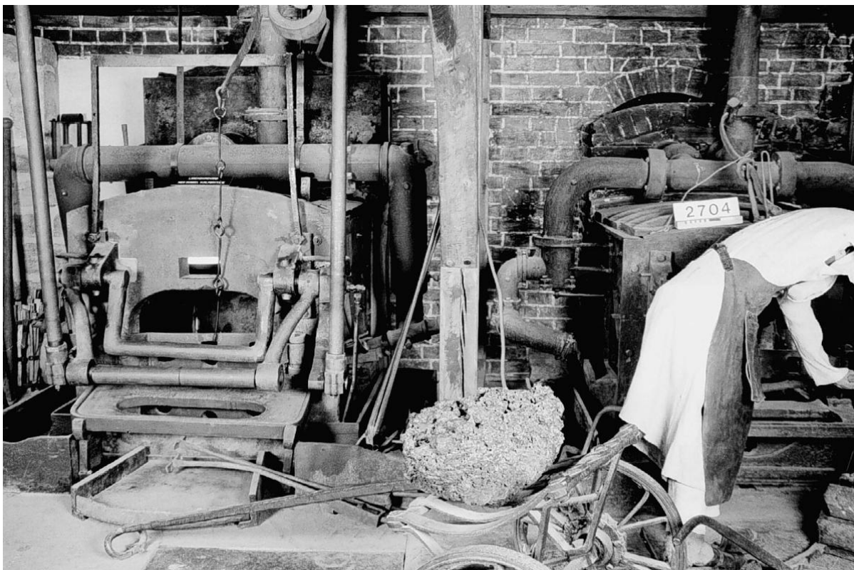
Obr. 16. Ilustračné foto podobnej ohrievacej vyhne s protíahlymi výfuchňami privádzanými liatinovým potrubím z kominového priestoru v pozadí za účelom ohrevu vháňaného vzduchu.
