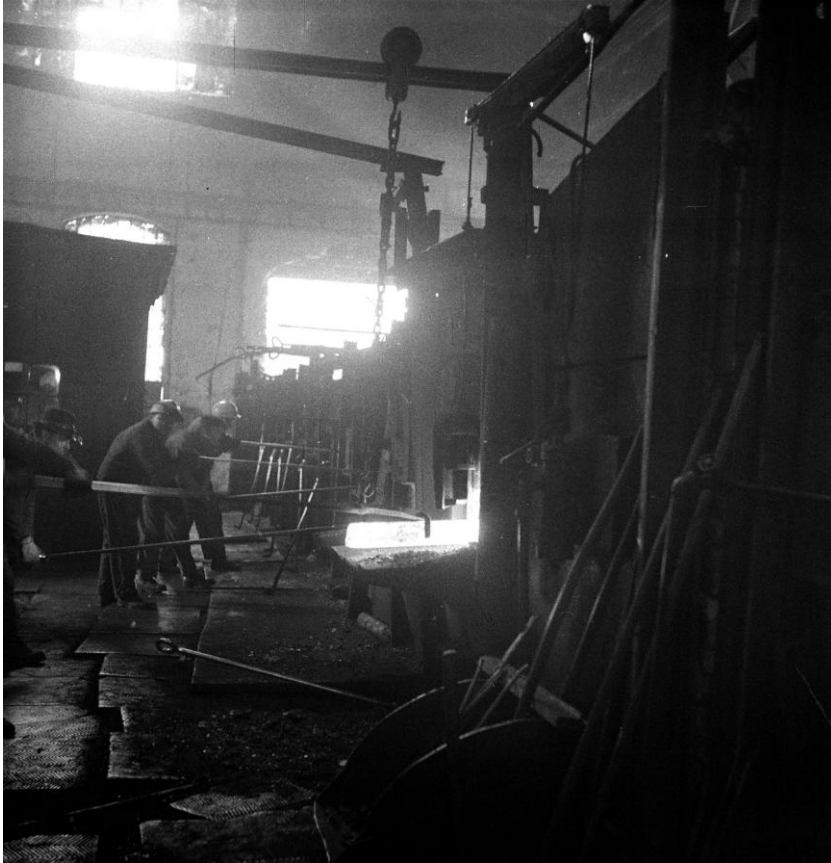
Obr. 41. podbrezovská ohrievacia, poguľovacia pec valcových predvalkov v rúrovni.
