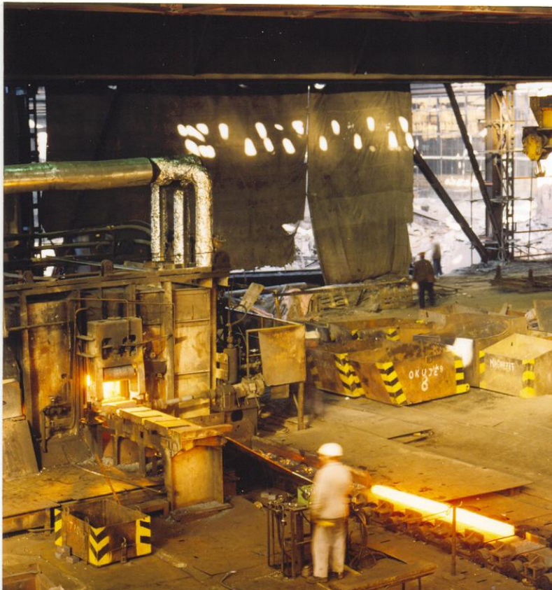
Obr. 42. Vyťahovací vrátek na výstupe narážacej ohrievacej pece podbrezovskej valcovne profilov.
