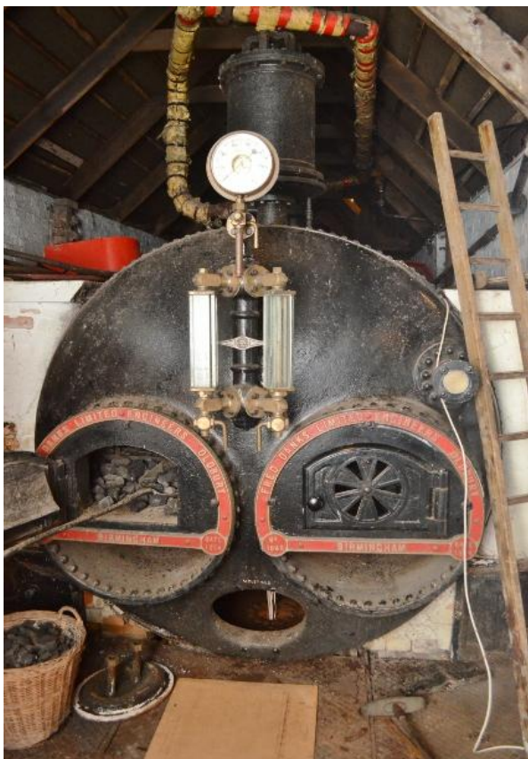
Obr. 31. Čelo parného kotla s dvojicou ohnísk s dvierkami na prikladanie, dvojicou vodoznakov uprostred a hore s manometrom. Tento „plamencový“ typ kotla dosahoval účinnosť 70%.
