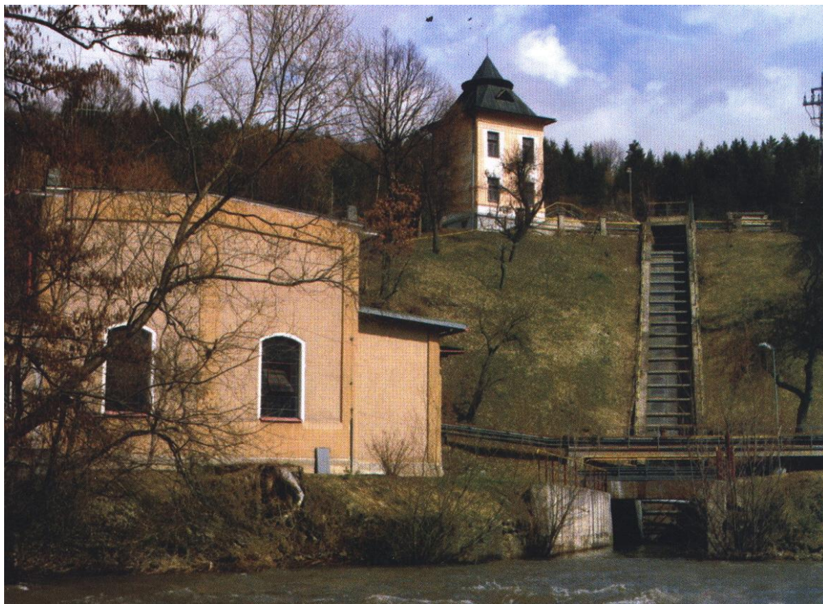
Obr. 118. Pohľad na objekt HC Dubová dole, hore je vežový objekt privádzača podzemného tunela a tlakového potrubia s prepádovým žlabom.
