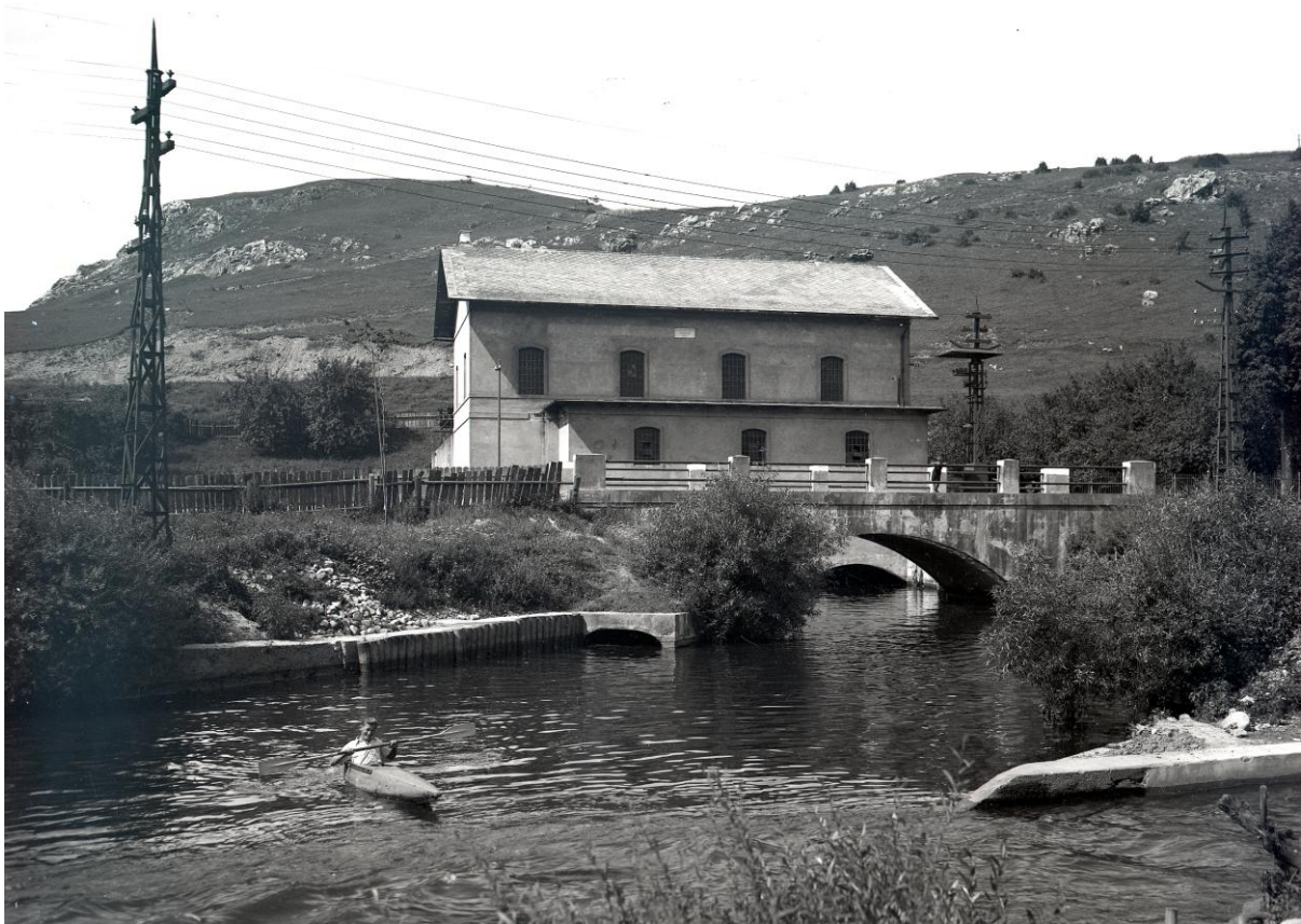
Obr. 105. Pohľad na Hydrocentrálu Lopej od Hrona.
