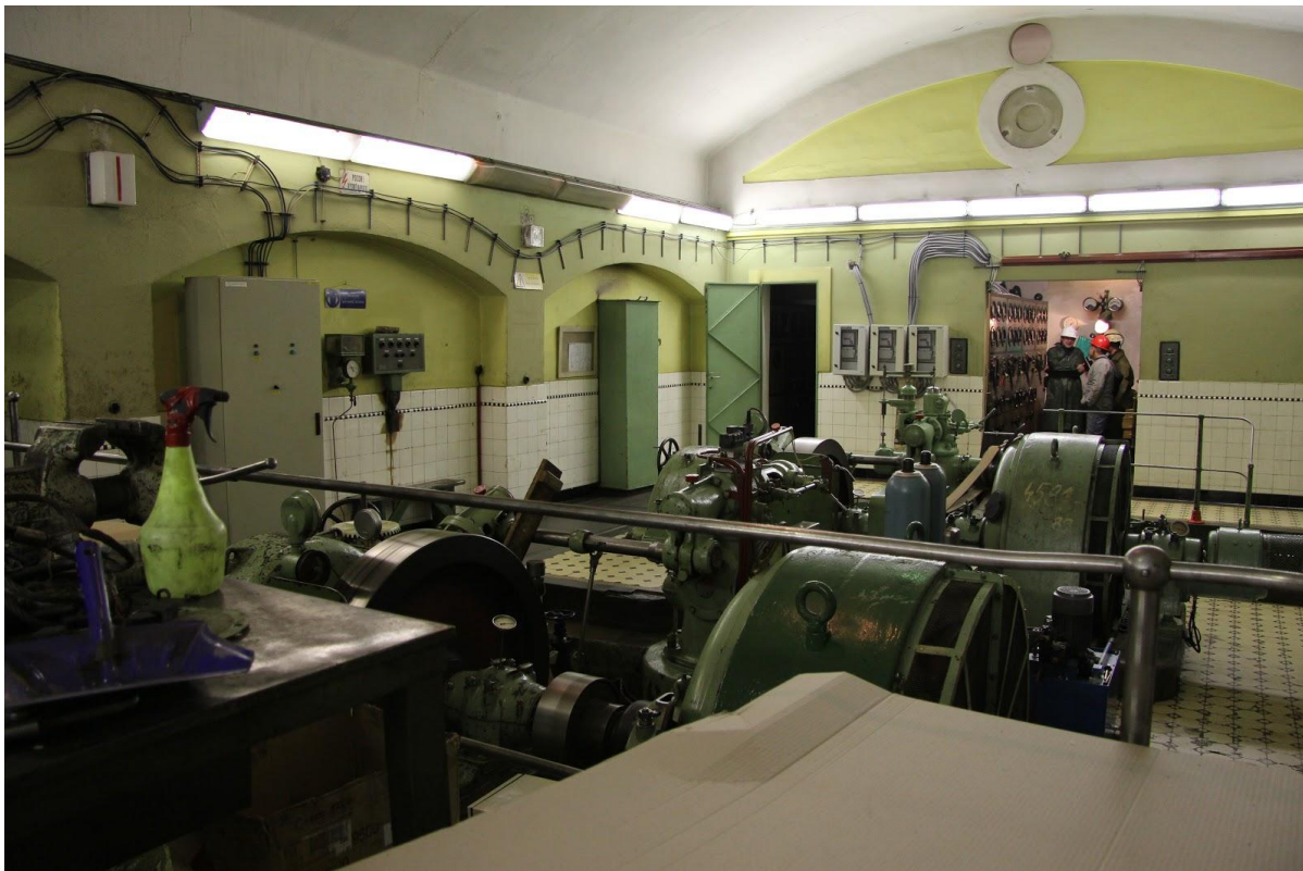
Obr. 124. Podzemná elektrárň v hĺbke 245 m postavená v roku 1912.
