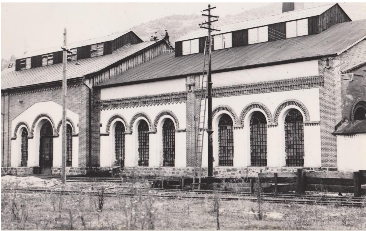
Obr. 16. Ocel'ovo-liatinový elektrický stĺp vyrobený v Piesku z komponentov ocelových rúr z Podbrezovskej prevádzky a častí z liatinových ozdobných prvkov z Hronca.
