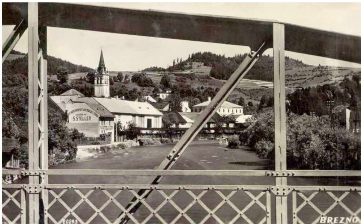
Obr. 97. Ocelový most spojovaný nitovaním vyrobený v piesockej mostárni.
