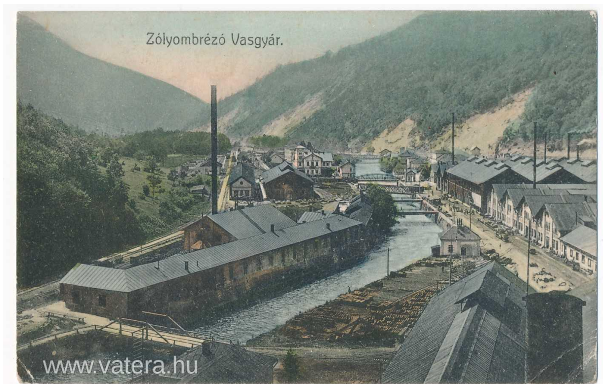
Obr. 109. Pohľad na železiareň Podbrezová (Zólyombrézó Vasgyár) smerom na B. Bystricu. Celkom vpravo stará rúrovňa, za ňou valcovňa plechov a vľavo za Hronom tehelňa na výrobu šamotových tehál. V pozadí železničná stanica Banská. Bystrica – Podbrezová z r. 1892.
