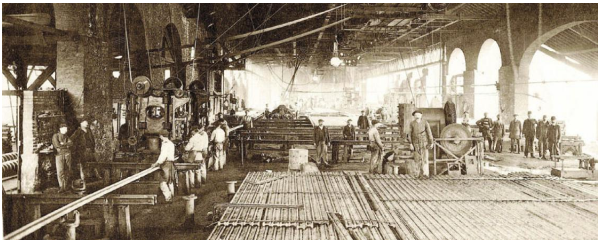
Obr. 112. Pohľad do dielne, kde sa koľajnice vyrovnávali a vŕtali do nich otvory.
