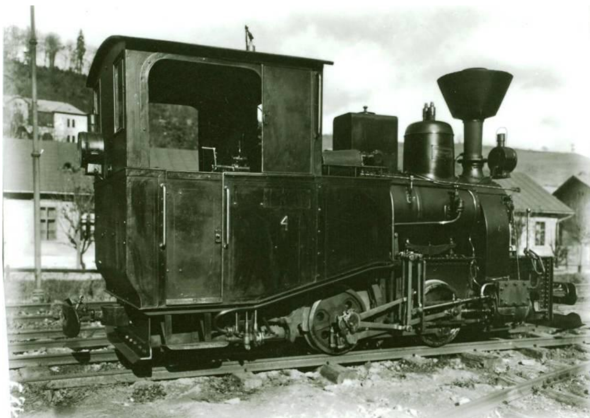
Obr. 98. Kachelmanka č.4. vyrobená v Piesku podľa predlohy troch zakúpených lokomotív v Kachelmanovej fabrike vo Vyhniciach v 70. rokoch 19. storočia.
