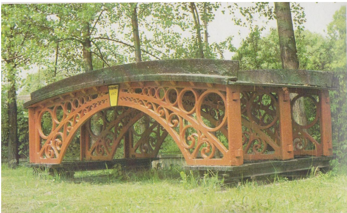
Obr. 10. Menší z trojice liatinových mostov odliatych v Hronci v roku 1810 ktorý sa zachoval.
