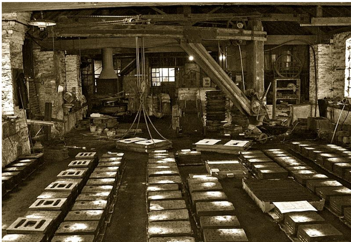
Obr. 36. Odlievacie pole s pieskovými formami v liatinových rámoch pripravených na odlievanie.
