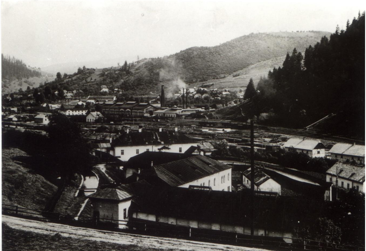
Obr. 39. Vpredu pohľad na zadný trakt lisovne s vodným kanálom a vtokovým objektom s francisciho turbínou v čele výrobných hál. V pozadí zlieváreň a smaltovňa.
