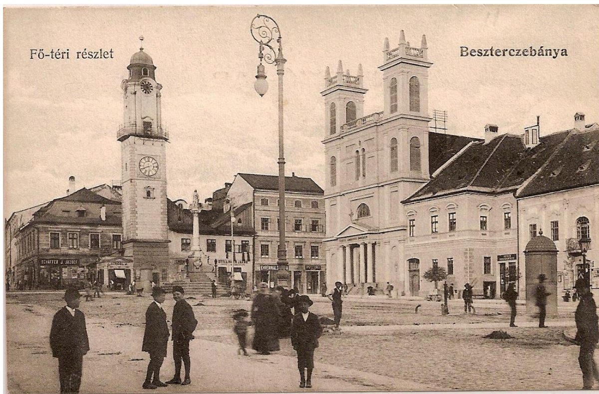
Obr. 17. ocel'ovo-liatinový elektrický stĺp upravený ako nosič elektrického oblúkového svietidla v mestách s ozdobným ukončením v tvare biskupskej palice. (B. Bystrica 1911).
