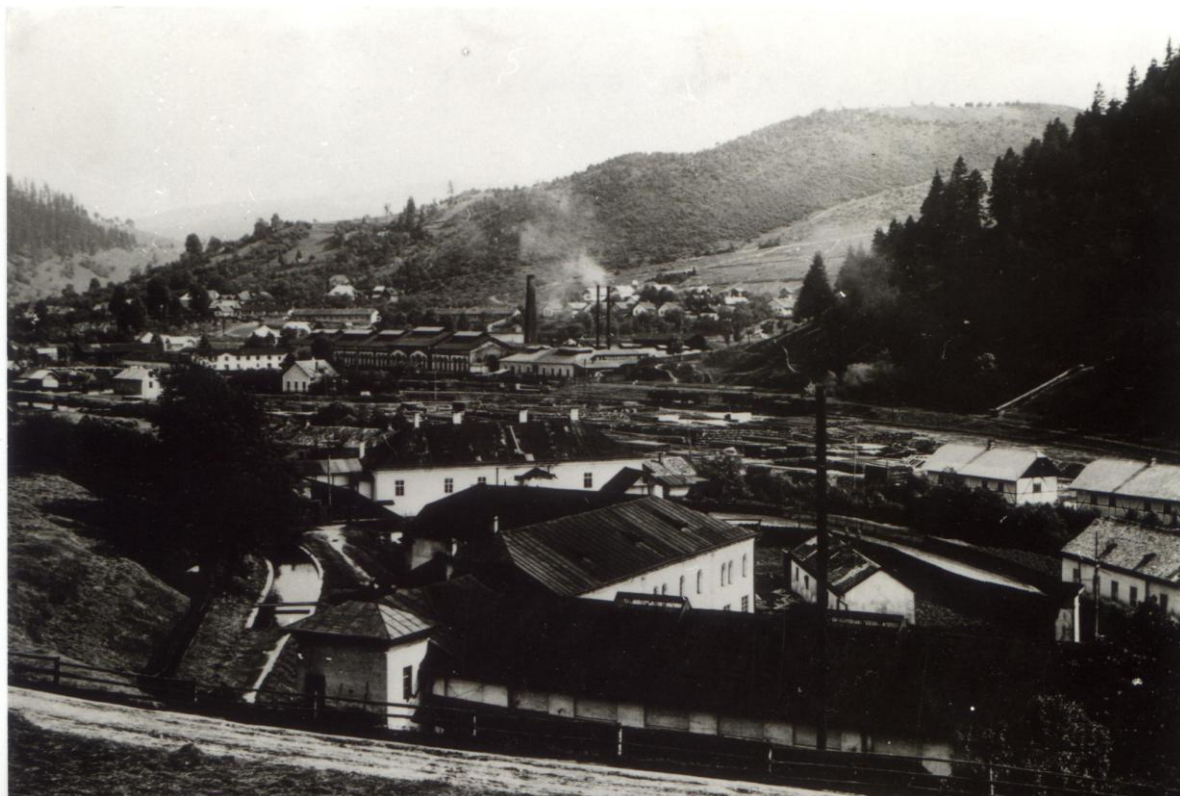
Obr. 17. Pohľad na lisovňu plechového riadu s vodným náhonom a vtokovým objektom vľavo dole. V pozadí drevosklad a za ním uprostred smaltovňa s dvojicou plechových komínov a vedľa vľavo hala zlievárne s ihlanovitým tehlovým komínom kotolne.
