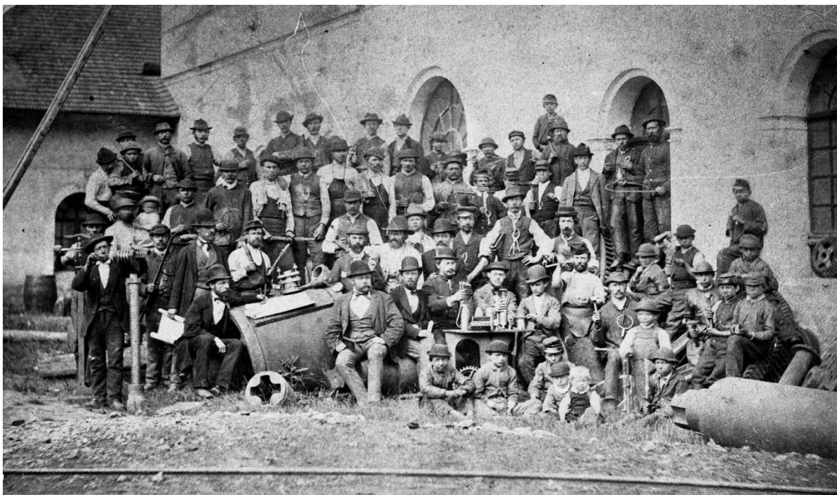
Obr. 7. Vzácný pohľad na objekt mechanickej dielne neskôr prestavanej na lisovňu plechového riadu.
