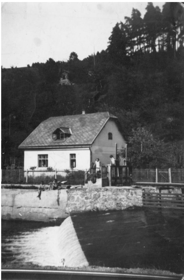
Obr. 19. Hať vodného náhonu pre lisovňu pod kostolom.
