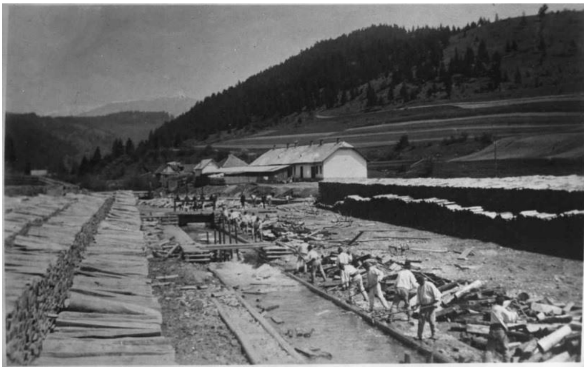
Obr. 35. Plavenie kľufového dreva v drevosklade nad valcovňou v Piesku. V pozadí robotnícka ubytovňa (šalanda) neskôr upravená na fabričné byty.
