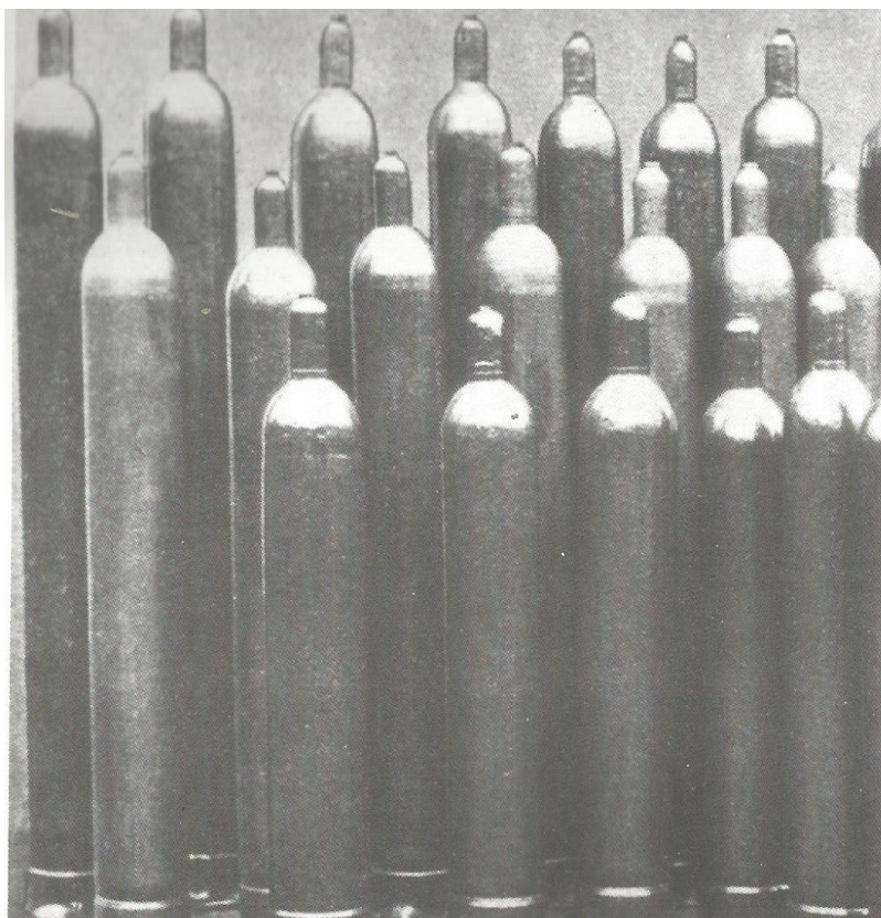
Obr. 52. Kyslíkové nádrže (flaše) vyrobené a plnené v Piesku..
