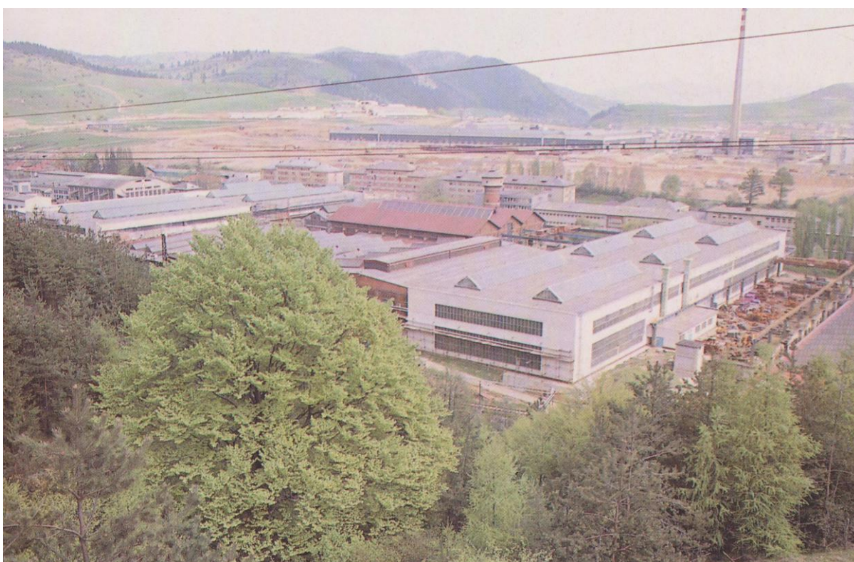
Obr. 67. Zadný pohľad na Strojárne Piesok. Staré haly – uprostred obostavané novými. V pozadí sa buduje Nový závod Švermových železiarní Podbrezová. V pozadí uprostred kóta Skalka 515 m n. m. kde sa v súčasnosti nachádza Hutnícky skanzen a za ním v údolí Hrona obec Valaská.
