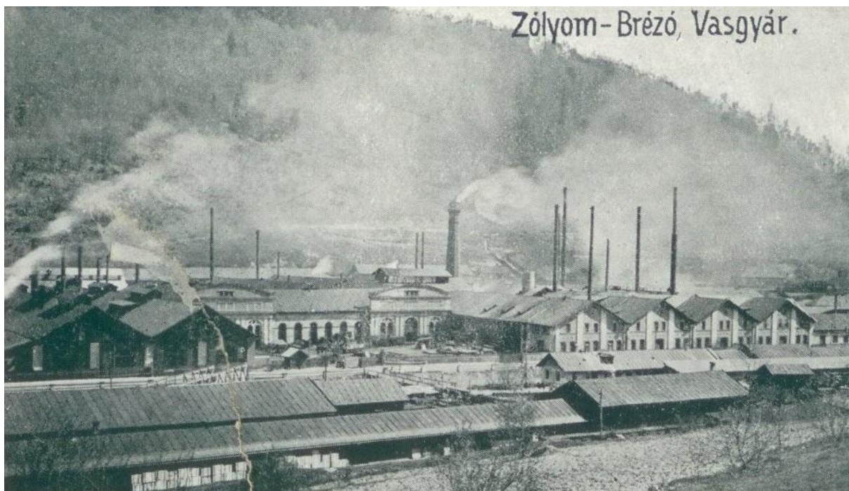
Obr. 77. Pohľad na Podbrezovskú železiareň po prvej prestavbe s valcovňou koľajníc vľavo a rúrovňou (tupozvarovňou a ťahárňou) vpravo. Prvá SM oceliaren sa nachádza v pozadí vo vysokej hale pred masívnym komínom. Celkom vpravo nízky objekt kováčskej dielne.
