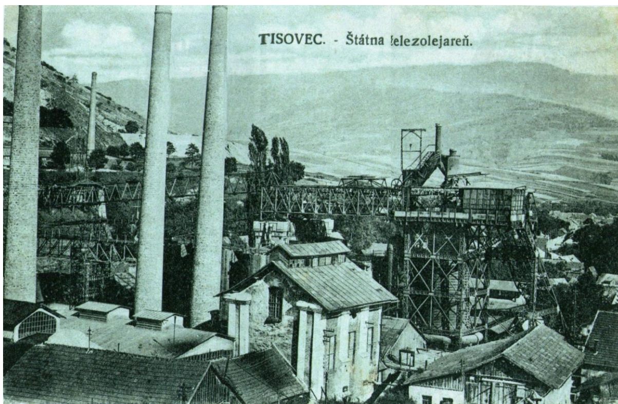
Obr. 121. Pohľad na hutu z opačnej strany. Vpravo tenkostenná vysoká pec v podpornej ocelovej konštrukcii s kychtovým lapačom kychtových plynov a celkom vpravo strojovňa kychtového šikmého výťahu. Vľavo horná kychtová lávka položená na starej murovanej výťahovej veži. Medzi komínmi vydieť starú ocelovú lávku medzi rudným dvorom a výťahovou vežou a nad ňou šikmá ocelová konštrukcia novej kychtovej lanovky.
