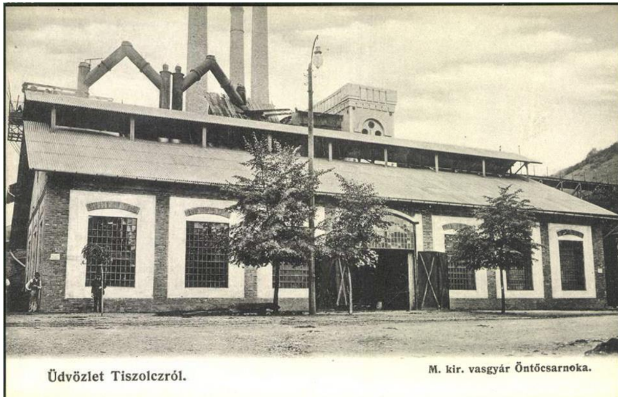
Obr. 119. Nová odlievacia hala na mieste starej. Za halou obe vysoké pece (zľava) s potrubím kychtových plynov, murovaná výtahová veža. V pozadí trojica komínov. Celkom vpravo oceľová lávka spájajúca hutný dvor s výtahovou vežou a kychtami pecí.
