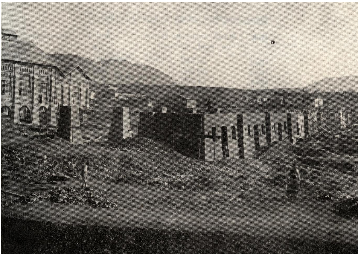
Obr. 42. Výstavba žeriavovej dráhy na Piesku.
