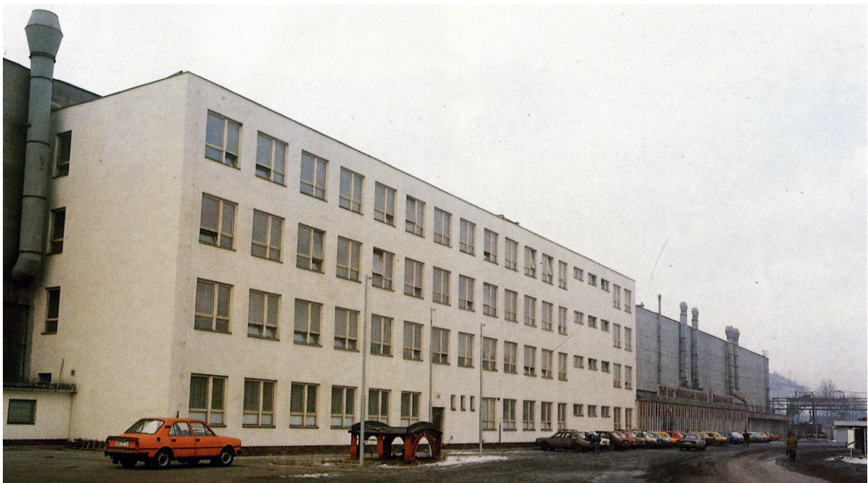
Obr. 29. Pohľad na nové priečelie modernizovanej zlievárne 80. rokoch 20. storočia. Pred administratívnou budovou je umiestnený liatinový most vyrobený v Hronci v roku 1810.
