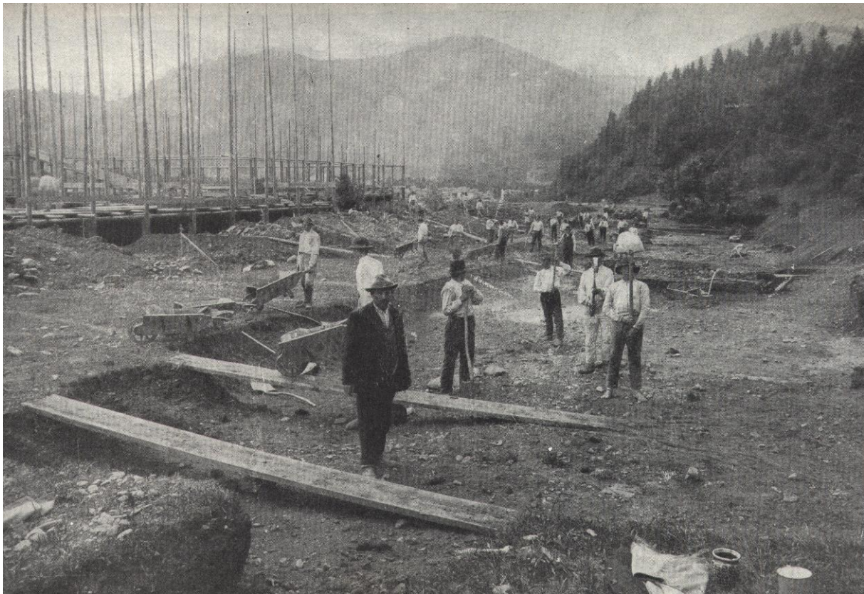
Obr. 40. Pohľad na Henriho závod vo výstavbe a výkope nového koryta Bystrianky.
