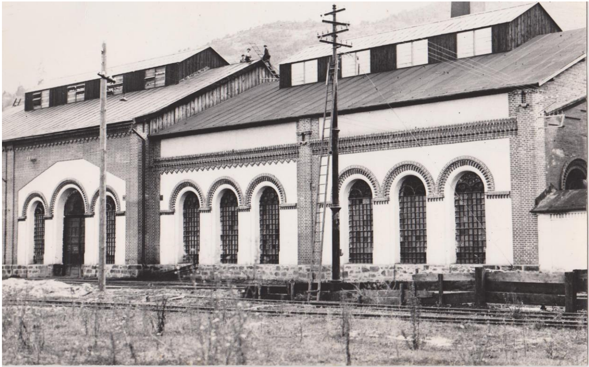
Obr. 9. Hala zlievarne po zrušení vysokých pecí z prelomu 19. a 20. storočia. V popredí ocelový stožiar vlastnej výroby elektrického vedenia z 500 m vzdialenej fabrickej elektrárne v prevádzke lisovňa plechového riadu.
