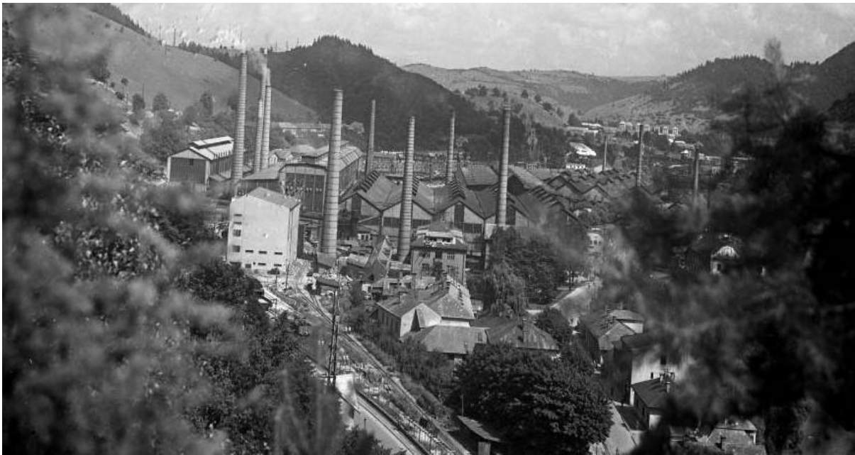
Obr. 106. Pohľad na starý závod pred rekonštrukciou.
