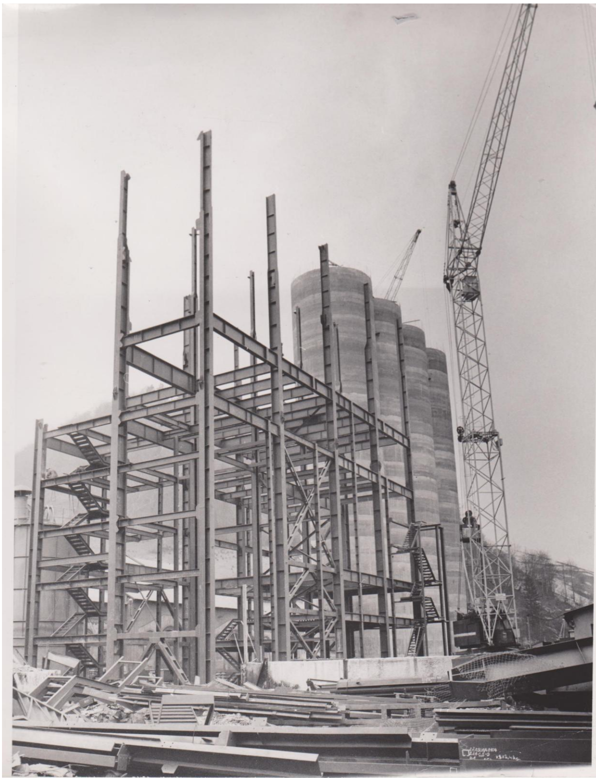
Obr. 27. Náročná stavba štyroch betónových sĺ pre uskladnenie piesku na formy s objektom mlyna na prípravu formovacej zmesi dnes stojí bez využitia, lebo piesok sa dodáva priebežne kamiónovou prepravou bez nezmyselných veľkokapacitných skladovacích priestorov. Piesku je dnes vo fabrike toľko, koľko ho fabrika dokáže zaplatiť a tak jeho prísun je dynamický, zodpovedajúci objemu výroby. Nadnormatívne zásoby piesku pre prípad vojny naplánované v čase socializmu prestali fungovať v nastúpenej tržnej ekonomike, preto zostali prázdne.
