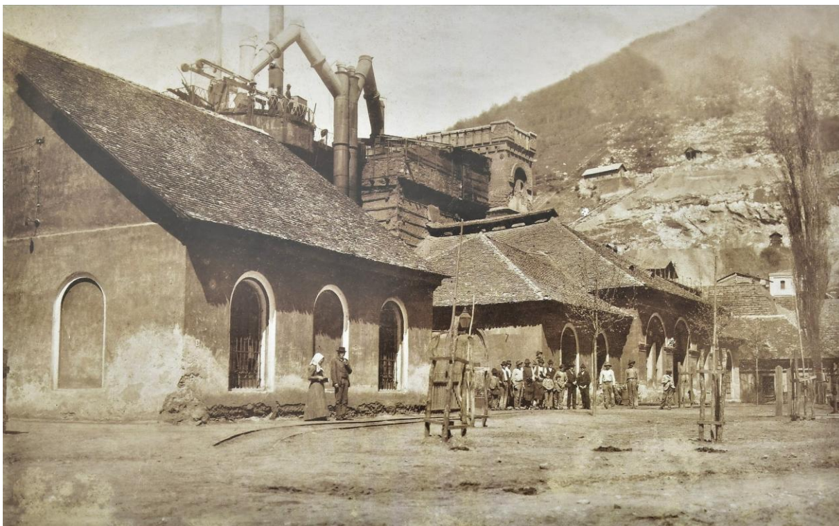
Obr. 117. Pohľad na starú hutu po s prvou pilierovou vysokou pecou uprostred. Neskôr k nej postavili druhú (stĺpovú) vysokú pec vľavo a výtahovú vežu (vpravo).
