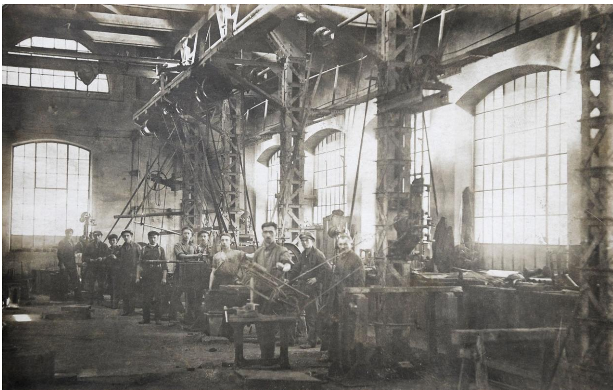
Obr. 125. Dielňa údržby v huti Tiovec s transmisiou k obrábacím strojom.
