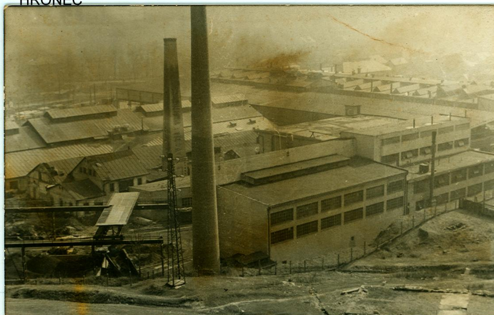
Obr. 23. Pohľad na areál starej fabriky so štvorbokým komínom (vľavo) a novej fabriky (vpravo) s novým komínom v popredí pri centrálnej kotolni a žeriavovej dráhe skladu uhlia.
