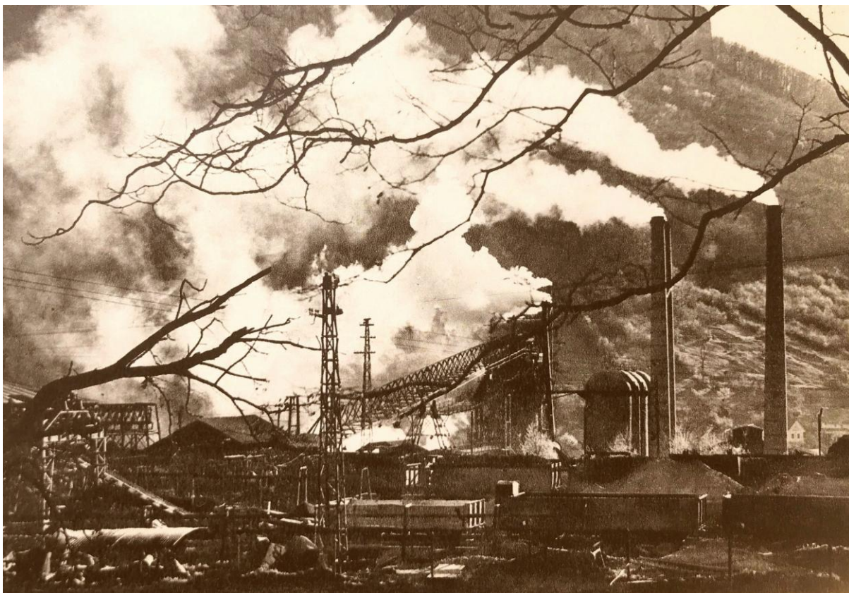
Obr. 124. Huta pred zrušením. Vpravo trojica murovaných komínov, pri nich batéria ohrievačov vetra a uprostred vysoká pec s kychtovou lanovou dráhou z hutného dvora. Celkom vľavo portálový žeriav po zrušení prenesený do Švermových železiarní na RP sklady.
