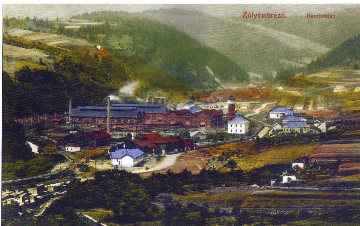
Obr. 54. Celkový pohľad na Henriho závod v Piesku. Za bielou budovou robotníckej ubytovne (šalandy) vpredu vľavo je starý hámor s valcovňou a vľavo od nej dvojloďová hala zvarovne rúr s komínom, prenesenej z podbrezovskej starej rúrovne. V pozadí Henriho závod s bielou administratívnou budovou a vodárňou. Celkom vľavo dole sklad reziva štátnej pily v Štiavničke. Vľavo hor biely vtokový objekt vodnej elektrárne za Henriho závodom.
