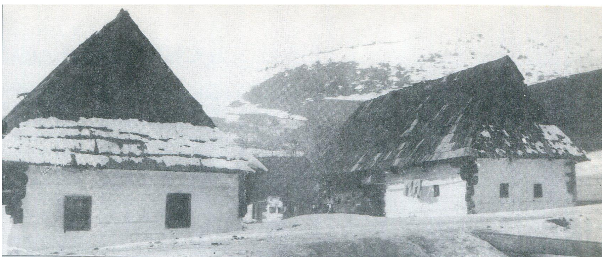
Obr. 52. Drevenice v uličnej zástavbe Valaskej z 18. storočia dochované do začiatku 20. storočia keď boli fotografované. Malé okná do ulice sú typickým znakom obydli chudobných roľníkov. Polvalbové strechy so strmím sklonom bez komína reprezentujú najstaršiu zástavbu obce.
