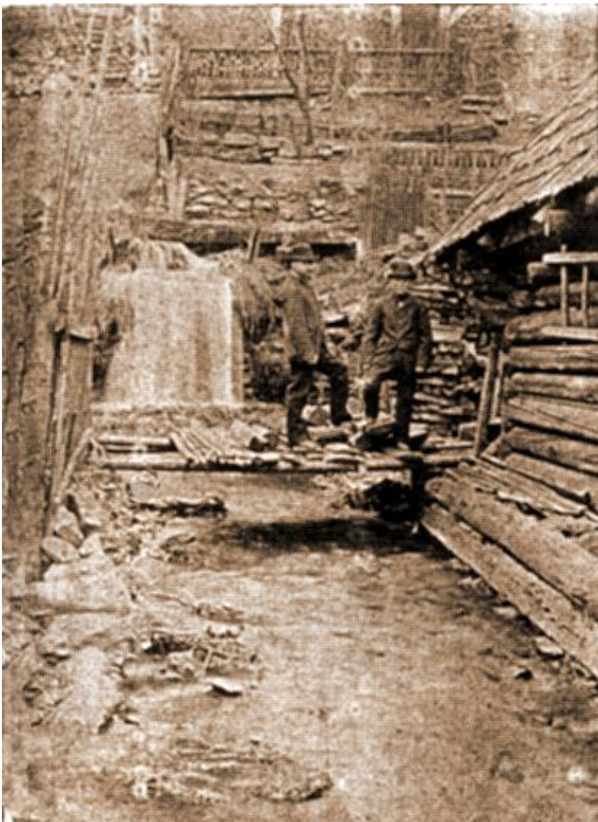
Obr. 32. Vodný prepad náhonu (frúdle) medzi maštale a sklady drevného uhlia pre železiareň poniže.
