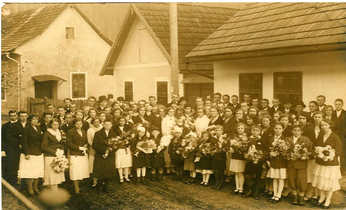
Obr. 30. Časť zástavby Mlynskej ulice pri obecnej bujačiarni z obdobia prvej ČSR. Po rozšírení cesty a zasypaní vodného náhonu. Časť sanitačného prietoku zostal v podzemnom potrubí so šachtami odvádžajúcimi povrchové vody a splašky až do Čierneho Hrona.
