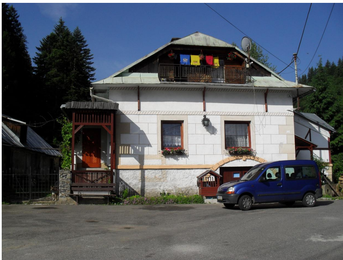
Obr. 27. Súčasný vzhľad bývalého komorského mlyna. Vľavo dole pod terajším oknom je vyznačené ostenie pôvodného okna zamurovaného pri prestavbe na byt začiatkom 20. storočia, ďalšie zanikli vložением garážovej brány v roku 1976.
