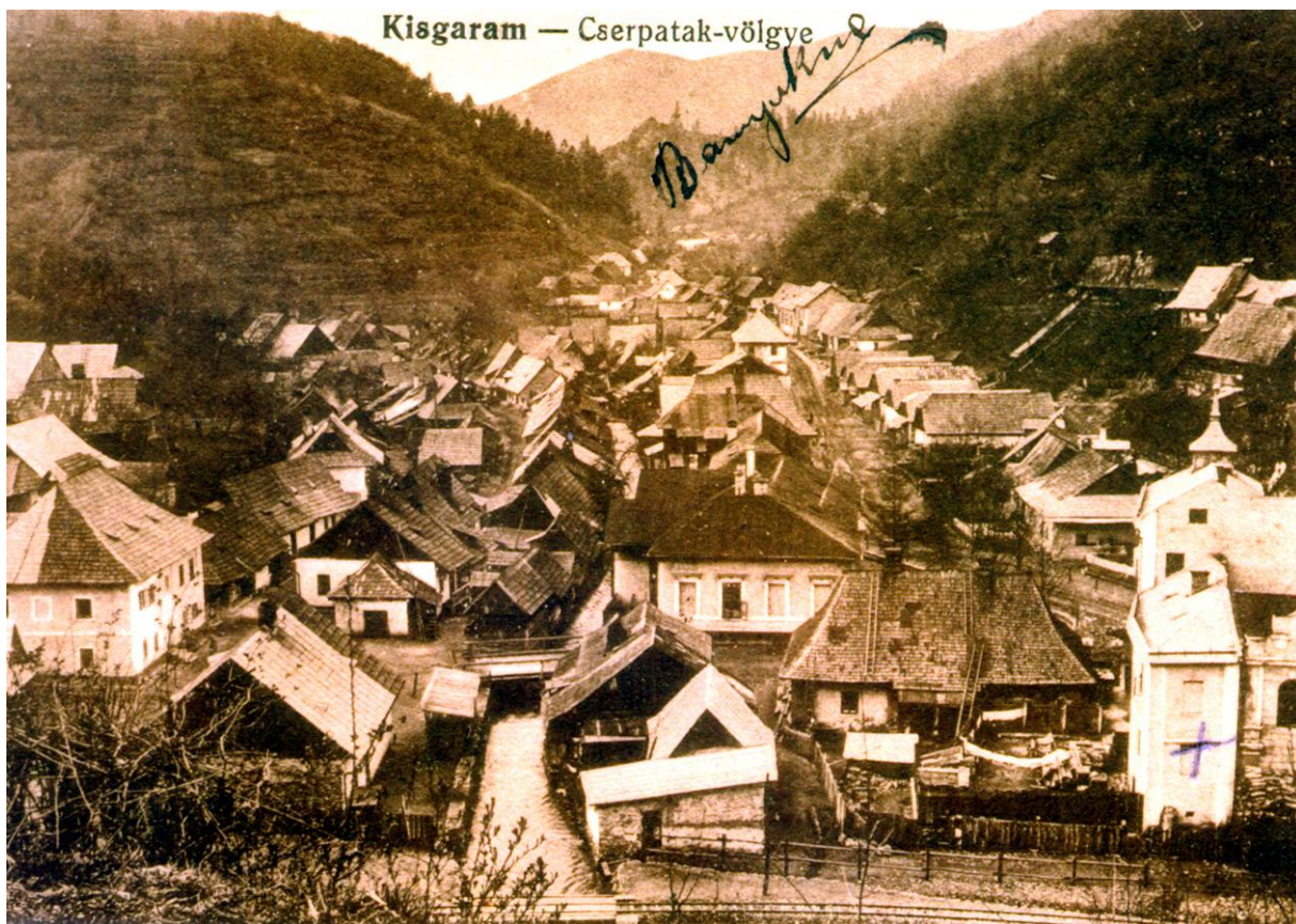
Obr. 39. Fotografia zo začiatku 20. storočia najstaršej zástavby Hronca Mlynskej ulice a robníckej kolónie „Žabiareň,, (Stredná ulica) po zrušení Horného uhliarstva koncom 18. storočia. Celkom vľavo za dvojpodlažnou kamennou budovou sa nachádzajú dvojpriestorové drevenice z ročením na stropnej hrade r. 1783. obe drevenice zhoreli pri požiari v r. 2008. Pri moste ponad Osrbliansky potok sa nachádza murovaný sklad oleja a loja pre svietenie v baniach a hutách. Neskôr tu postavili obecnú požiarňu zbrojnicu.
