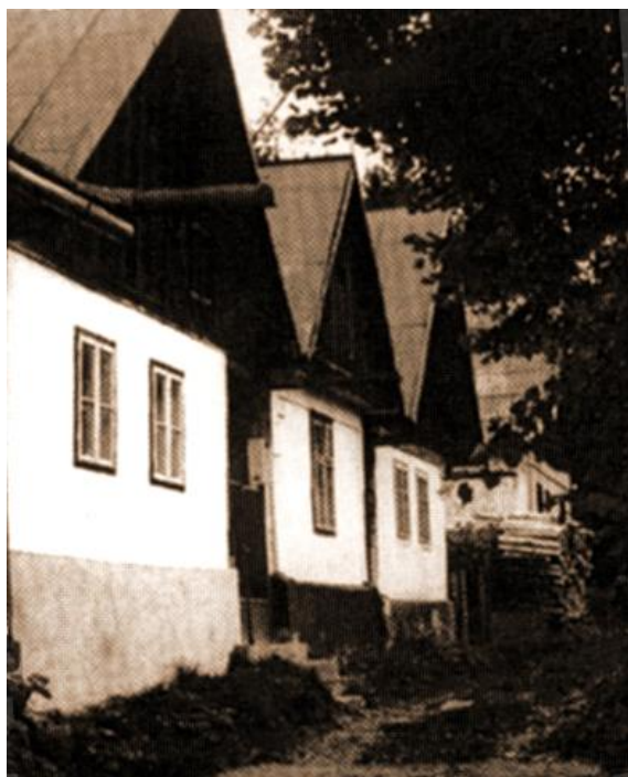
Obr. 36. Časť baníckych domčekov v Tirolskej ulici pod Vtáčnikom z 18. storočia. Pôvodne zrubové neskôr omietnuté a často prestavané na pôvodných základoch alebo pospojovaním do väčších domov. Opačnú stranu ulice zastavali drevárňami a hospodárskymi stavbami.
