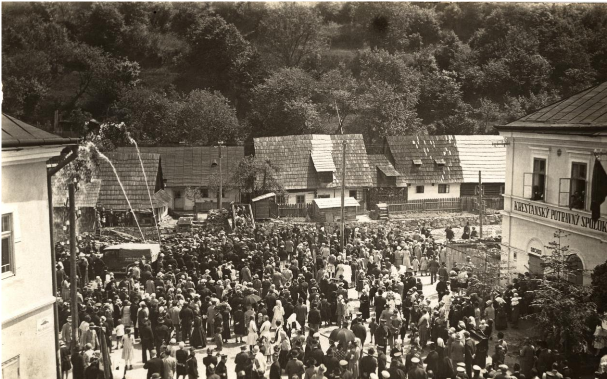
Obr. 40. Pohľad na námestie (Plac) Hronca. Vľavo je roh obchodu a krémy židovského obchodníka, vpravo roh budovy kresťanského potravného družstva v bývalom zájazdnom hostinci.
