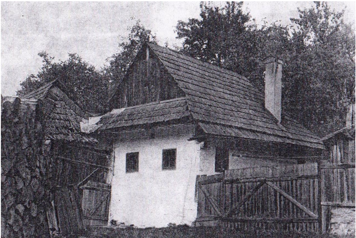
Obr. 8. Novší jednopriestorový zrubový dom s hlinenou omietkou a komínom z konca 19. storočia.
