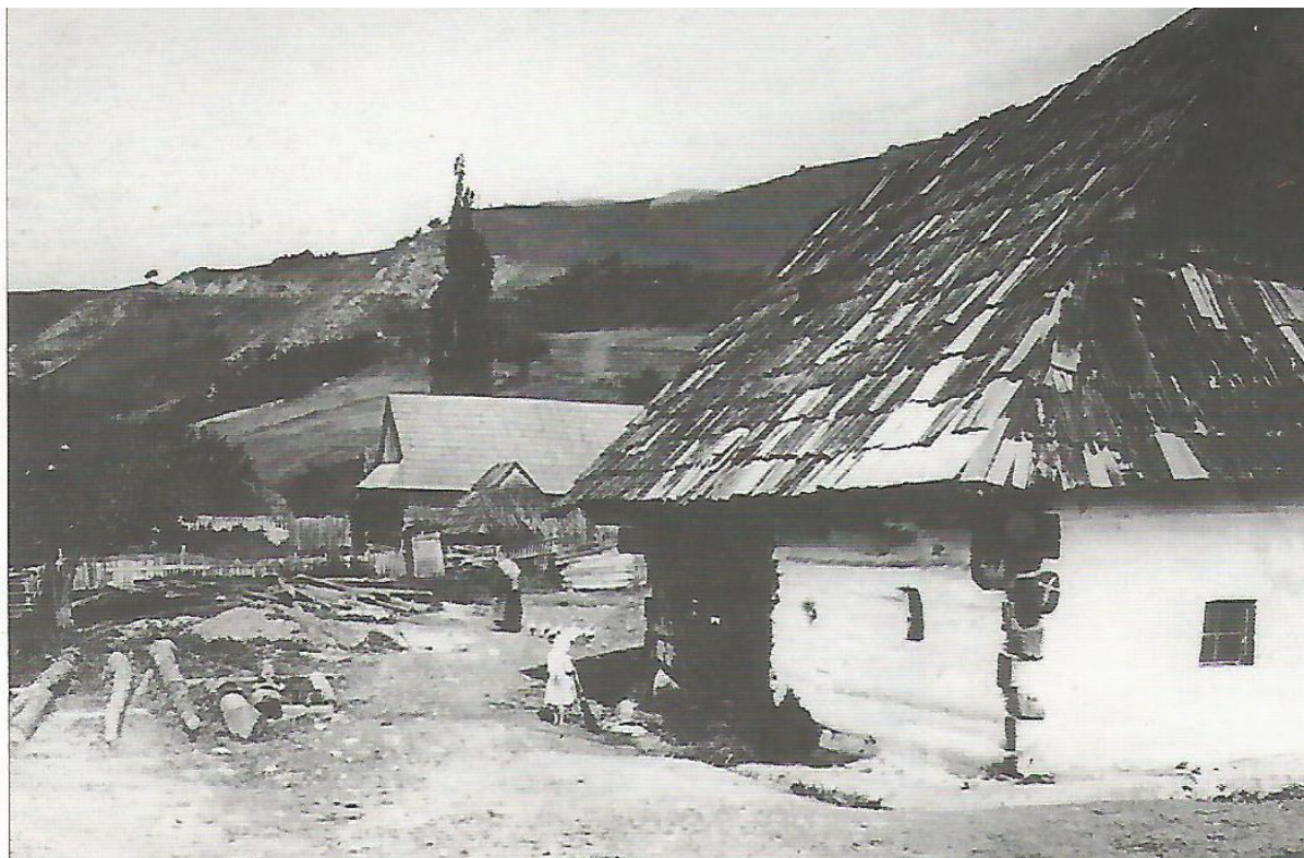
Obr. 47. Pohľad z ulice do dvora usadlosti vo Valaskej. V pozadí hore zárez župnej hradskej vedúcej k rázcestiu pri Skalke (dnes hutnícky skanzen). Celú ulicu po oboch stranách zastavali dvojpriestorovými drevenicami chudobných poddaných bez oplotení dvorov.
