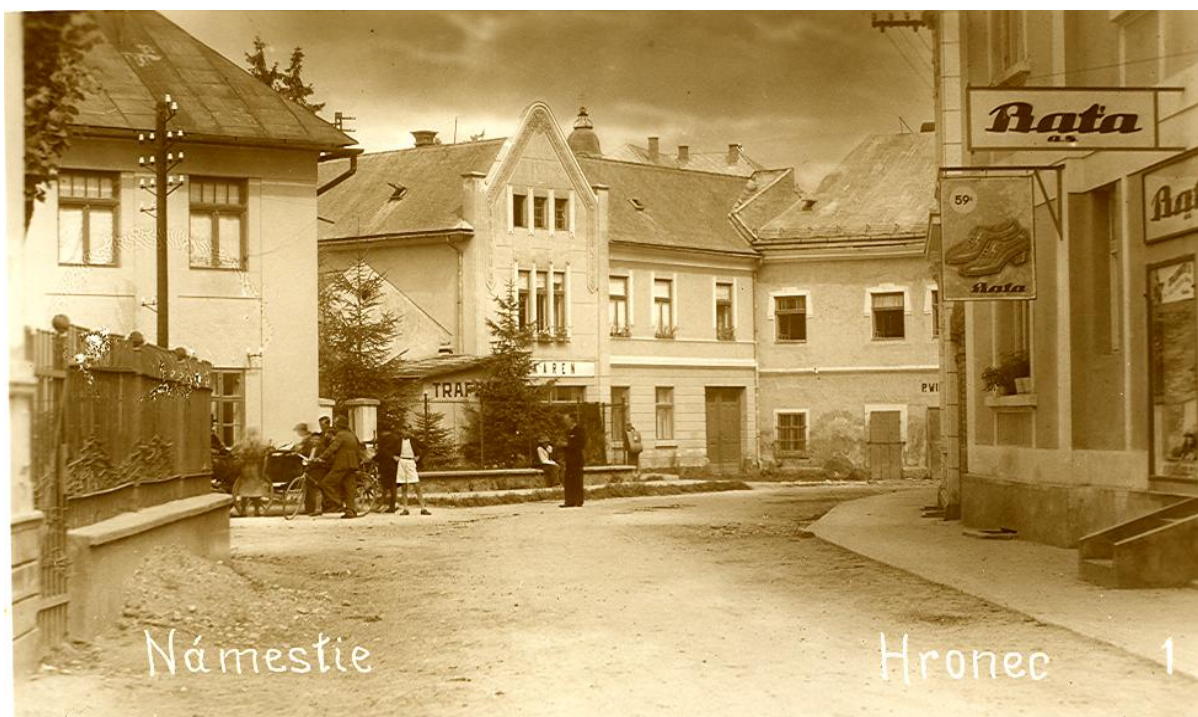
Obr. 93. Námestie v Hronci z 30 rokov 20. storočia. Vľavo obecný dom s bytom notára, v pozadí secesný dom lekárnik v rohovej spojnici s hostincom, obchodom a bytom židovského obchodníka Windholza s už novým ostením okenných rámov na poschodí.
