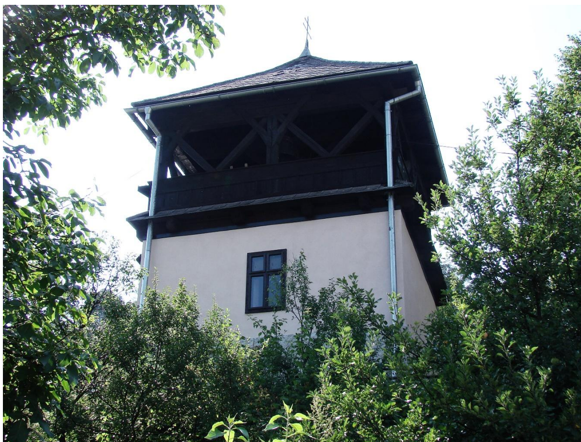
Obr. 22. Zvonica s bytom zvonára v súčasnom čase postavená v r. 1843 namiesto starej z r. 1602, postavenej vyššie v lokalite „Na Bráne,,so vstupom do železného handlu Hronicz.
