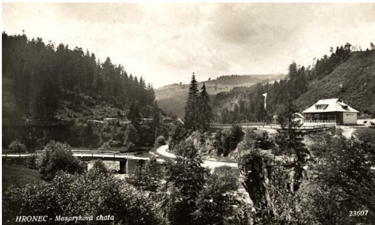
Obr. 86. Chata turistov na Sv.Jáne z 30. rokov 20. storočia pri sútoku Čierneho Hrona a Hrončoka powyše zaniknutého vodného tajchu „Špertajch,, s vybudovaným cestným mostom a železničným viaduktom lesnej železničky (celkom vľavo uprostred) 20 km dlhej odbočnej trate Kamenistou dolinou do sklárskej osady Sihlá. V popredí vpravo skalné bralo vystupujúce z riečiska Čierneho Hrona. Fotené so železničnej trate lesnej železničky.
