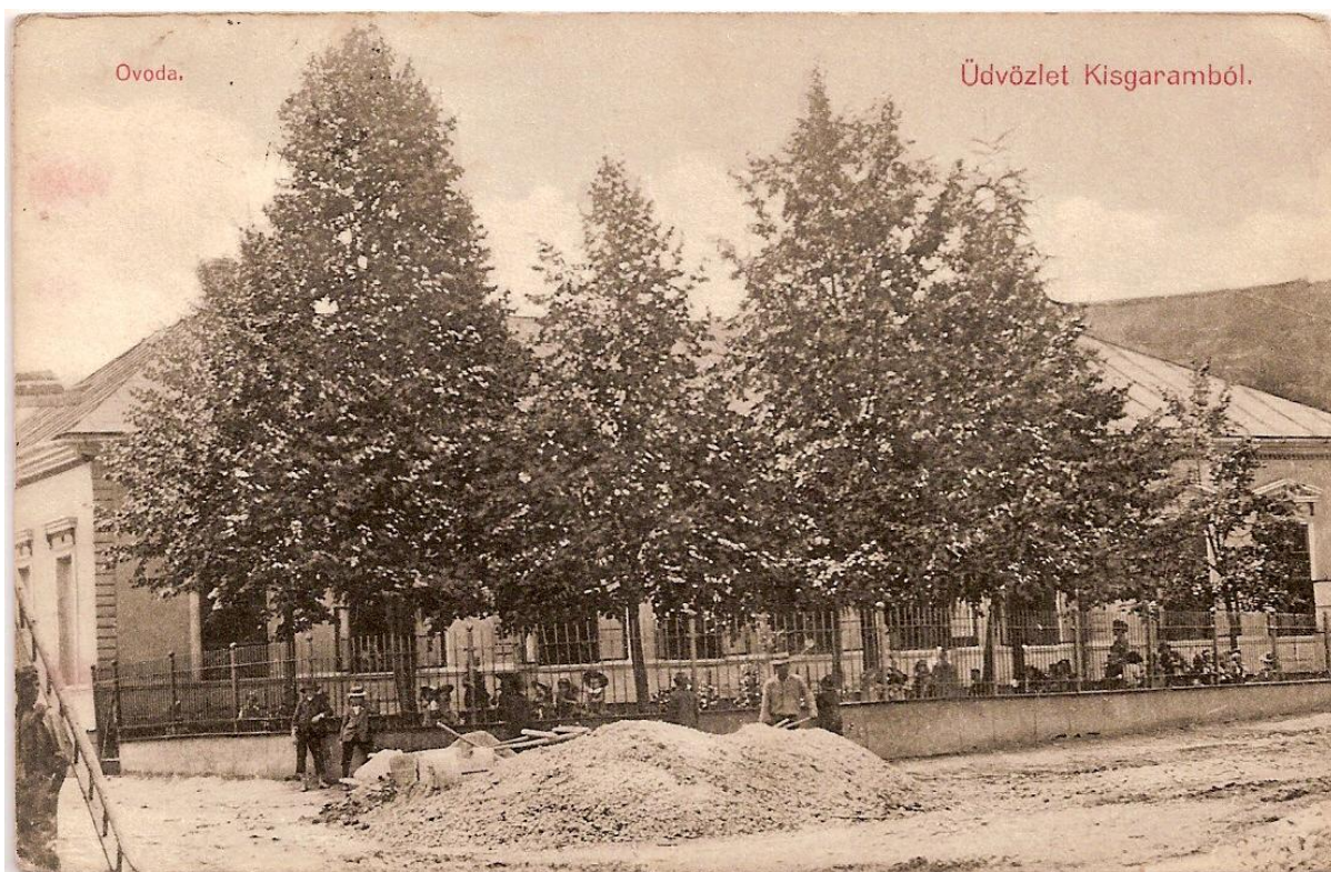
Obr. 97. Priečelie detskej dennej opatrovne (dadov) predchodca materskej škôlky na námestí v Hronci so záhradou tienenou stromoradím plnej hrajúcich sa detí.
