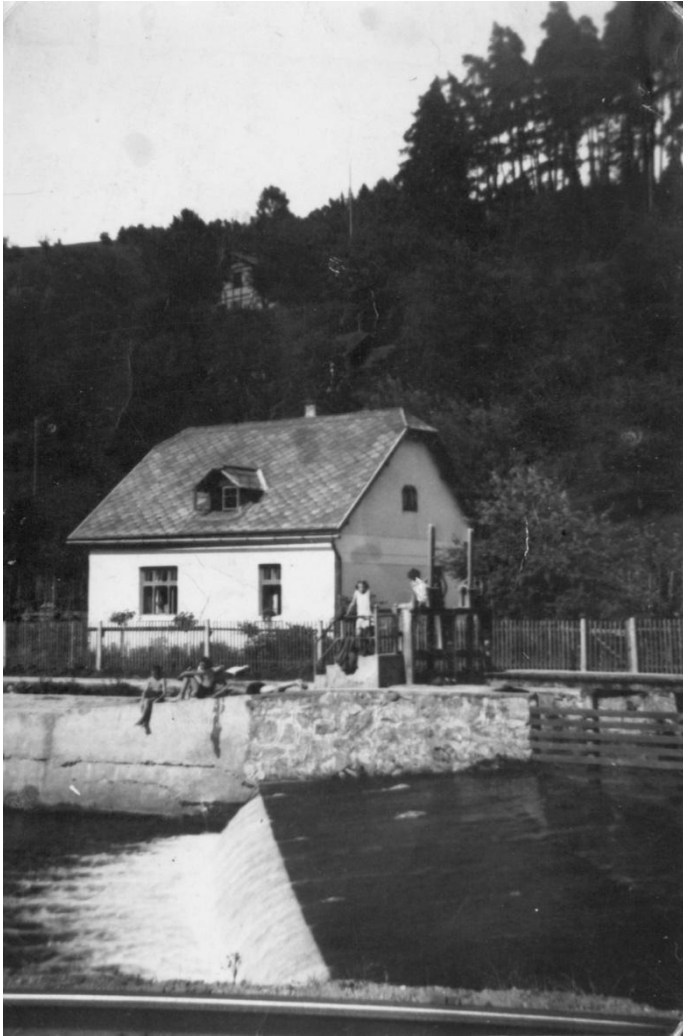
Obr. 27. Pohľad na opravenú hať. V pozadí konštrukcia stavidiel vodného náhonu a dom 20. storočia.
