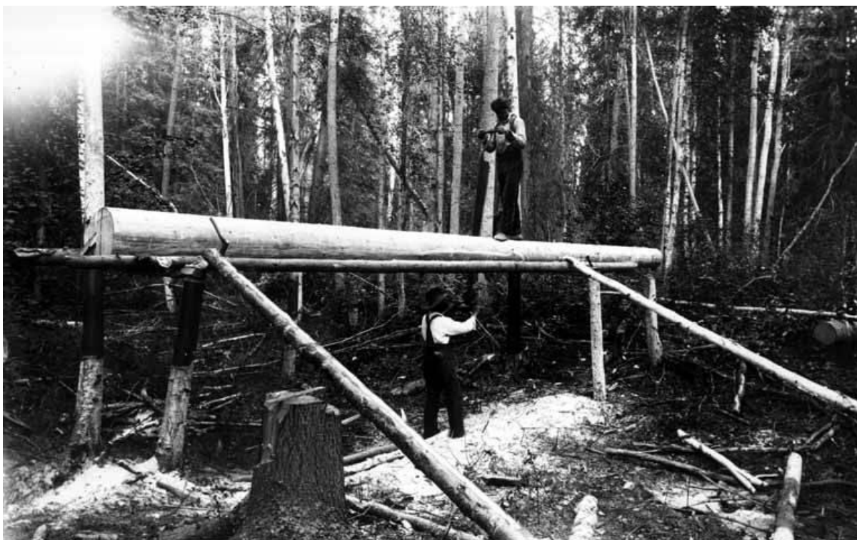
Tesárske remeslo v dávnych dobách sa nezaobišlo aj od náročného ručného rezania dosák. Neskôr túto namáhavú prácu prebrali vodné pily.
