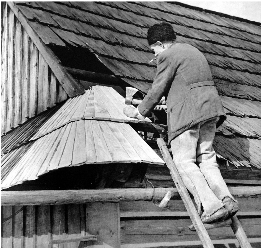
Oprava šindľovej strechy.
